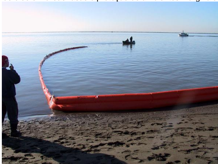
Figura 12-7 – Exemplo de uso de barreiras absorventes (tipo shore boom ) para confinamento de manchas de óleo em áreas rasas e proteção de ambientes marginais sensíveis.
