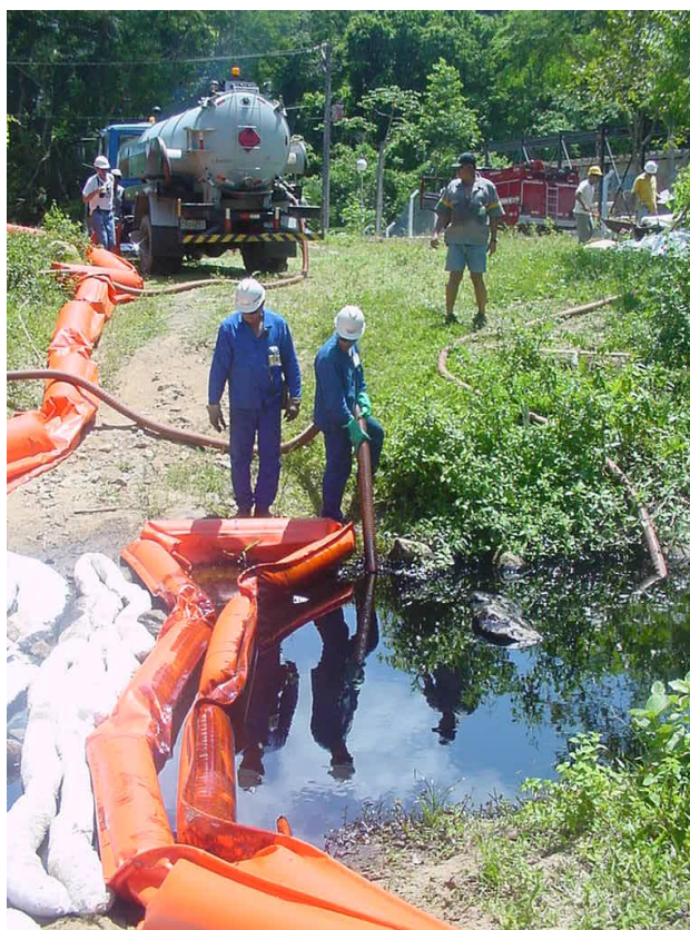
Figura 12-9 - Caminhões-vácuo em operação de remoção de óleo em corpo d'água
