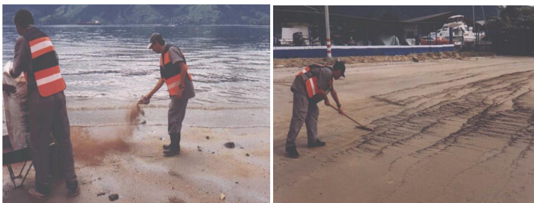
Figura 12-20 – Aplicação de turfa vegetal sobre o óleo remanescente e posterior recolhimento
