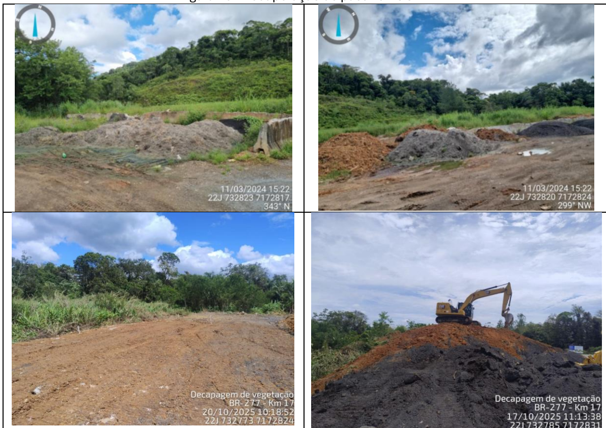
Figura 15 - Recuperação de passivo - UOP 2
