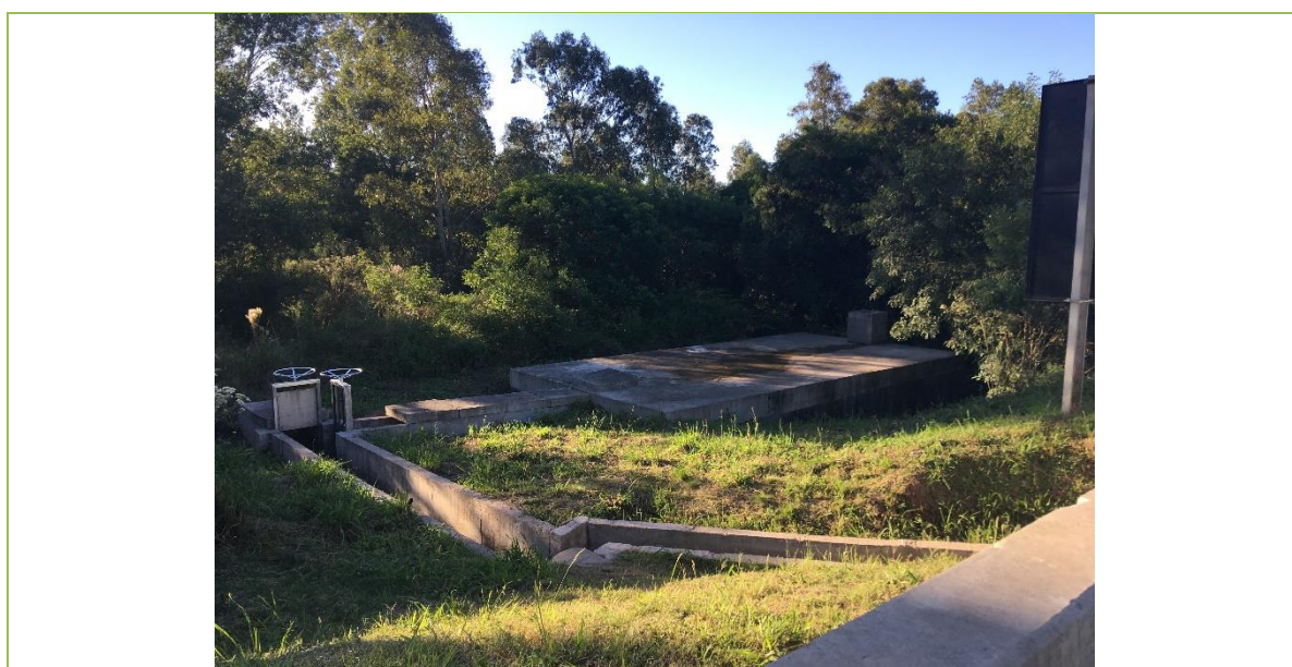
FIGURA 23— SISTEMA DE RETENÇÃO/CONTENÇÃO PRÓXIMO A BARRAGEM DE SANTA BÁRBARA FONTE: ECOSUL, 2019.
