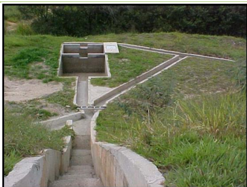
FIGURA 21—EXEMPLO DE SISTEMA DE RETENÇÃO/CONTENÇÃO DA RODOVIA DOS BANDEIRANTES FONTE: DER-SP,2008.
