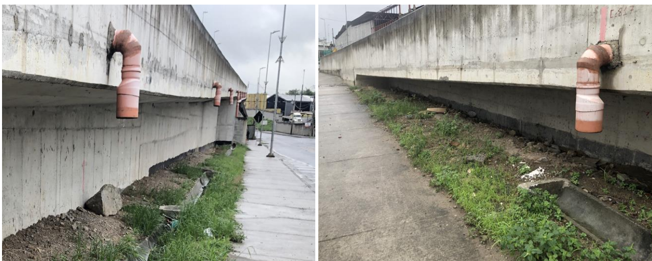
Figuras 5 e 6. Encerramento do Passivo após requalificação da drenagem.
