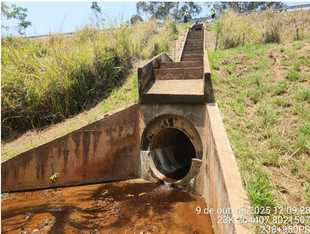
Figura 11 - Travessia de fauna no Km 238+950.
