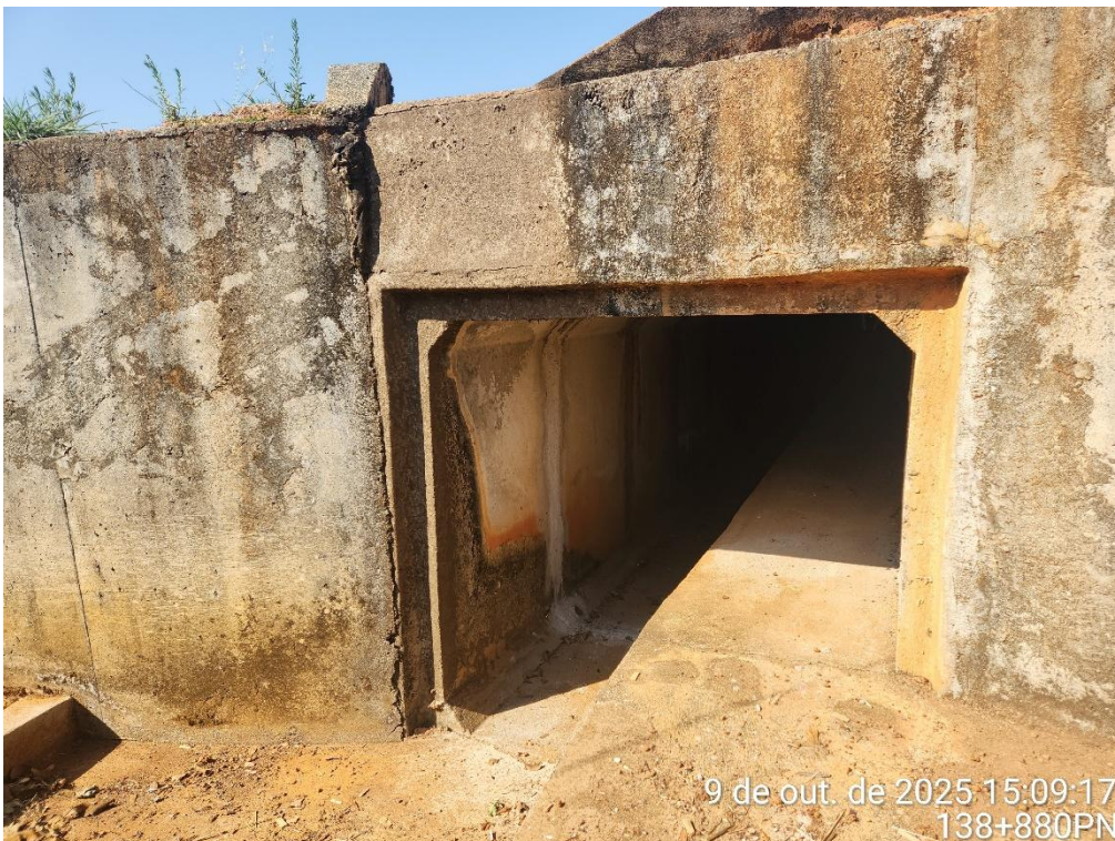
Figura 9 - Travessia de fauna no Km 138+880.
