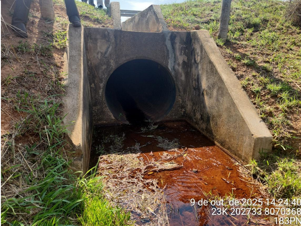
Figura 10 - Travessia de fauna no Km 183.
