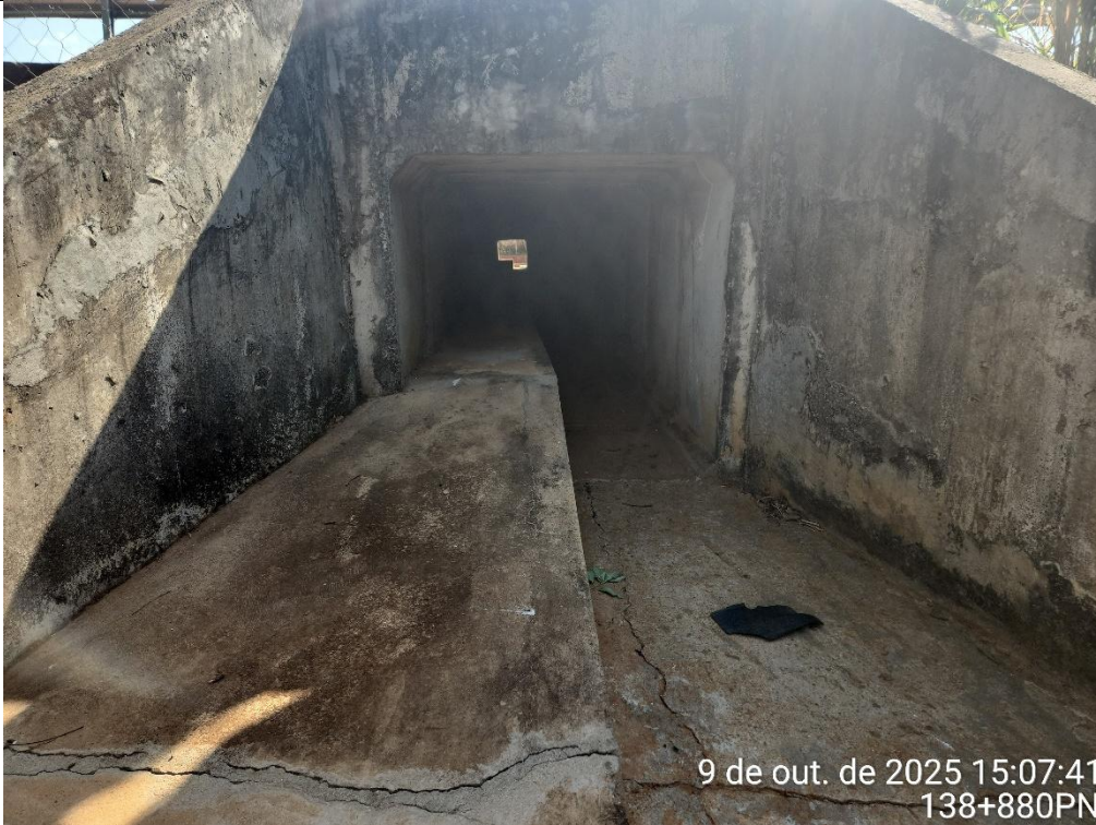
Figura 8 - Travessia de fauna no Km 138+880.
