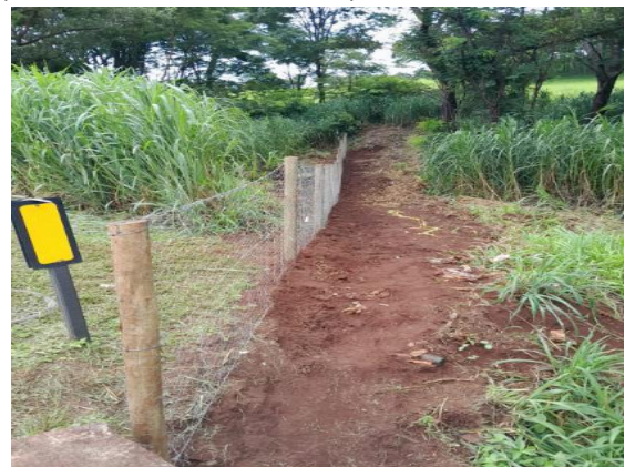
FIGURA 60 – INSTALAÇÃO DE CERCAMENTO PARA DIRECIONAMENTO DA FAUNA SILVESTRE, BR-262/MG; KM 792+900/LESTE. (FONTE: TRIUNFO CONCEBRA).
