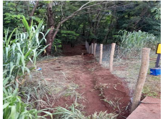
FIGURA 58 – INSTALAÇÃO DE CERCAMENTO PARA DIRECIONAMENTO DA FAUNA SILVESTRE, BR-262/MG; KM 792+900/LESTE. (FONTE: TRIUNFO CONCEBRA).
