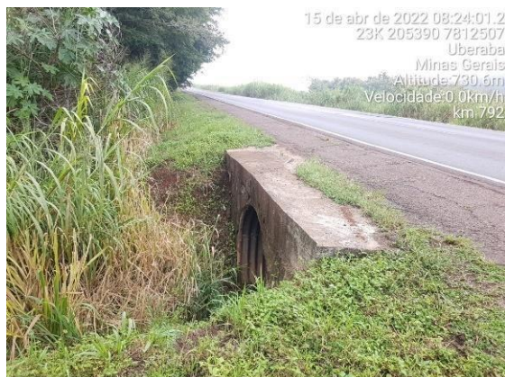
FIGURA 50 – GALERIA DE DRENAGEM AVALIADA COM CONDIÇÕES PARA PASSAGEM DE FAUNA. BR-262/MG; KM 792, EM 15 DE ABRIL DE 2022 (COORDENADA UTM 23K, 205390 E/ 7812507 S) (FONTE: TRIUNFO CONCEBRA).
