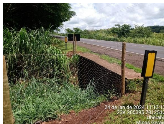
FIGURA 64 – TELAS DE PROTEÇÃO À FAUNA SILVESTRE. BR-262/MG; KM 792+367, EM 24 DE JANEIRO DE 2024 (COORDENADA UTM 23K, 205395 E/ 7812512 S) (FONTE: TRIUNFO CONCEBRA).
