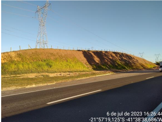
Figura 17: Plano geral para o bordo da Rodovia BR 101/RJ, em sentido norte, no km 110+100, com vistas para talude de encosta, evidenciando a conclusão das obras de recuperação de sinistro, com implantação de drenagem de crista, retaludamento e recuperação da cobertura vegetal. Fonte: Concremat Ambiental.
