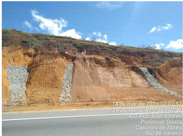
Figura 21: Visada frontal para talude de encosta às margens da Rodovia BR 101/RJ, no km 198+000, pista sul, evidenciando a execução de obras para estabilização de terrapleno para recuperação de sinistro. Fonte: Concremat Ambiental.
