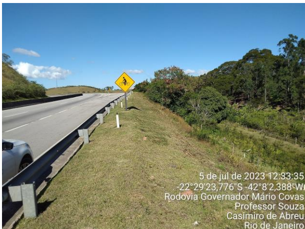
Figura 23: Plano geral para o bordo da Rodovia BR 101/RJ, no km 198+800, pista norte, com vistas para talude de aterro da rodovia, evidenciando a instalação de marcos superficiais para monitoramento do terrapleno. Fonte: Concremat Ambiental.
