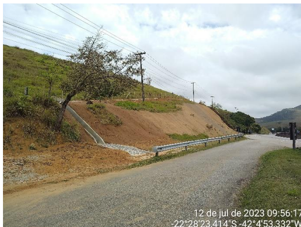
Figura 19: Plano geral para o bordo da Rodovia BR 101/RJ, em sentido norte, no km 192+000, com vistas para talude de encosta, evidenciando a conclusão das obras de recuperação de sinistro, com implantação de drenagem de crista, reconformação do terraplano, instalação paliçadas de madeira, bermas longas e recuperação da cobertura vegetal. Fonte: Concremat Ambiental.
