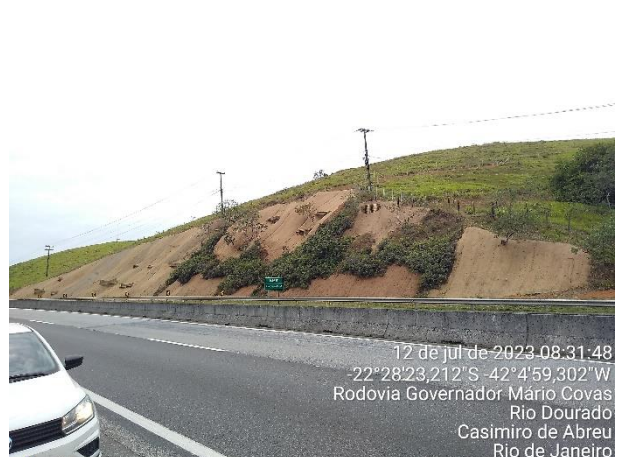
Figura 20: Visada por outro ângulo, evidenciando a conclusão das obras de recuperação de sinistro no km 192+000, pista norte da Rodovia BR 101/RJ. Nota-se a implantação de paliçadas ao longo da face do talude execução de sementeira e revestimento do talude com manta de fibra de coco. Fonte: Concremat Ambiental.
