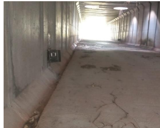
Figura 2: Registro evidenciando câmera de monitoramento instalada na Passagem de Fauna Terrestre Km 216+950, pista norte da Rodovia BR 101/RJ. Fonte: Concremat Ambiental.
