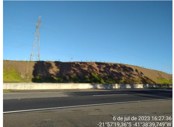
Figura 18: Visada frontal para talude de encosta no km +, pista norte, evidenciando a conclusão das obras de recuperação de sinistro. Fonte: Concremat Ambiental.
