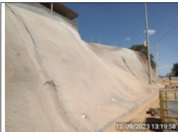
Figura 19. Passivo nº 21. Recuperado (Concreto projetado, barbacãs e drenagens).
