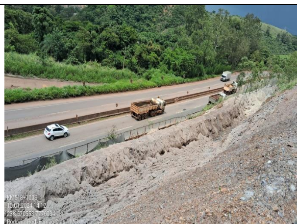
Figura 20. Passivo nº 75. Em recuperação. Obra em execução.
