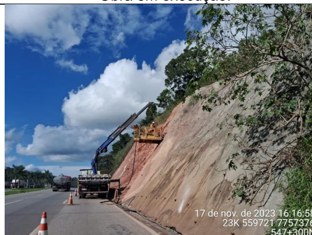
Figura 22. Passivo nº 79. Em recuperação. Obra em execução.
