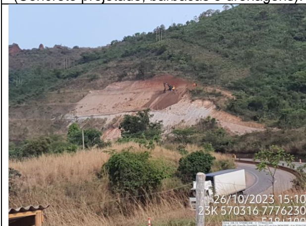
Figura 21. Passivo nº 76. Em recuperação. Obra em execução.
