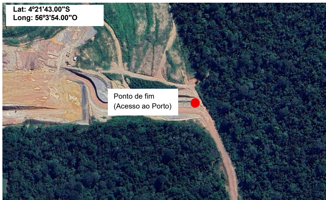
Figura 11 - Fim do Acesso ao Porto de Itapacurá
