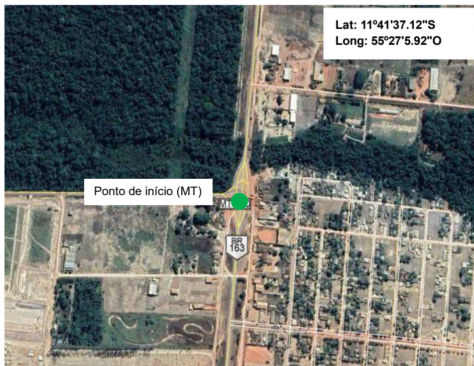
Figura 2 - Início do segmento da Rodovia BR-163/MT
