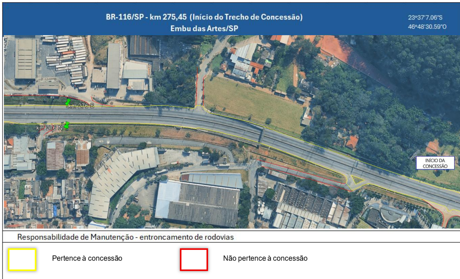
Figura 15 – km 275,45 (Início do Trecho de Concessão) – Embu das Artes/SP
