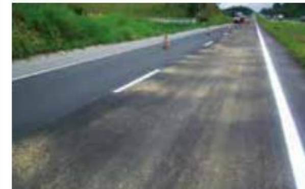
(h) RAP-agregado-emulsão: camada logo após execução (foto: Amanda Marcandali da Silva)
