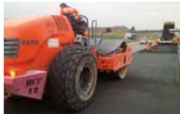
(g) RAP-agregado-asfalto espuma: execução de camada (foto: Valmir Bonfim)
