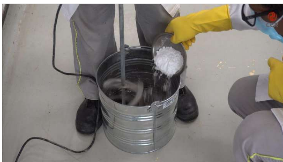
Figura 3 – Adicionar o aditivo expensor na calda de cimento.
