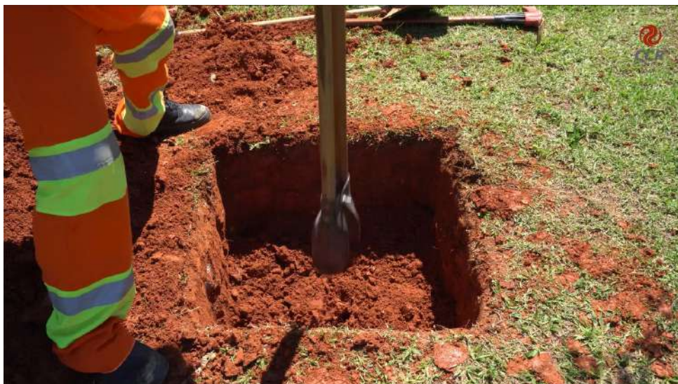
Figura 3 – Realizar a escavação.
