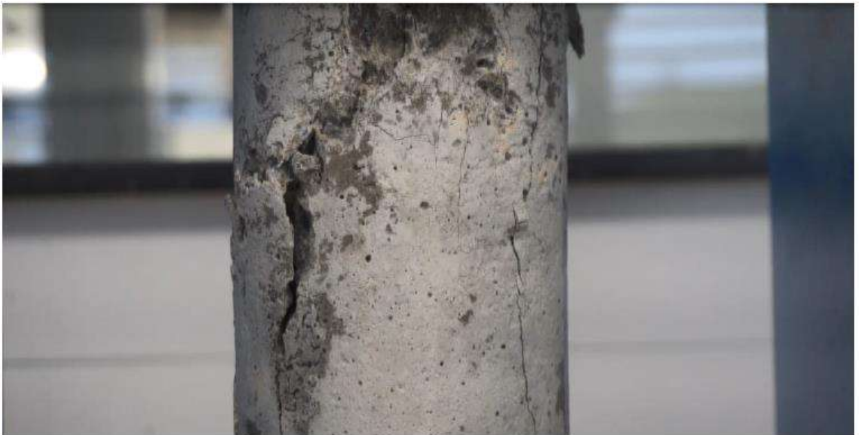
Figura 4 – Ruptura dos corpos de prova.
