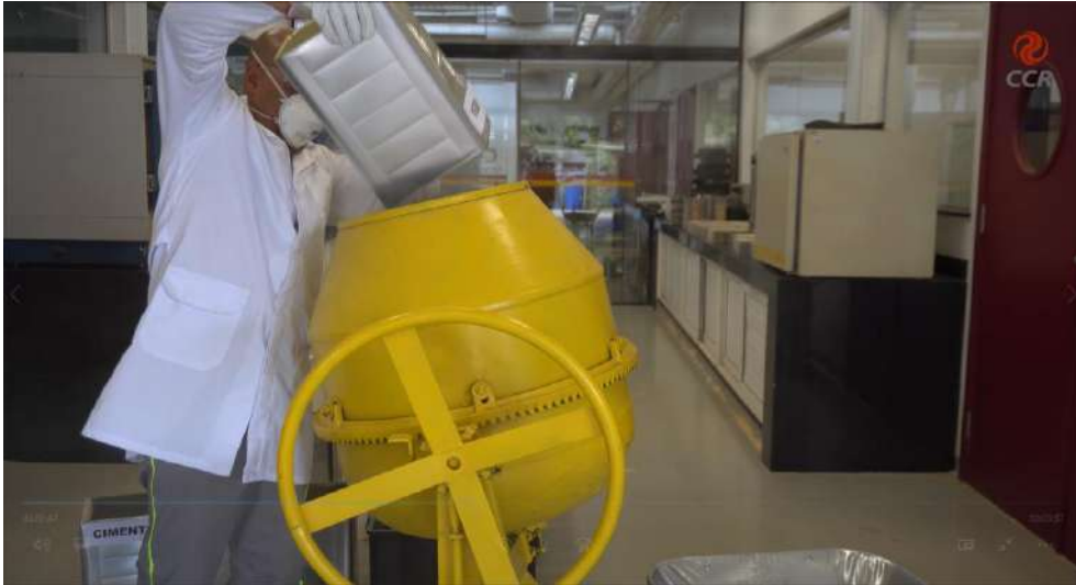
Figura 4 – Adicionar cimento e areia na betoneira, posteriormente acrescenta-se uma fração de água novamente.
