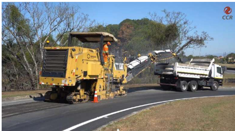
Figura 1 – Realização da fresagem parcial da camada de revestimento asfáltico
