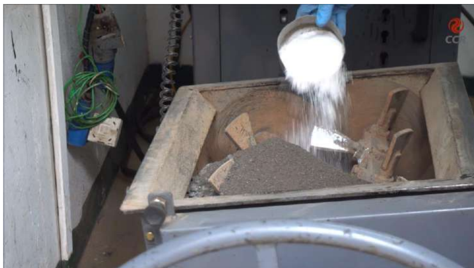
Figura 4 – Adicionar os agregados e aditivos especificados no misturador.
