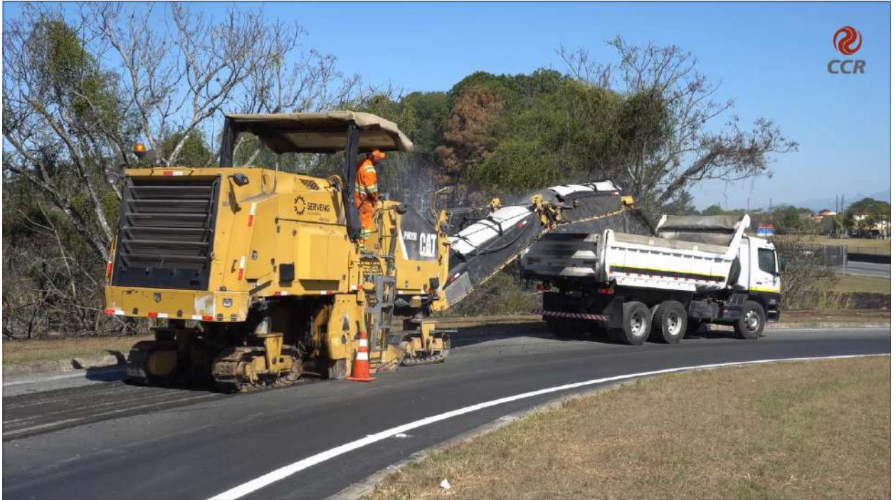
Figura 1 – Extração do material freado.
