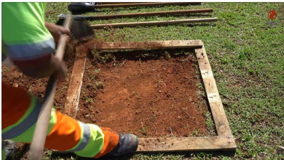
Figura 2 – Realizar a limpeza superficial dentro do gabarito.
