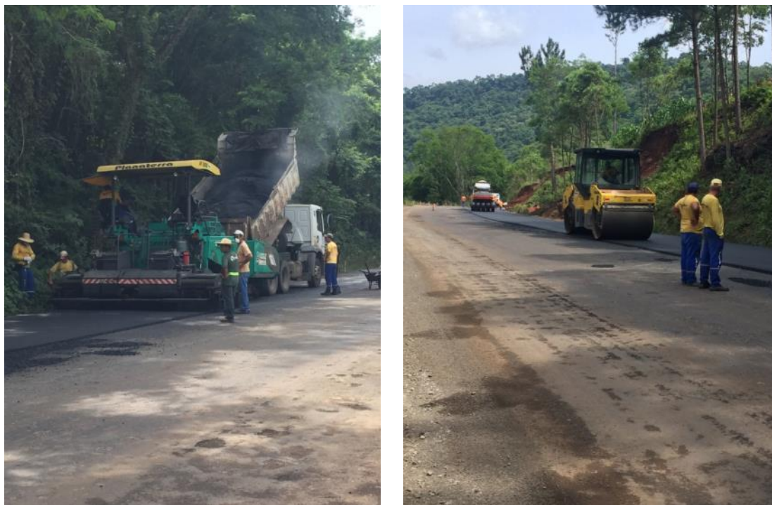
Figura 35 - Conformação e compactação da camada asfáltica
