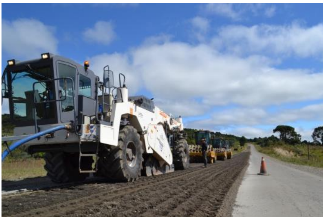
Vista da recicladora com mangueira de abastecimento de água
