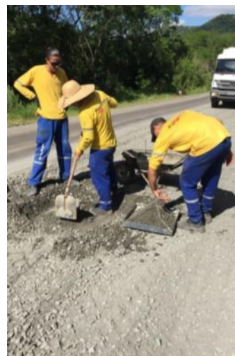
Figura 26 - Distribuição de agregados adicionais e verificação da taxa
