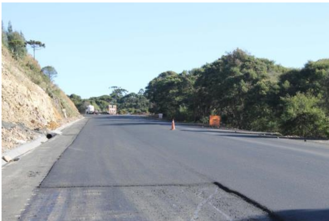
Parte da capa de concreto asfáltico já compactada e subjacente a esta o TSS
