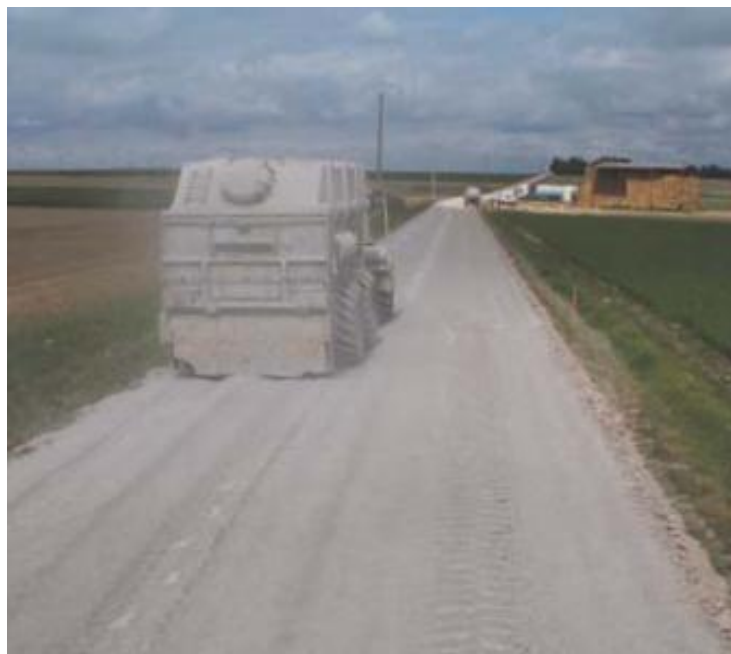
Figura 4 Distribuição automatizada do cimento.
