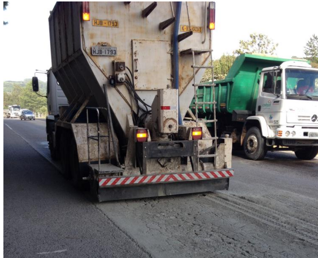
Figura 3 Distribuição do cimento sobre o pavimento através de distribuidor de aglomerante hidráulico
