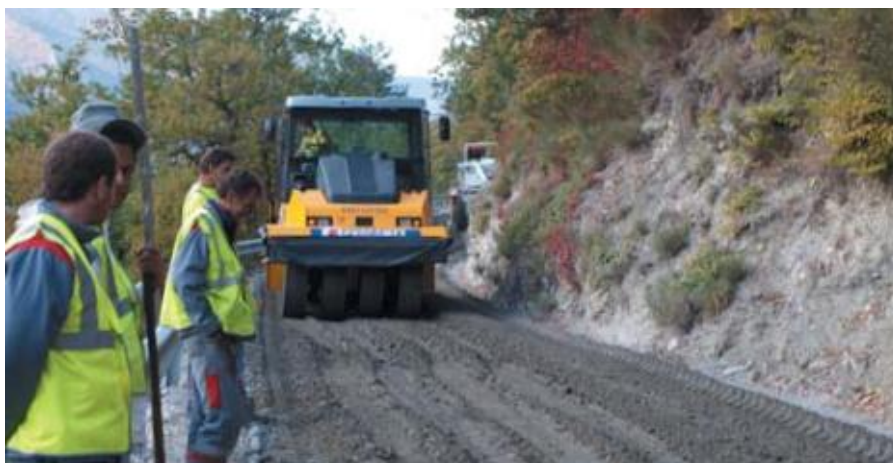
Figura 9 Compactação final com rolo pneumático
