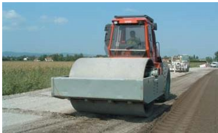
Figura 8 O rolo liso garante a compactação na parte superior da camada.
