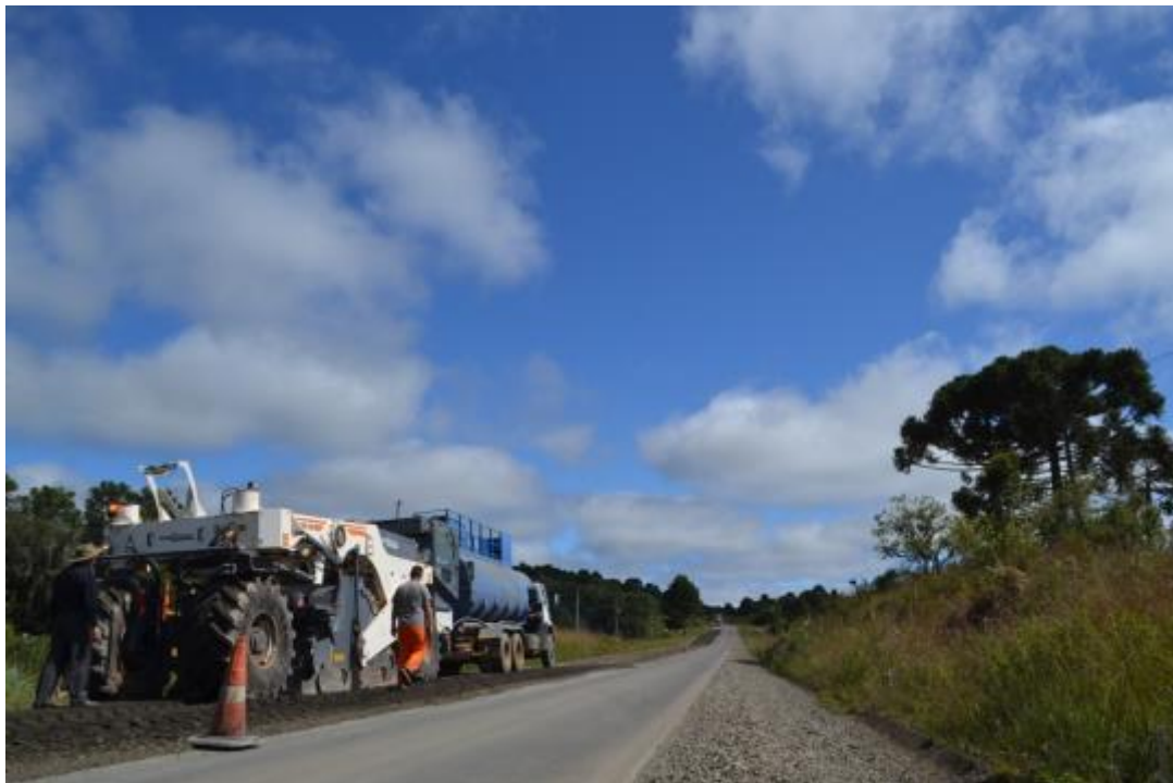
A recicladora em operação e à sua frente o caminhão-pipa
