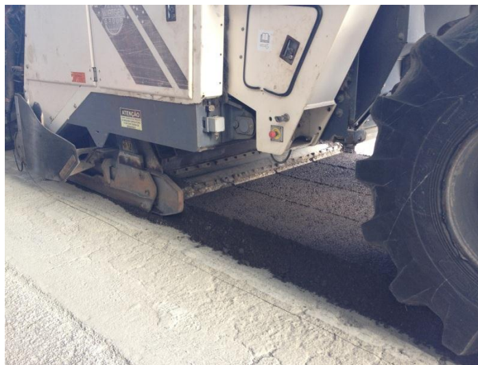
Figura 7 Conformação da mistura reciclada sobre a pista
