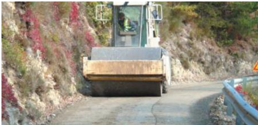
Figura 7 O rolo pesado garante a compactação na parte inferior da camada.
