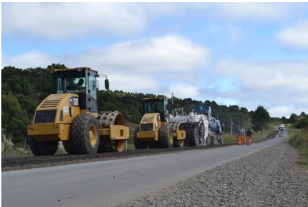
O trem de reciclagem seguido por rolos compactadores
