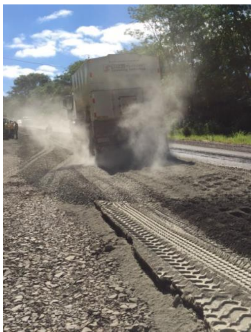
Figura 27 - Distribuição de cimento e verificação da taxa
