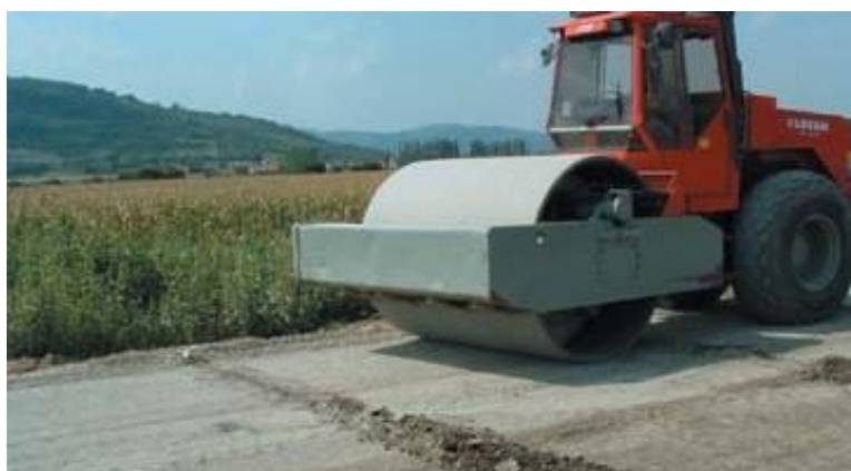
Figura 18 Compactação após a pré-fissuração.
