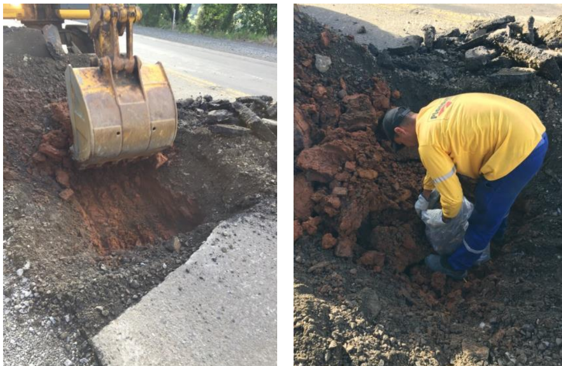
Figura 24 - Coleta dos materiais de subleito e sub-base
