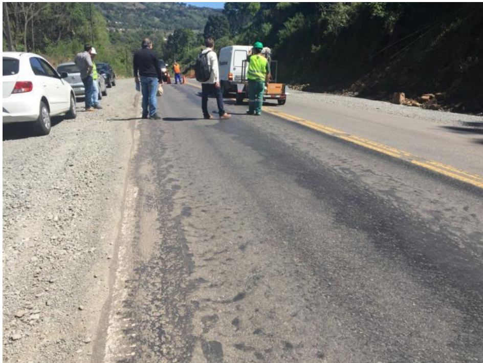
Figura 23 - Alargamento da pista para ambos os lados visando implantação de faixa adicional
