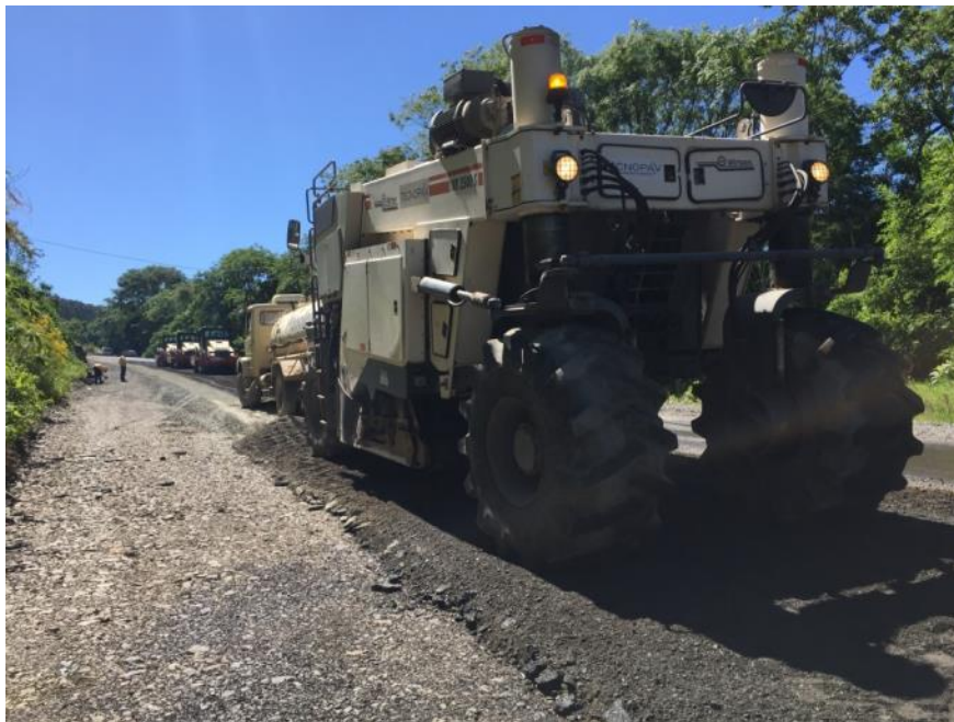
Figura 28 - Operação da recicladora no local do trecho experimental
