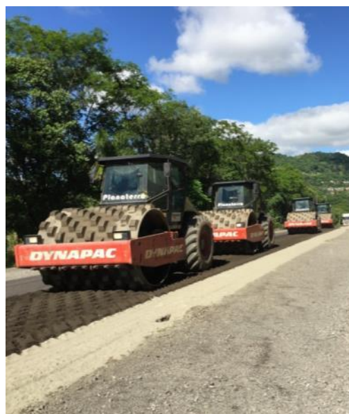
Figura 30 - Compactação da camada reciclada por meio de rolos pé-de-carneiro
