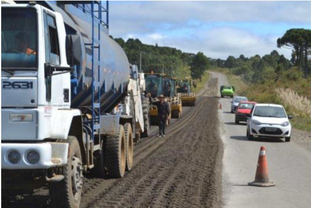
Vista do trem de reciclagem e compactação, com o caminhão-pipa em 1º plano
