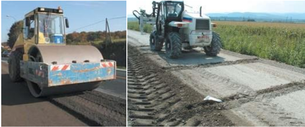
Figura 6 Rolo compactador vibratório e equipamento para pré-fissuração
