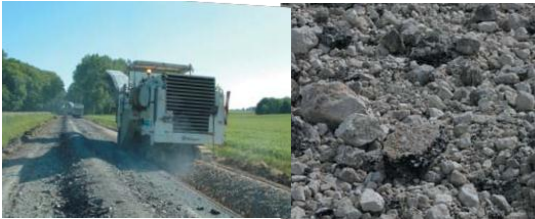
Figura 1 Fresadora e aspecto do material fresado.
