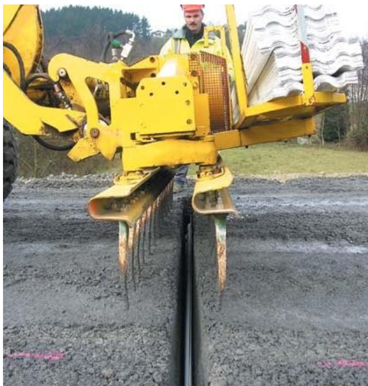
Figura 16 Sistema “Junta Ativa”: Introdução do perfil ondulado.
