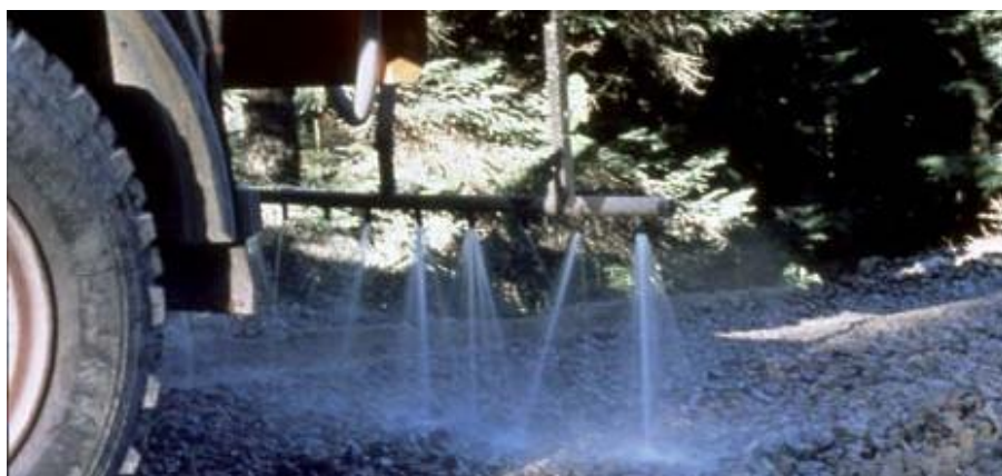
Figura 10 Molhagem com barra espargidora.
