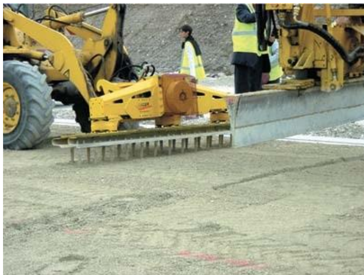
Figura 15 Sistema “Junta Ativa”: realização de um corte ao longo da espessura da camada reciclada.
