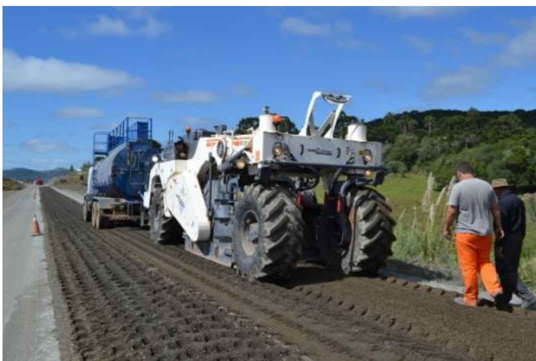
A recicladora em operação e empurrando o caminhão-pipa
