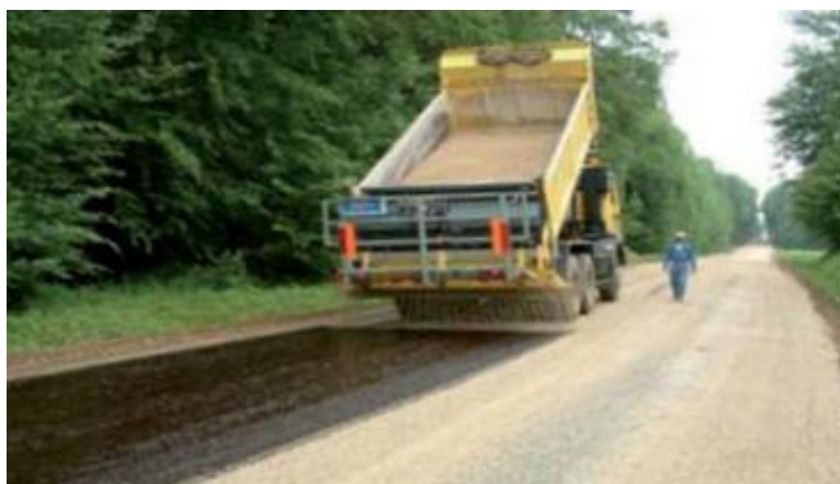
Figura 12 Distribuição de areia após aplicação de emulsão.
