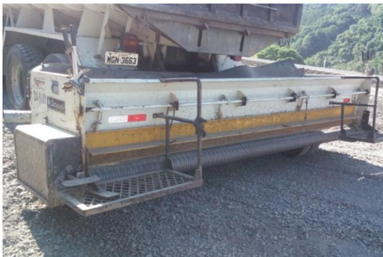
Figura 26 - Distribuição de agregados adicionais e verificação da taxa
