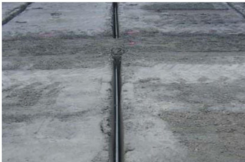
Figura 17 Sistema “Junta Ativa”: juntas instaladas nos cortes, preste a serem fechadas
