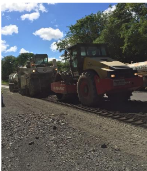
Figura 30 - Compactação da camada reciclada por meio de rolos pé-de-carneiro
