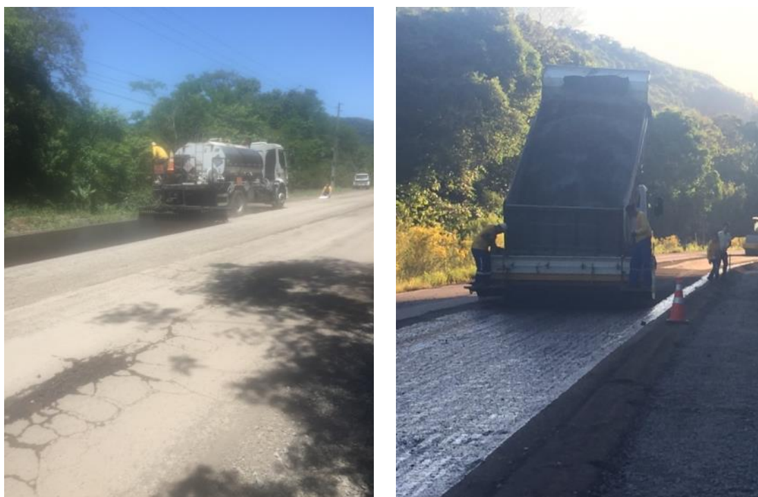
Figura 34 - Execução do TSS sobre a camada reciclada
