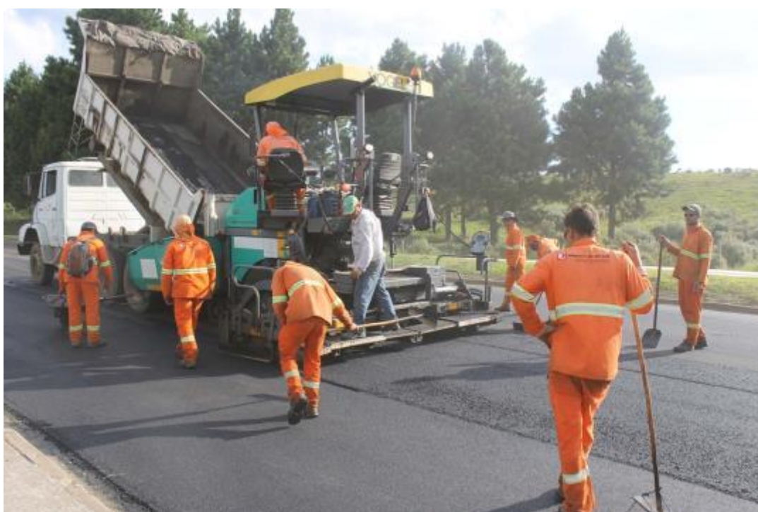
Lançamento da capa de concreto asfáltico sobre a camada reciclada
