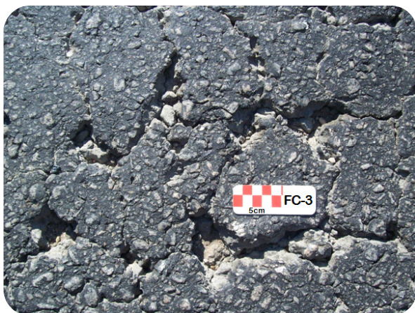
Figura 3.8 – Trincamento típico da superfície do pavimento FC-3
