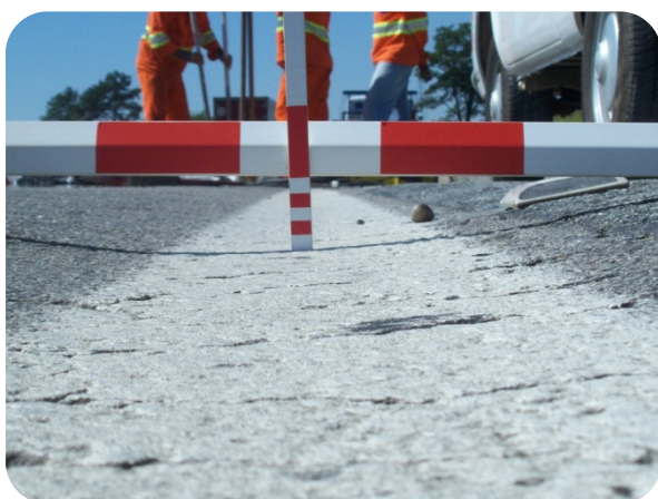
Figura 3.10 – Acentuado afundamento de trilha de roda típico
