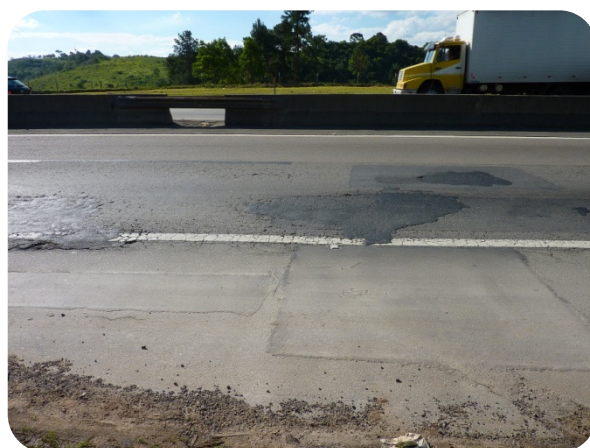
Figura 3.11 – Remendos reincidentes na superfície do pavimento
