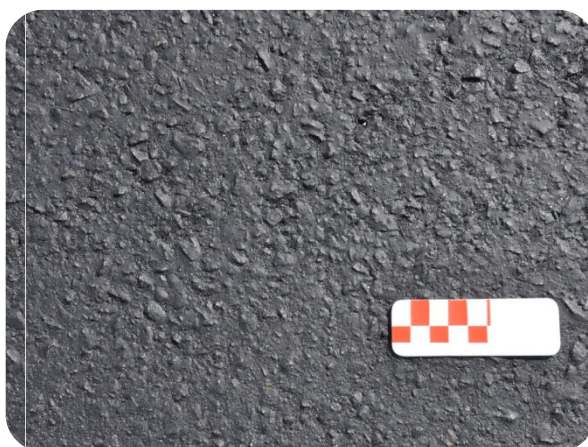
Figura 6.3 – Acabamento da superfície de EME
