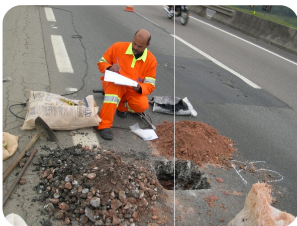
Figura 3.5 – Estaca 170+260: Poço de Inspeção P05 e matérias extraídos
