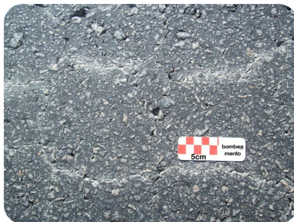
Figura 3.9 – Trincamento típico da superfície do pavimento com bombeamento de finos
