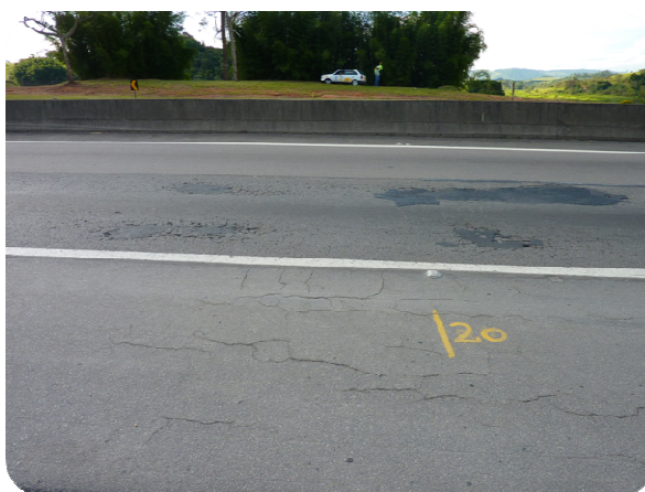
Figura 3.3 – Estaca 170+420: Grau de trincamento da superfície do pavimento
