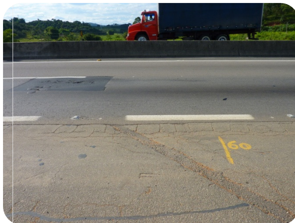
Figura 3.4 – Estaca 170+260: Grau de trincamento de superfície do pavimento e deficiência do dispositivo de drenagem
