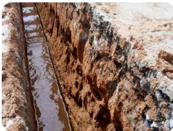
Figura 3.13 – Topo do subleito saturado Perfil longitudinal do Acostamento
