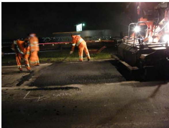
Figura 20. Espalhamento da massa asfáltica morna em pista
