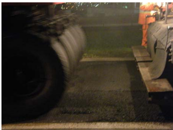
Figura 22. Detalhe da compactação com rolo de pneus próxima à vibroacabadora
