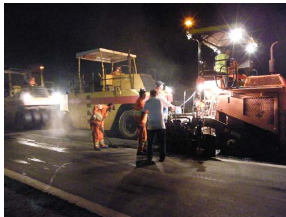
Figura 21. Compactação por pneus seguindo logo atrás da vibroacabadora
