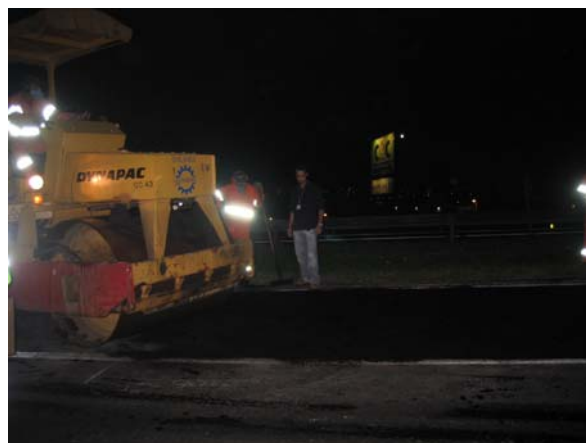
Figura 23. Detalhe da compactação com rolo de chapa
