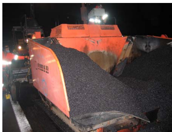
Figura 19. Detalhe da massa asfáltica dentro do silo da vibroacabadora
