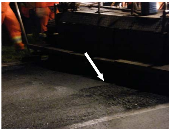
Figura 24. Detalhe da segregação da massa asfáltica
