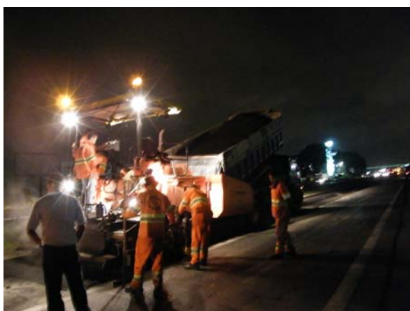
Figura 18. Caminhão ao bascular na vibroacabadora
