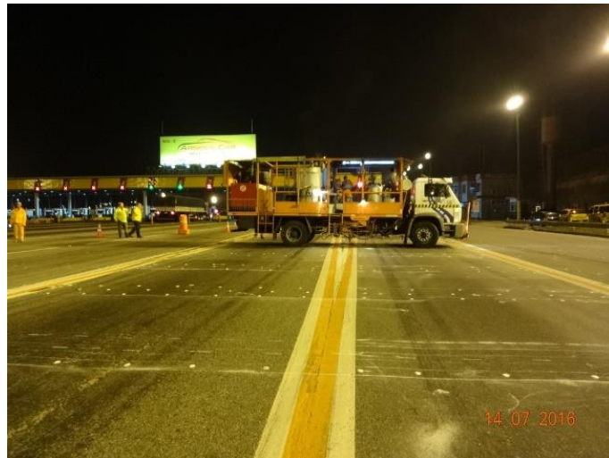
Figura 7 – Veículo e equipamentos de aplicação da Material A. Posteriormente o mesmo veículo foi utilizado na aplicação da Material C
