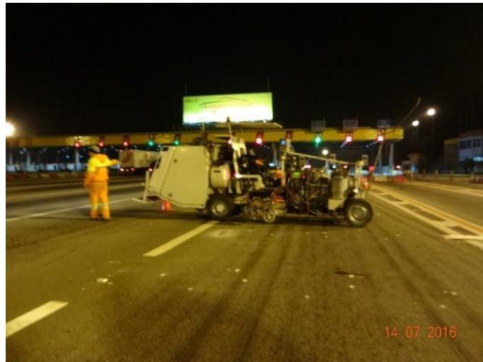
Figura 9 – Veículo e equipamentos de aplicação da Material B
