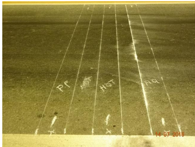
Figura 5 – Pré-demarcação Material A: HOT = termoplástico aplicado por aspersão (hotspray); Material B: PF = plástico a frio (multimetacrilato bi-componente); Material C: AQ = acrílica à base d'água
