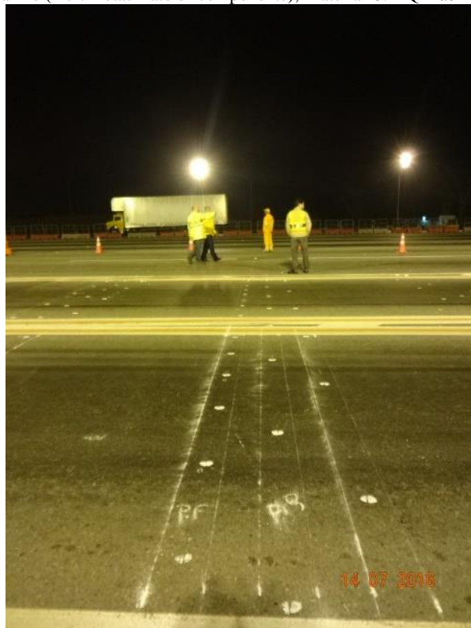
Figura 6 – Pré-demarcação nas faixas de tráfego nº 11 e nº 12
