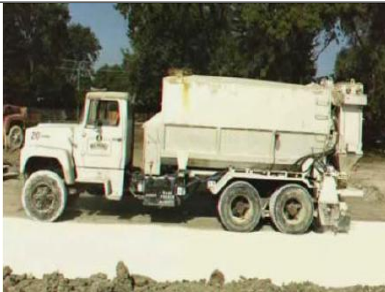
Figura 2.5: Distribuição de cal hidratada. Fonte: NLA (2004)
