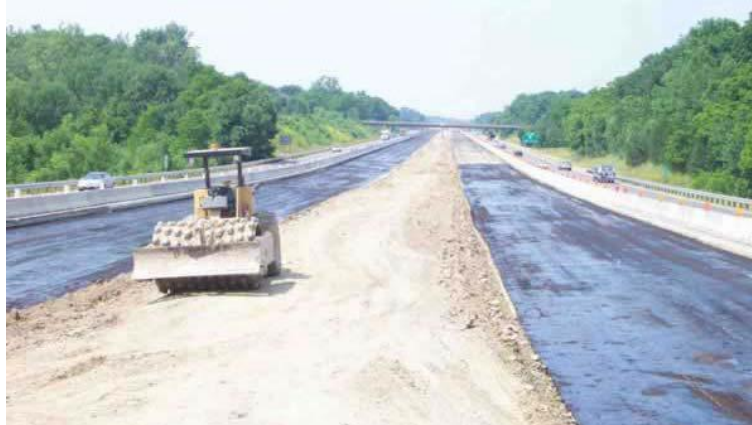
Figura 2.12: Membrana de imprimação com emulsão asfáltica. Fonte: NLA (2004)
