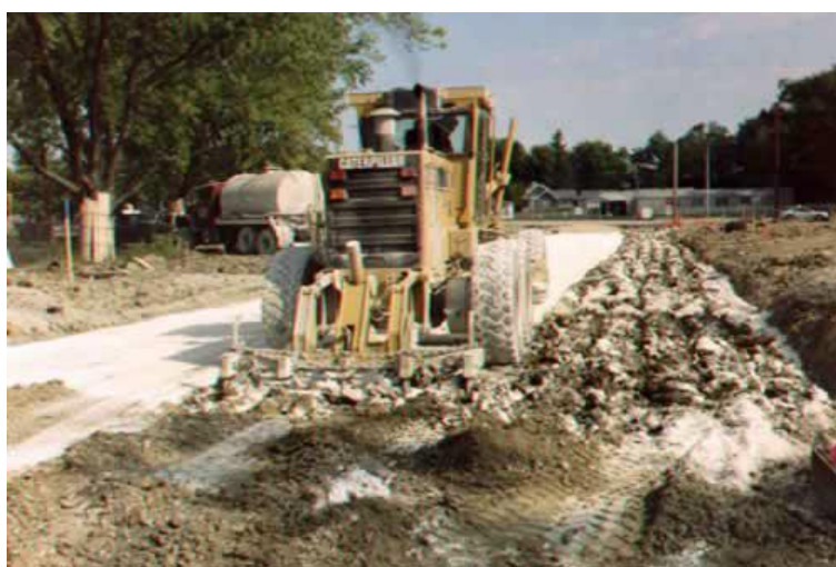
Figura 2.6: Escarificação após adição da cal na superfície do solo. Fonte: NLA (2004)
