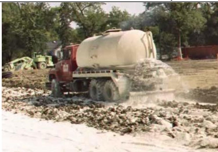
Figura 2.8: Adição de água à mistura de solo cal. Fonte: NLA (2004)
