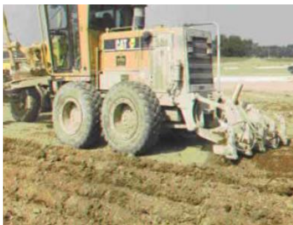
Figura 2.3: Escarificação prévia à adição de cal. Fonte: NLA (2004)
