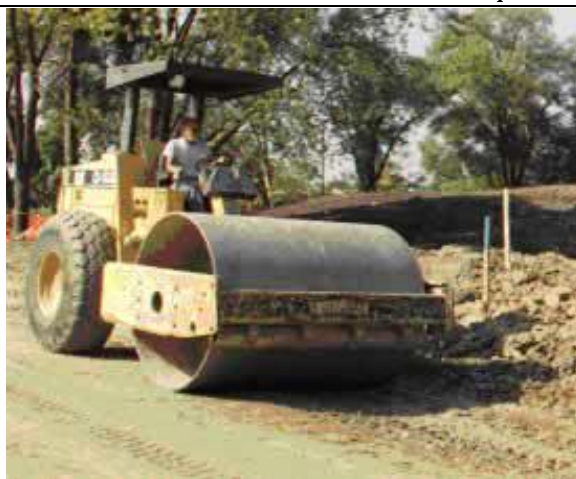
Figura 2.11: Compactadores de chapa lisa para acabamento da superfície da mistura de solo cal. Fonte: NLA (2004)
