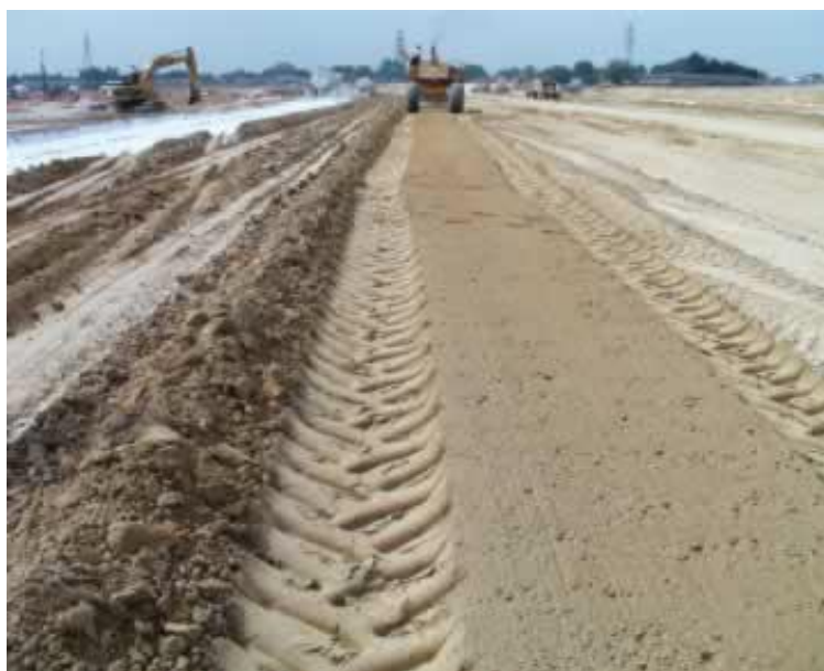
Figura 2.9: Aspecto da camada de solo cal após mistura e pulverização. Fonte: NLA (2006)
