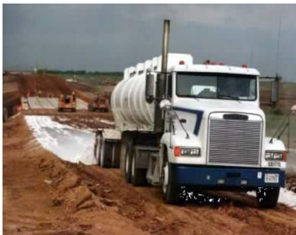
Figura 2.4: Construção de barreiras laterais de solo para evitar perdas de cal.
