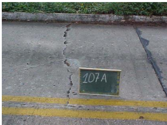
Figura 1. Fissura transversal em pavimento rígido.
