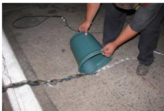
Figura 3.4. Preenchimento com resina
