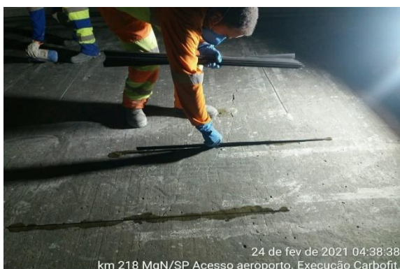
Figura 3.5. Inserção da fibra de carbono
