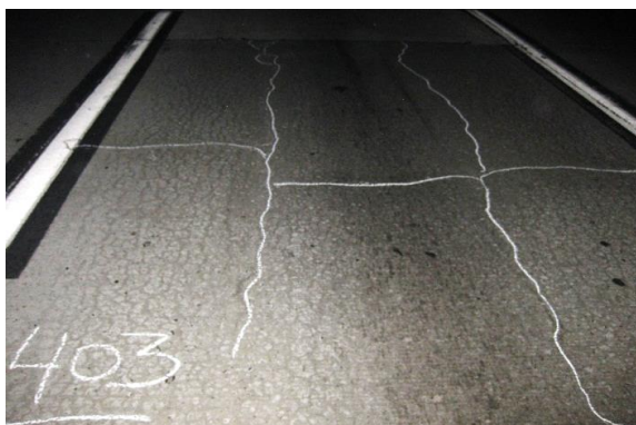
Figura 3.1. Identificação das fissuras
