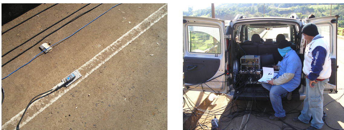
Figura 3.23 - Servo-acelerômetro posicionado em tabuleiro de ponte, e sistema de aquisição de dados utilizado para gravação dos sinais
