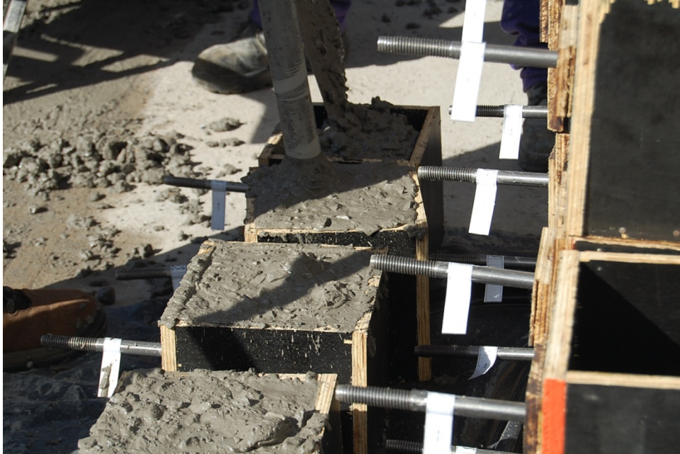
Figura 3.24 - Moldagem dos corpos-de-prova com cura em repouso dos lotes 1 a 4
