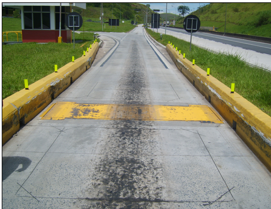
Figura 2 – Instalações da balança móvel e da balança fixa em sequência.
