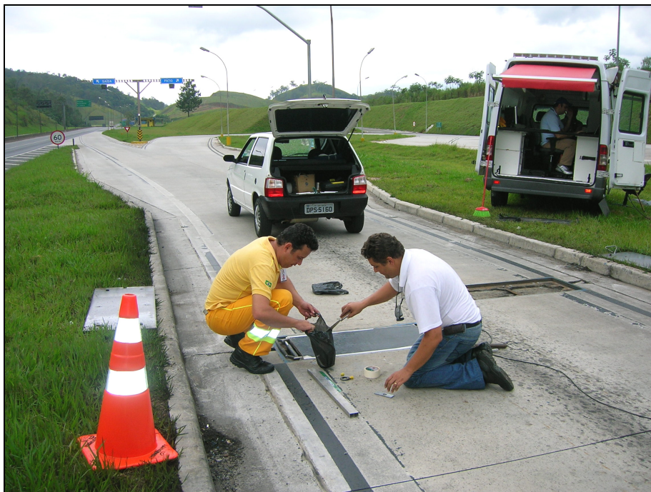
Figura 4 - Instalação do instrumento de pesagem portátil no posto de pesagem
