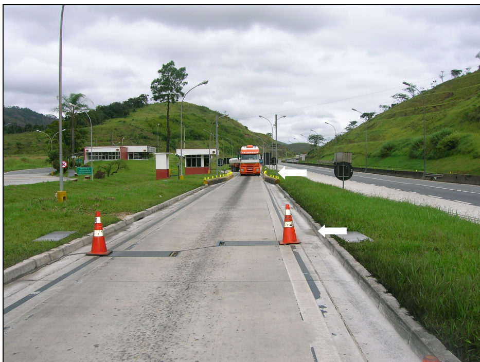
Figura 2 – Instalações da balança móvel e da balança fixa em sequência.
