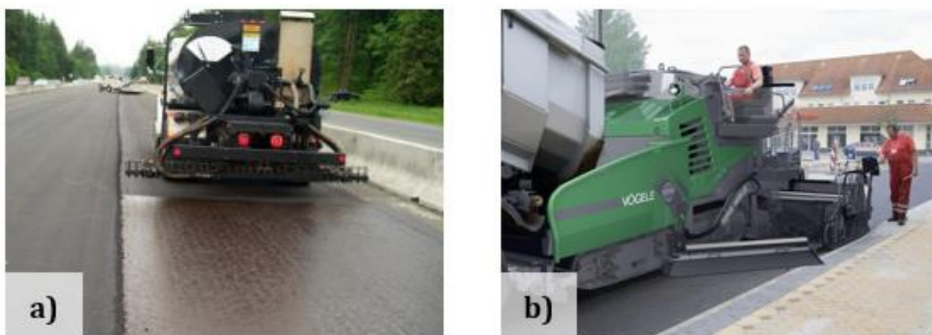
Figura 3.2: Equipamentos para aplicação da pintura de ligação: a) Caminhão distribuidor; b) Vibroacabadora com barra espargidora
