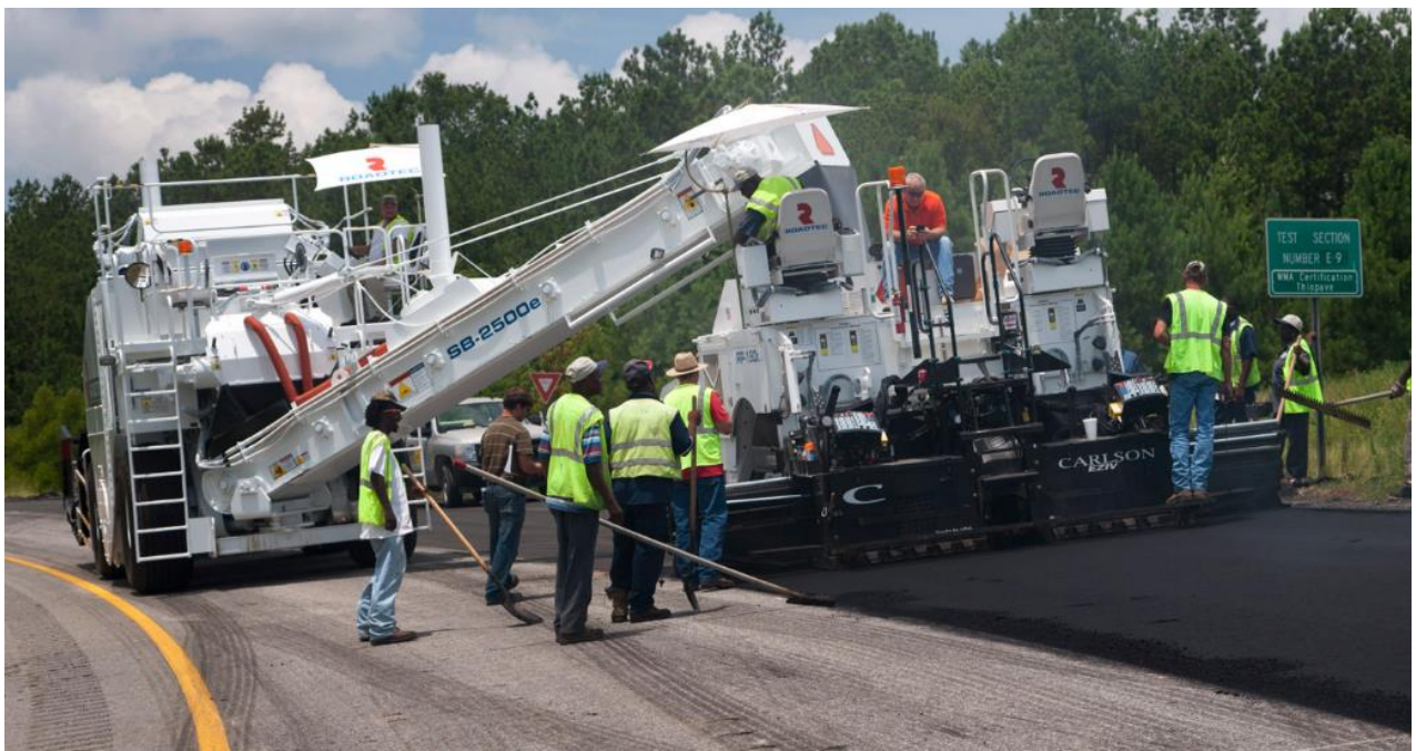
Figura 3.6: Emprego de transferidores de mistura asfáltica. FONTE: https://www.roadtec.com/products/material-transfer-vehicles/sb-2500e-ex
