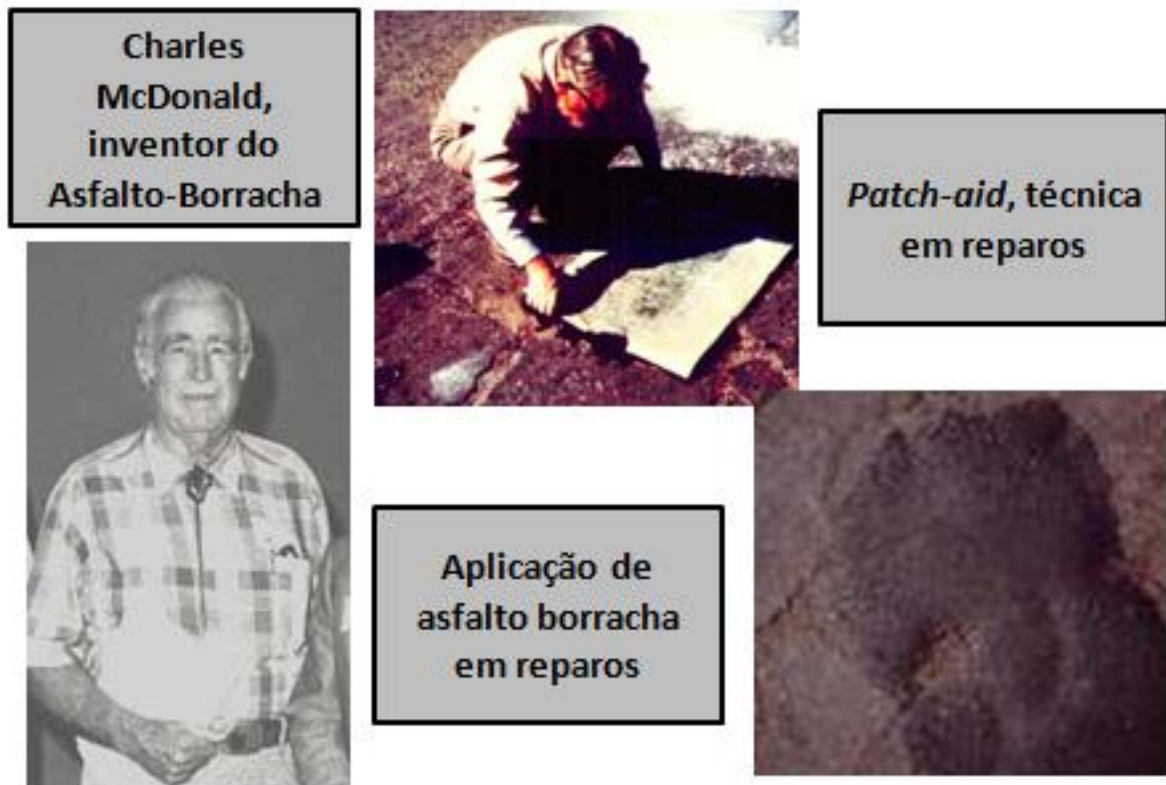
Figura 2.9: Charles McDonald, inventor do asfalto-borracha, aplicando sua solução patch-aid em reparos de pavimentos asfálticos. FONTE: Way, 2009
