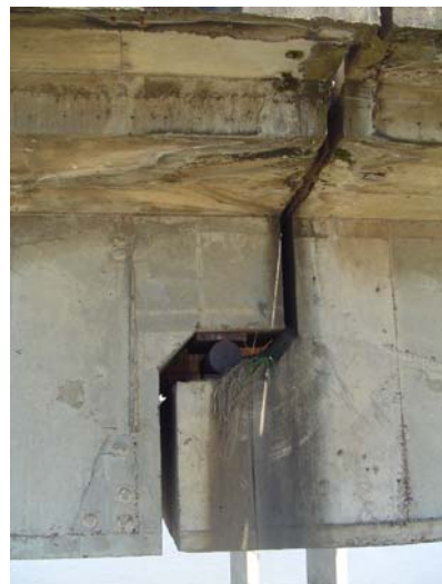
Figura 10: detalhe Gerber (P32)
