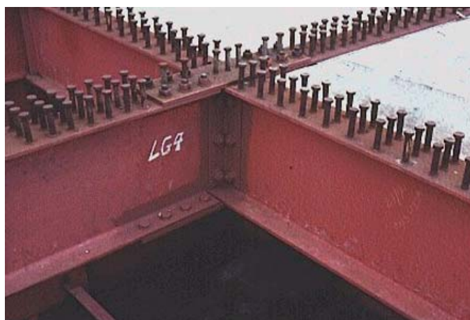
Figura 30: conectores de cisalhamento Stud Bolts soldados
