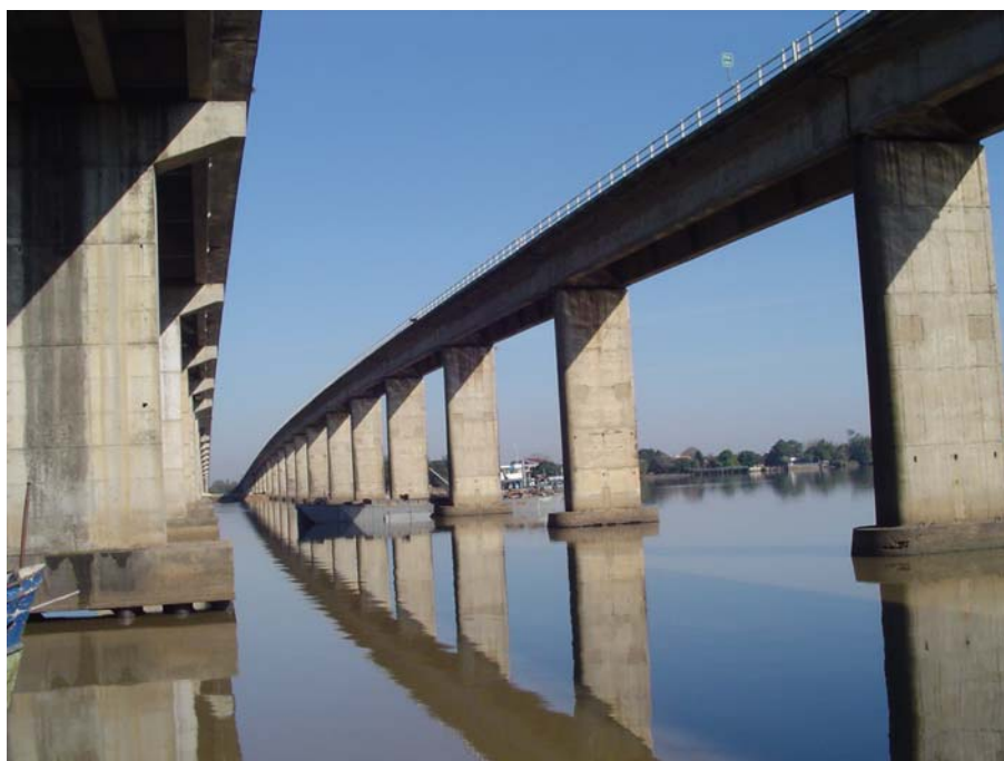
Figura 47: ponte sobre o Rio Jacuí – Obra Norte (direita)
