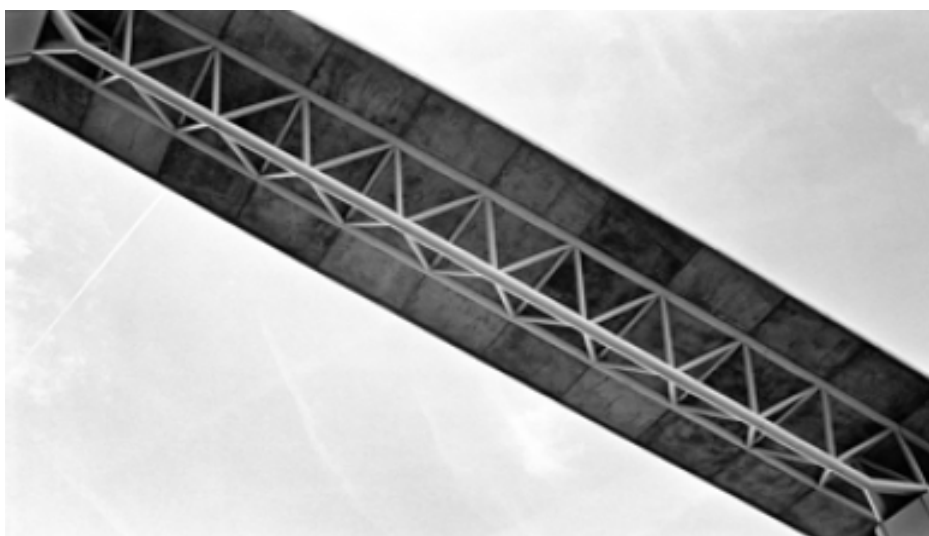
Figura 40: lajes pré-fabricadas, ponte Venta del Jamón
