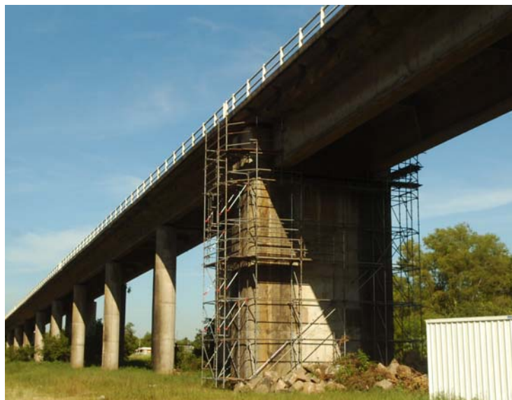
Figura 49: andaimes junto ao pilar de transição P40
