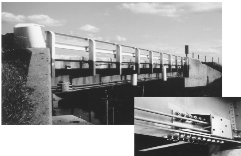
Figura 10: ponte com vão simples reforçada com pós-tensão externa
