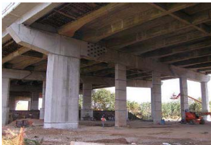
Figura 26: pilar extremo alargado e travessa como console (lado esquerdo)
