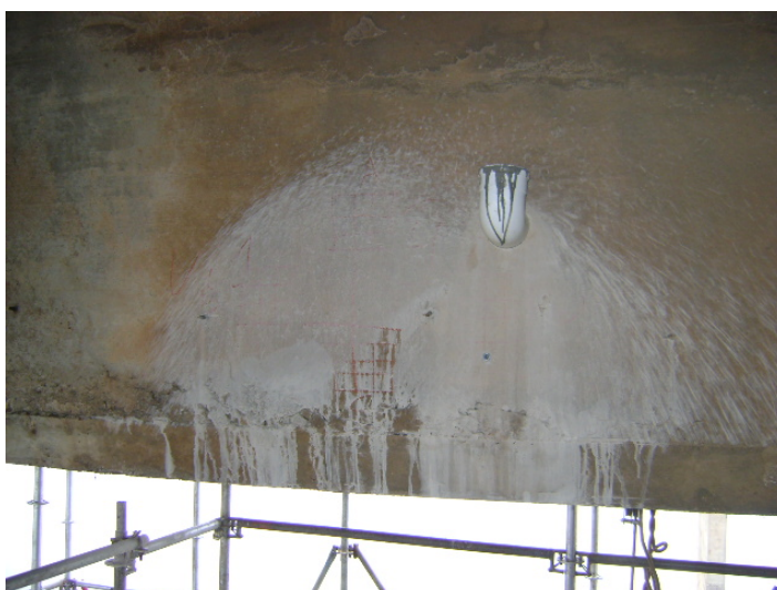
Figura 71: corpos de prova extraídos nas vigas do vão central (lado interno)
