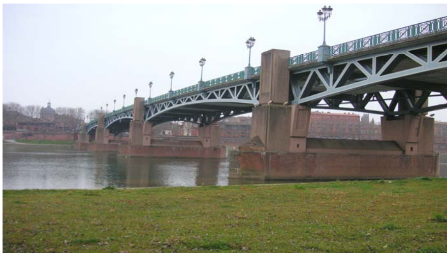
Figura 36: ponte Saint Pierre em Toulouse, França
