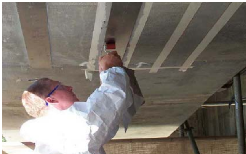
Figura 11: aplicação de reforço com CFRP, ponte Oberriet-Meiningen
