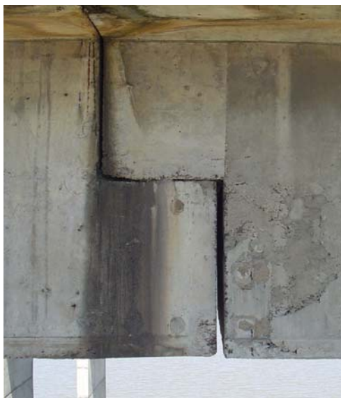
Figura 53: detalhe do dente Gerber próximo ao pilar P31
