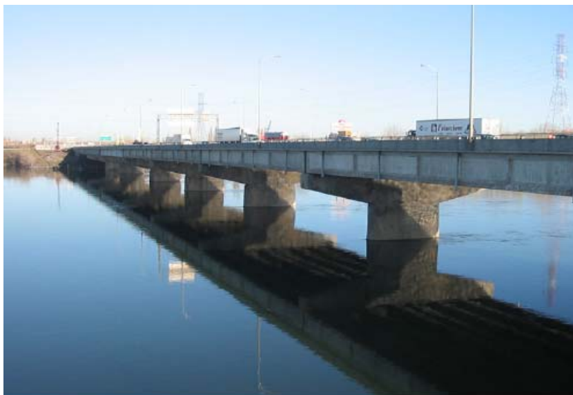
Figura 16: vista geral da ponte-túnel Louis-Hippolyte-LaFontaine , direção Norte
