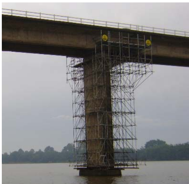
Figura 23: extração/esclerometria para vigas do vão central (junto ao Gerber) (incluindo pilares de transição) - Face Leste
