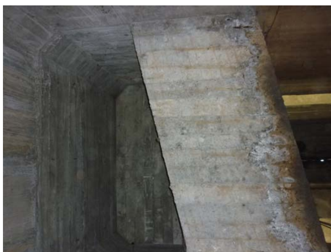
Figura 57: vista interior dos pilares de transição – detalhe do dorso inferior da viga onde se apoiam os roletes do vão de 43m
