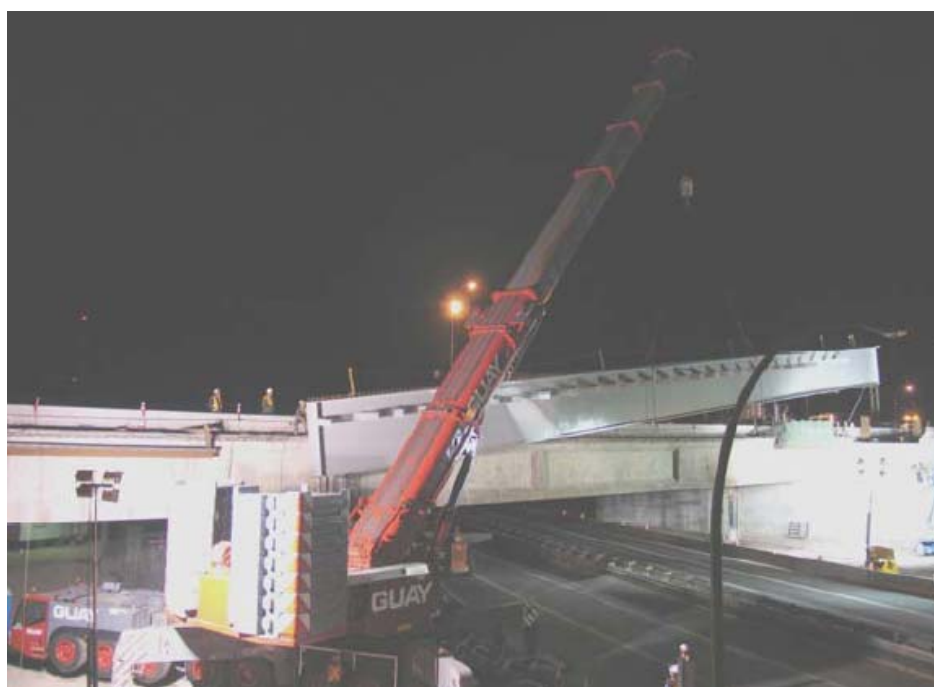
Figura 21: posicionamento dos perfis de alma cheia
