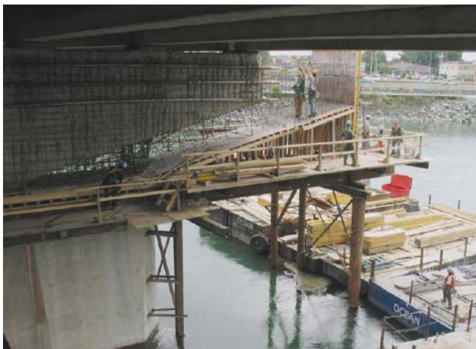
Figura 20: alargamento das travessas
