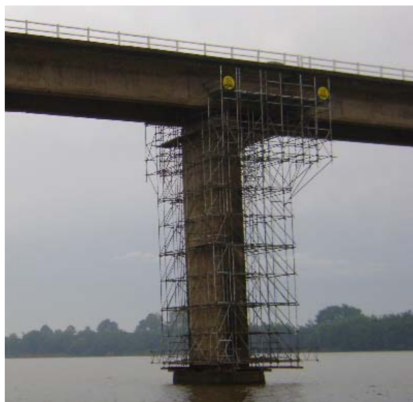
Figura 66: vista dos andaimes no pilar P32 junto ao Gerber
