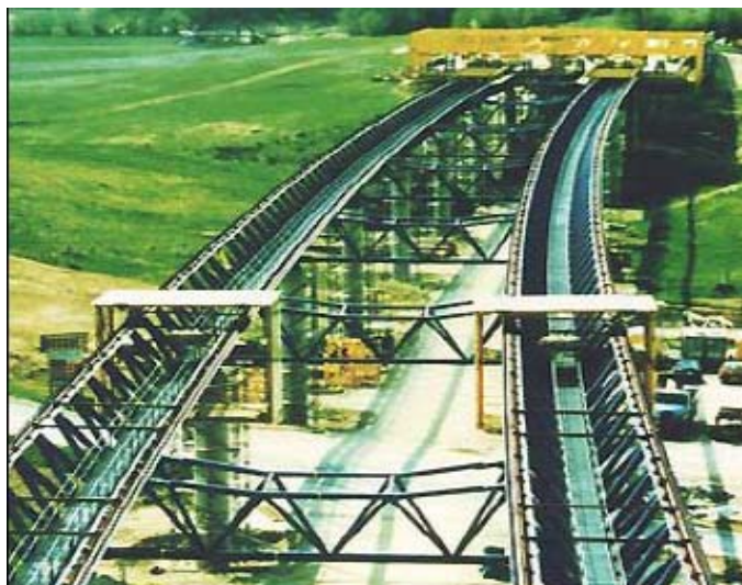
Figura 43: montagem dos travamentos transversais, ponte Lully
