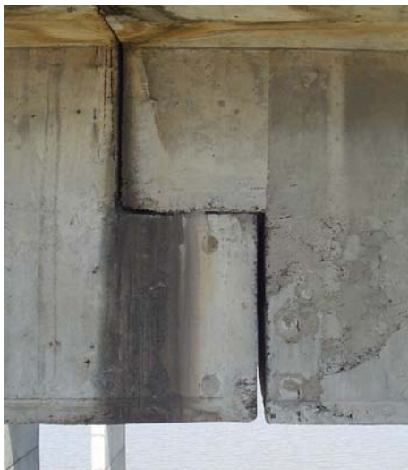
Figura 9: detalhe Gerber (P31)
