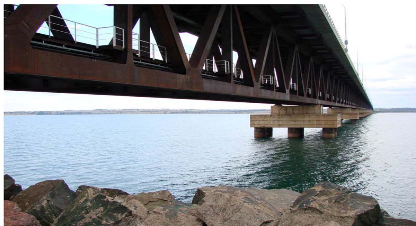
Figura 41: ponte Rodo-ferroviária sobre o rio Paraná
