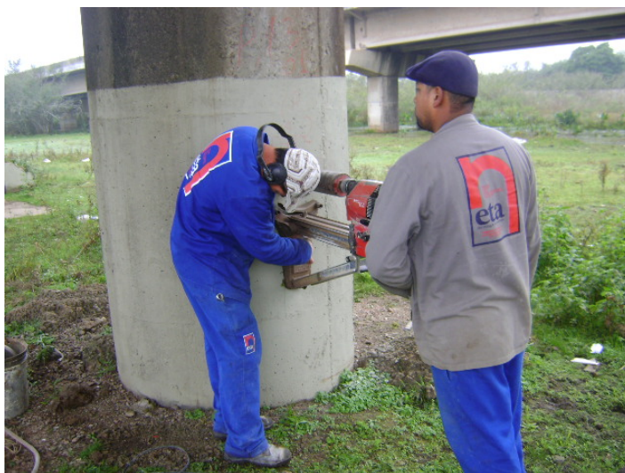
Figura 70: extração dos corpos-de-prova dos pilares coluna
