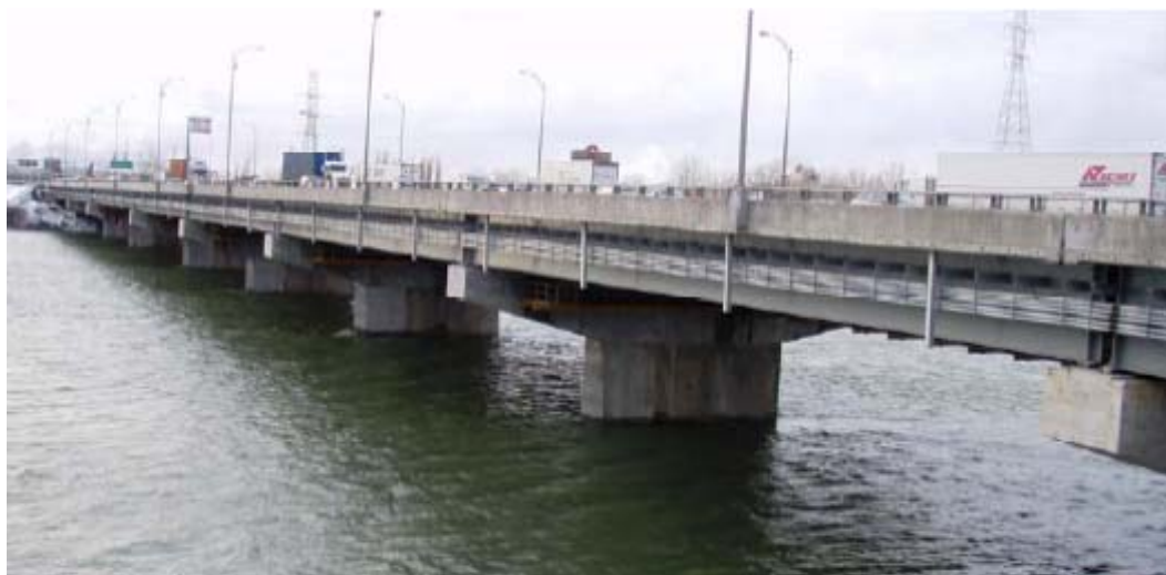
Figura 22: aparência final da ponte-túnel Louis-Hippolyte-LaFontaine alargada com vigas de aço apoiadas nas travessas
