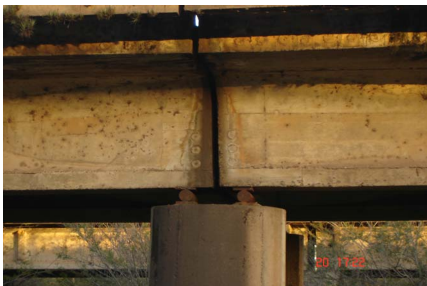
Figura 50: apoios em roletes de aço nas juntas dos vãos de 21.5m
