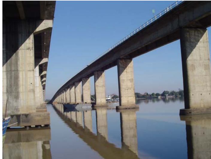
Figura 1: ponte sobre o Rio Jacuí - Obra Norte (direita)
