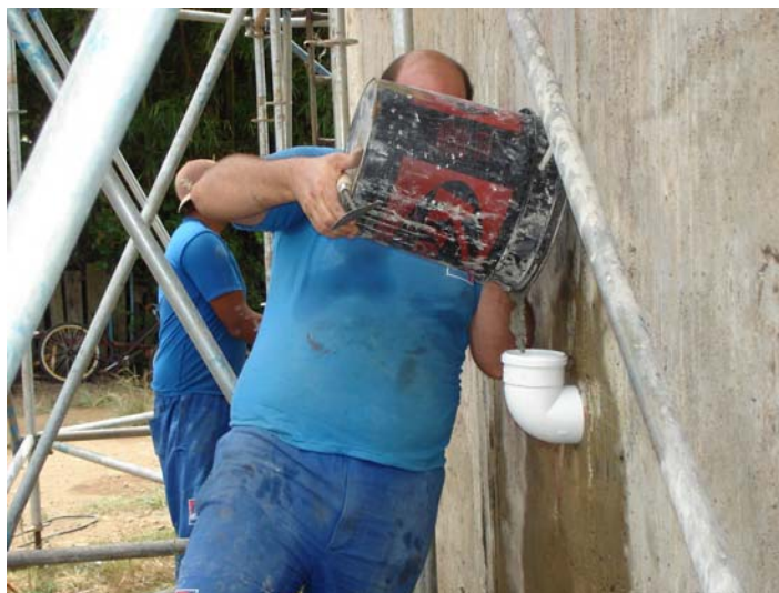
Figura 73: preenchimento dos furos de extração com graute
