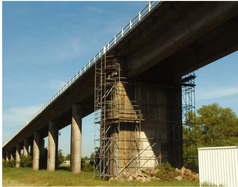
Figura 5: andaimes junto ao pilar de transição P40
