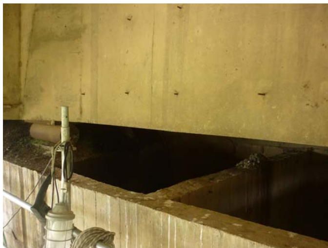
Figura 56: parede divisória dos pilares de transição
