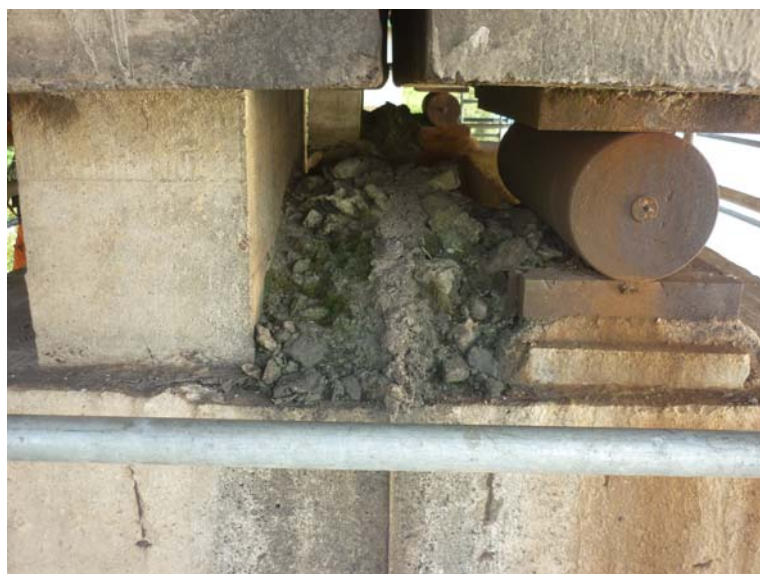
Figura 52: apoio dos vãos de 43m sobre pilares de seção caixão
