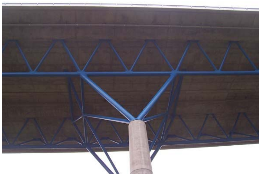
Figura 45: viaduto de St. Kilian , treliças tubulares de aço
