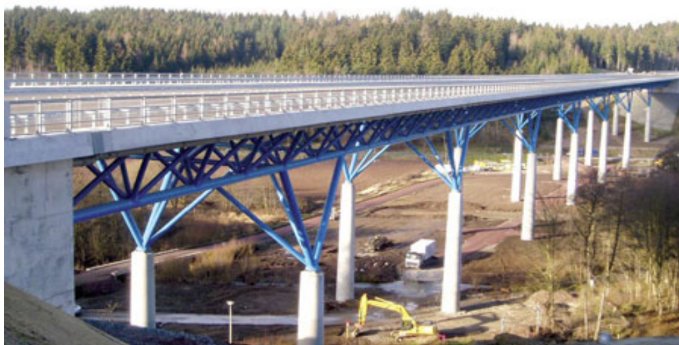
Figura 44: viaduto St. Kilian, Alemanha
