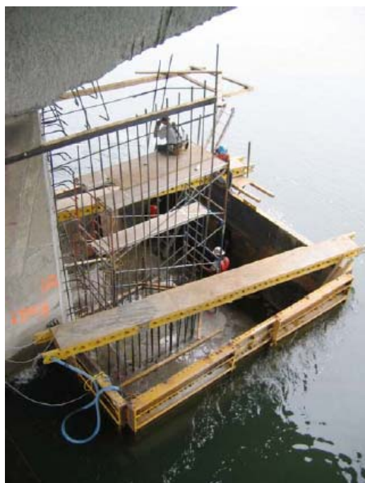
Figura 19: alargamento dos pilares
