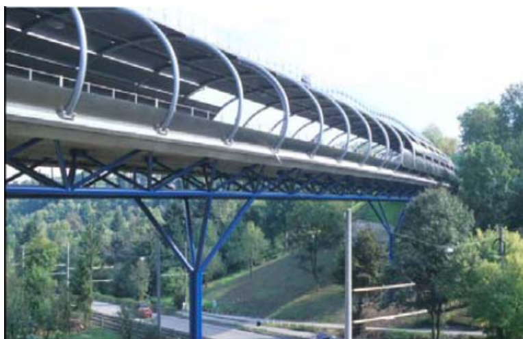
Figura 33: ponte rodoviária de Nesenbachtal , Alemanha
