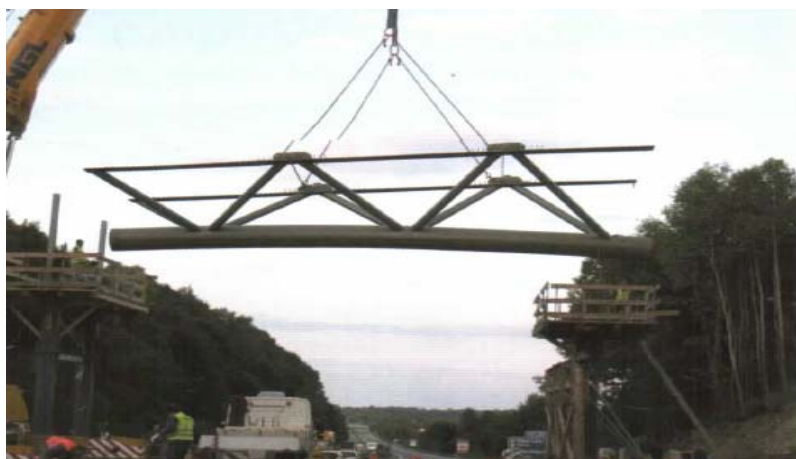
Figura 38: montagem do arco treliçado
