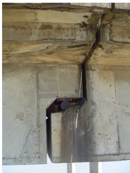
Figura 54: detalhe do dente Gerber próximo ao pilar P32
