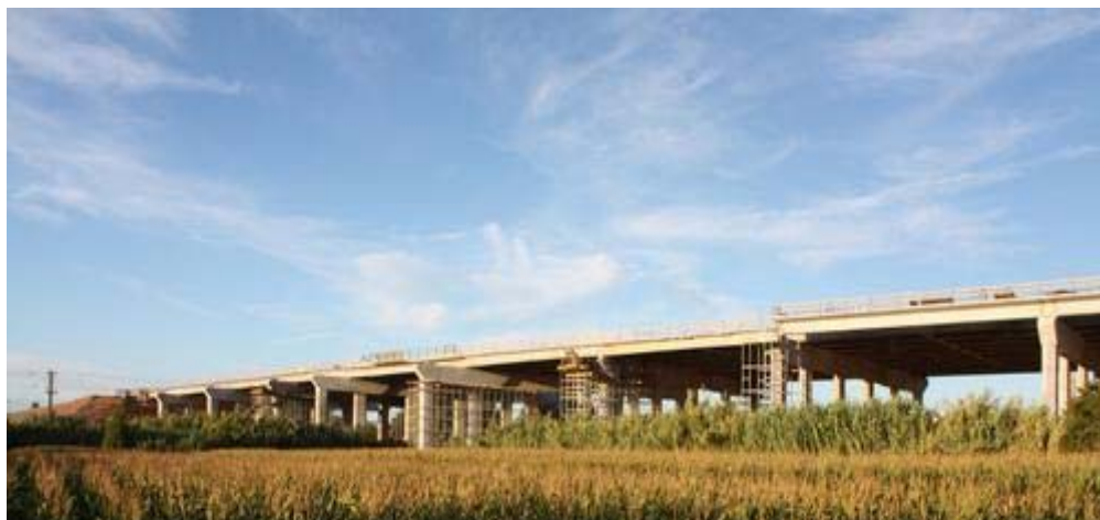
Figura 25: viaduto V276 durante os trabalhos de alargamento, rodovia A1, Portugal
