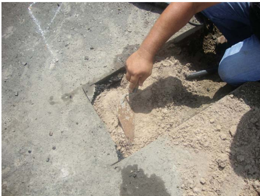
Figura 47: Acabamento final na instalação dos sensores no pavimento asfáltico.
