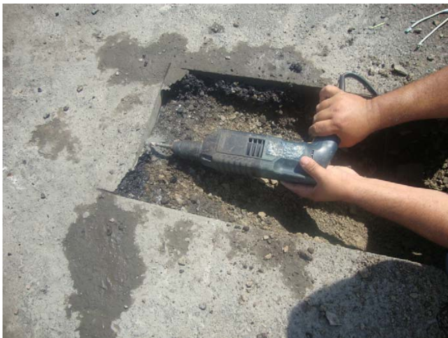
Figura 41: Perfuração da camada de CBUQ para instalação dos sensores.
