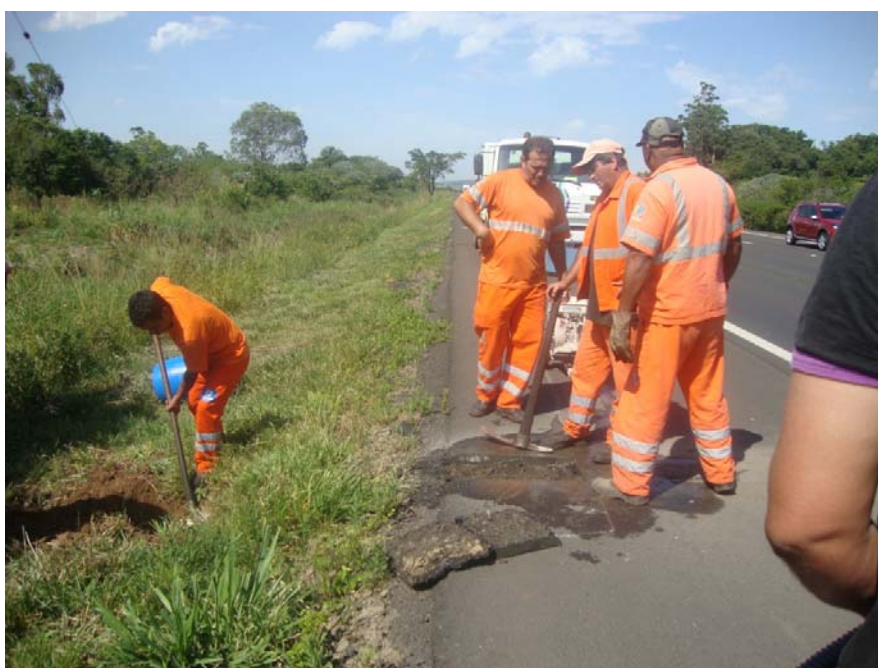
Figura 36: Abertura do pavimento e do local para implantação da bombona para instalação do sistema de aquisição eLogger desenvolvido nesta pesquisa.
