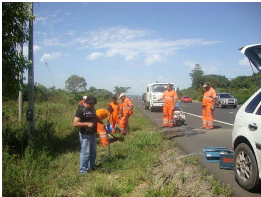
Figura 34: Adequações elétricas e abertura do pavimento para instalação do sistema de aquisição eLogger desenvolvido nesta pesquisa.
