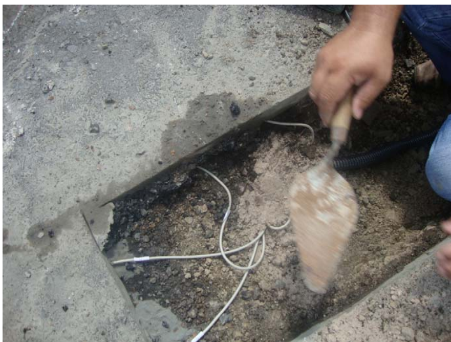
Figura 46: Adequação e instalação dos sensores na camada de base.
