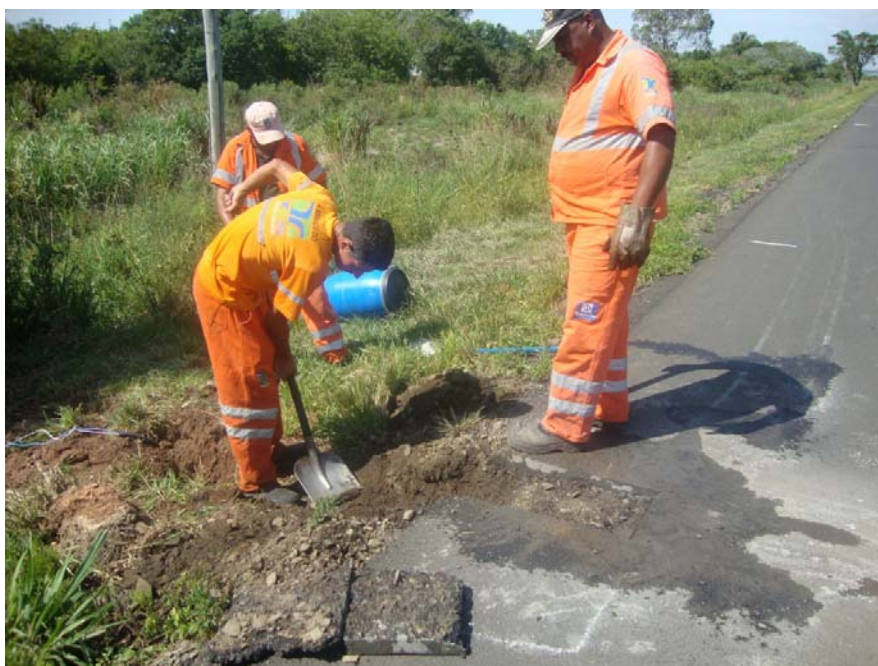
Figura 37: Abertura do pavimento e do local para implantação da bombona para instalação do sistema de aquisição eLogger desenvolvido nesta pesquisa.
