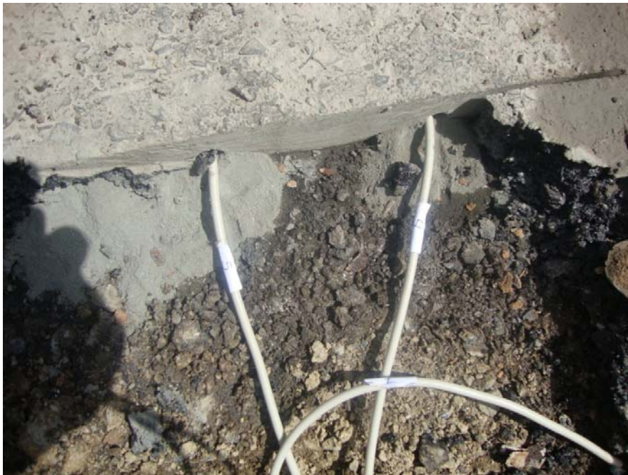
Figura 44: Instalação dos sensores na camada de CBUQ.
