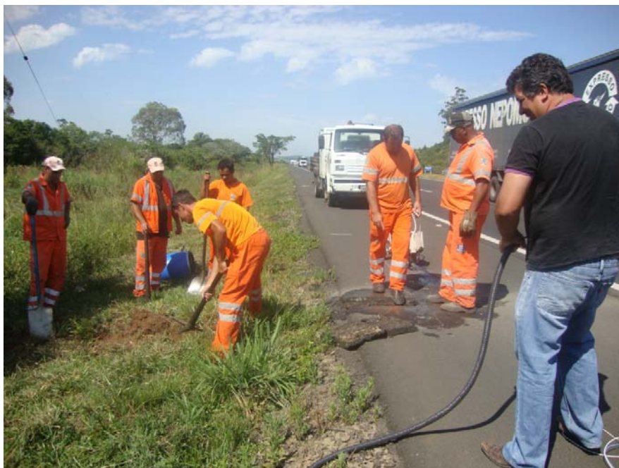
Figura 35: Adequações elétricas e abertura do pavimento para instalação do sistema de aquisição eLogger desenvolvido nesta pesquisa.
