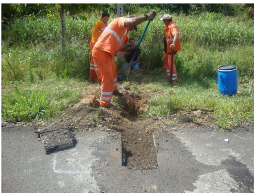
Figura 38: Abertura do pavimento e do local para implantação da bombona para instalação do sistema de aquisição eLogger desenvolvido nesta pesquisa.
