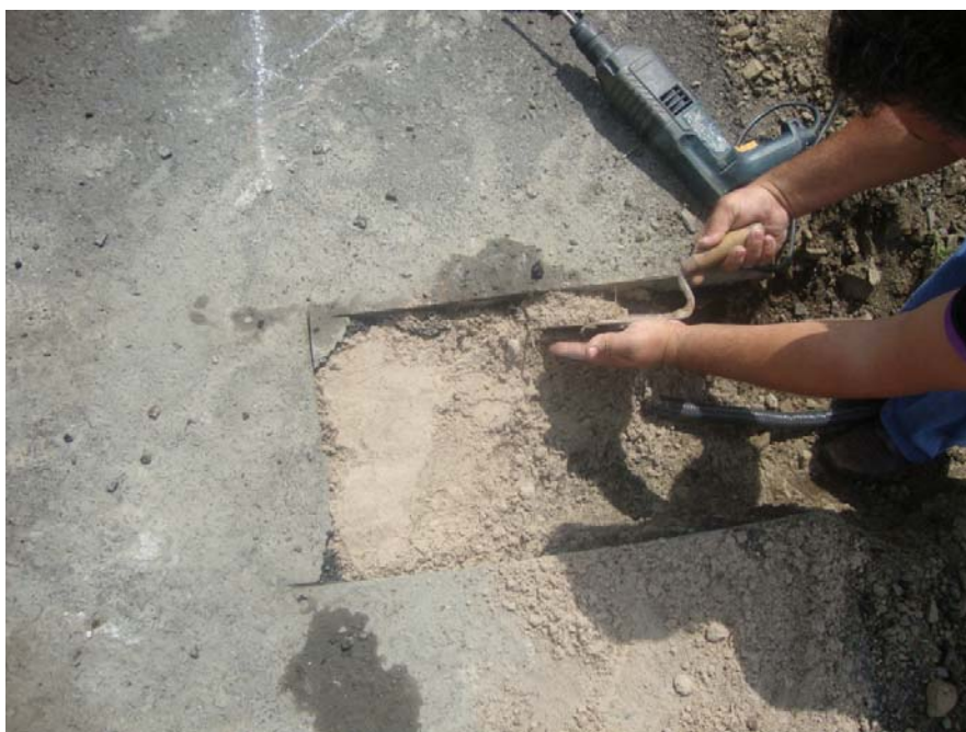
Figura 48: Acabamento final na instalação dos sensores no pavimento asfáltico.
