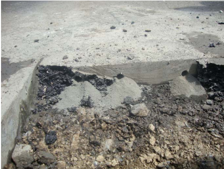
Figura 43: Perfuração da camada de CBUQ para instalação dos sensores.
