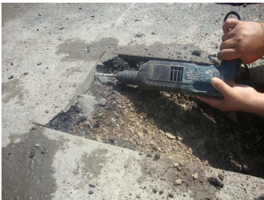
Figura 42: Perfuração da camada de CBUQ para instalação dos sensores.
