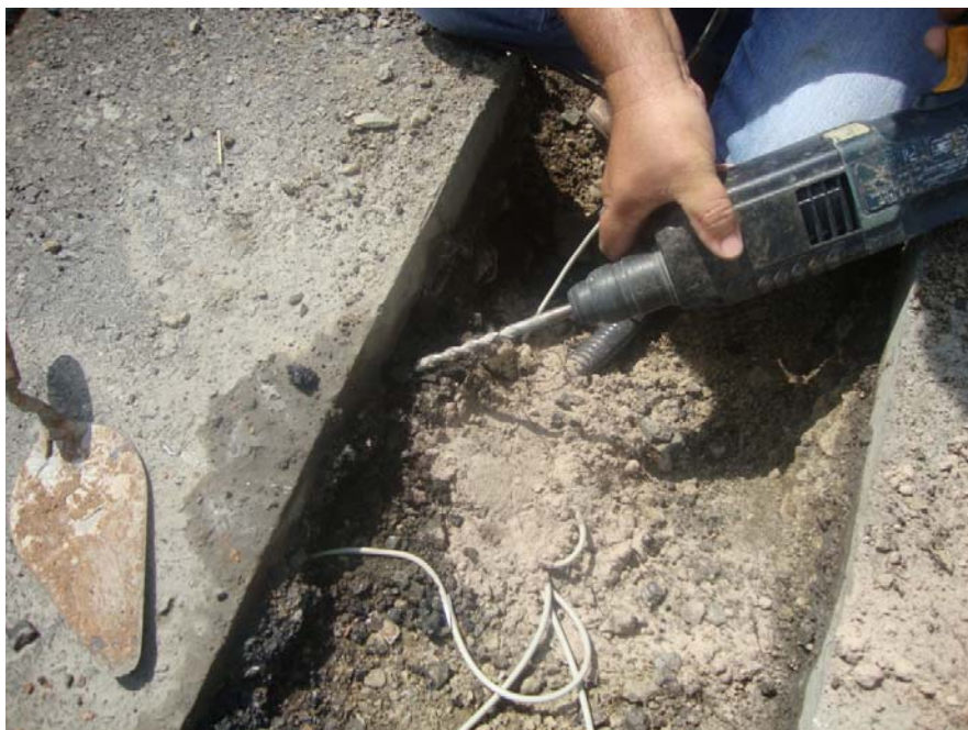
Figura 45: Adequação e instalação dos sensores na camada de base.
