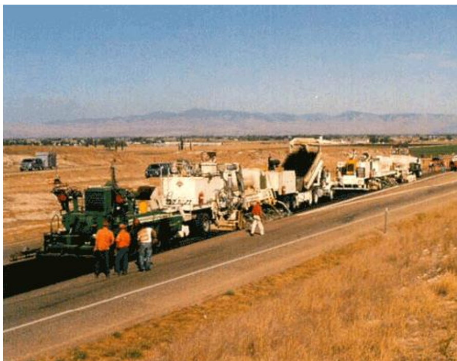
Figura 24: Vista parcial do processo de remistura
