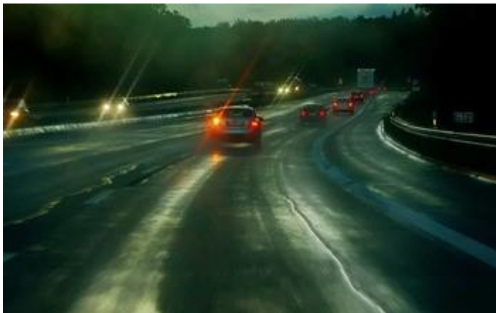
Figura 16: Afundamento em trilha de roda com presença de água na superfície
