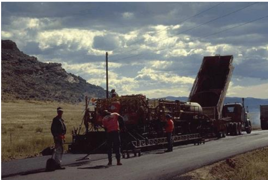
Figura 22: Processo de repavimentação
