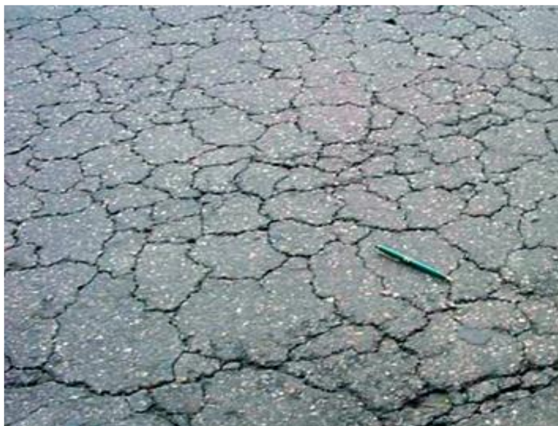
Figura 17: Revestimento em avançado grau de fissuração
