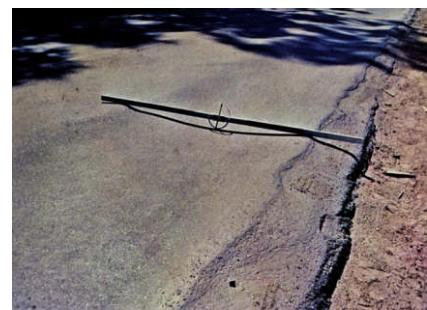
Figura: Afundamento de trilha de roda (DNIT 005/2003-TER).
