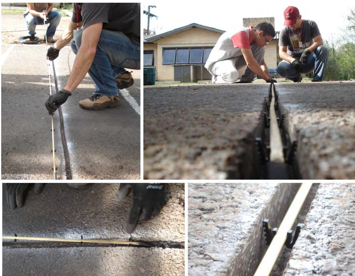
Figura 37 - Processo de instalação dos sensores
