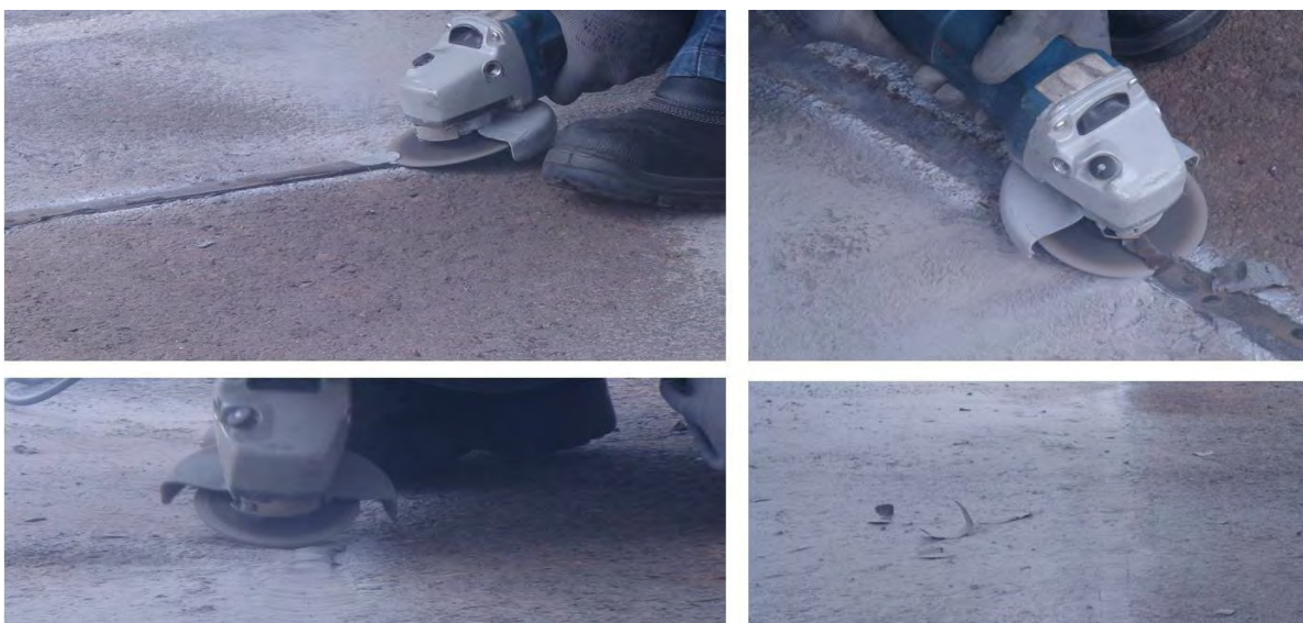
Figura 73 – Processo de acabamento do Grout
