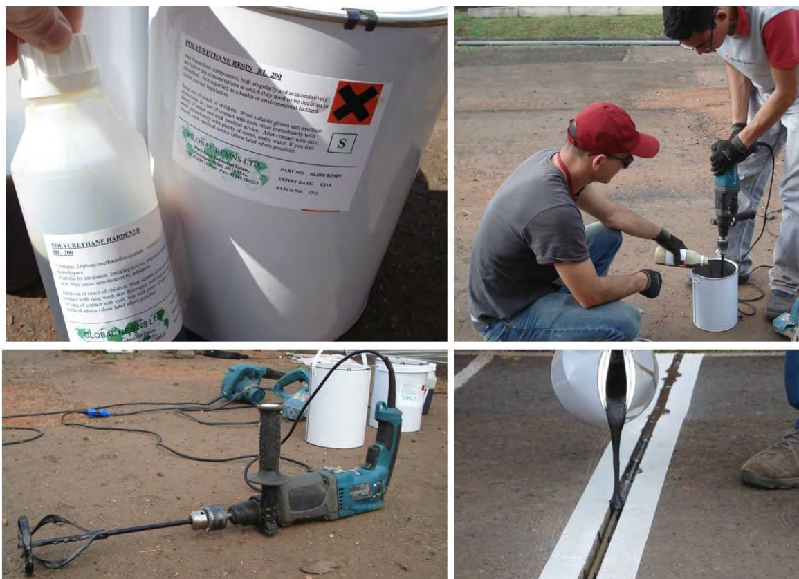
Figura 40 – Preparação do grout para selagem dos cortes
