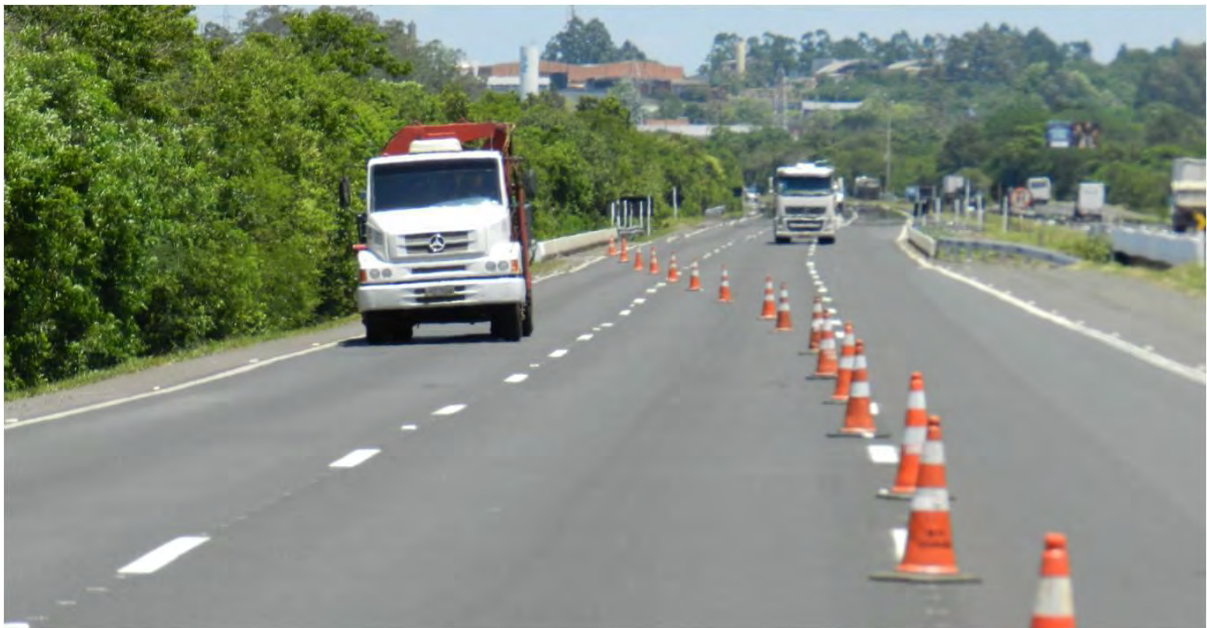
Figura 59 – Sinalização e desvio do tráfego para realização da instalação dos sensores
