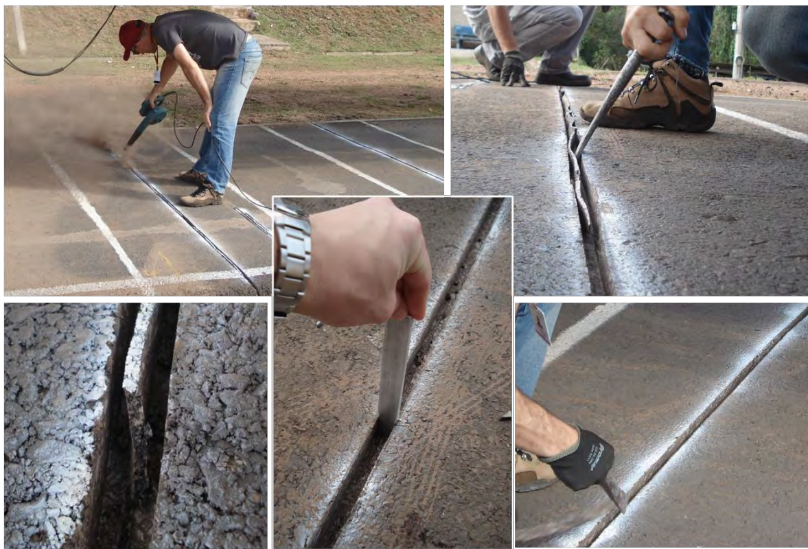
Figura 33 - Limpeza dos cortes e conferência de dimensões
