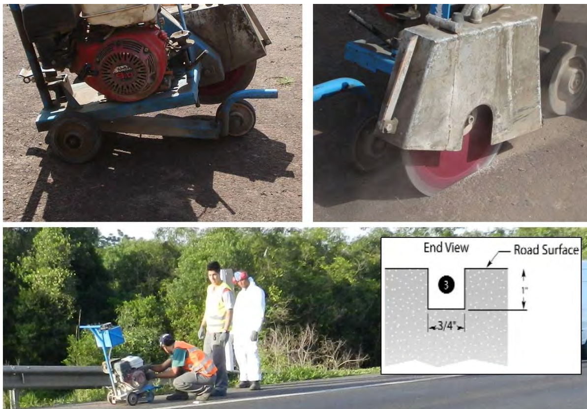
Figura 60 – Processo de regulagem da profundidade de corte do equipamento
