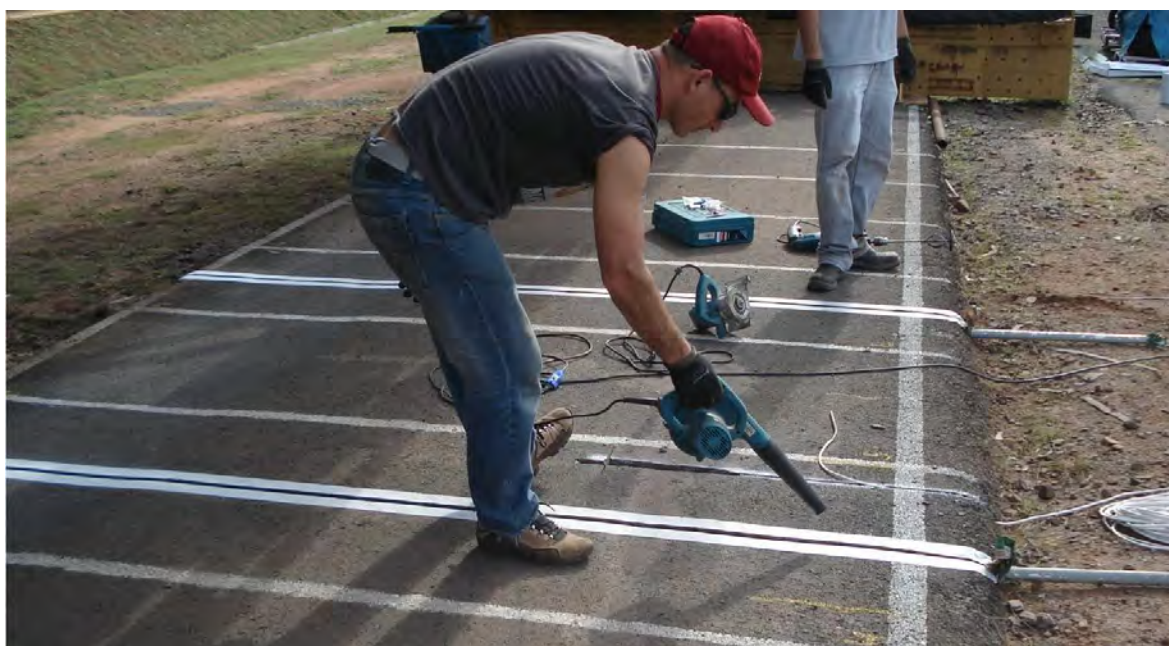
Figura 39 – Limpeza final dos cortes e revestimento
