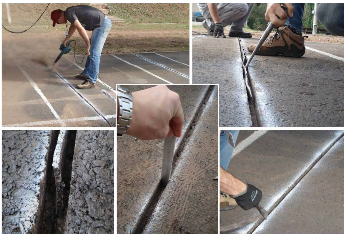
Figura 41 - Selagem dos cortes após instalação dos sensores
