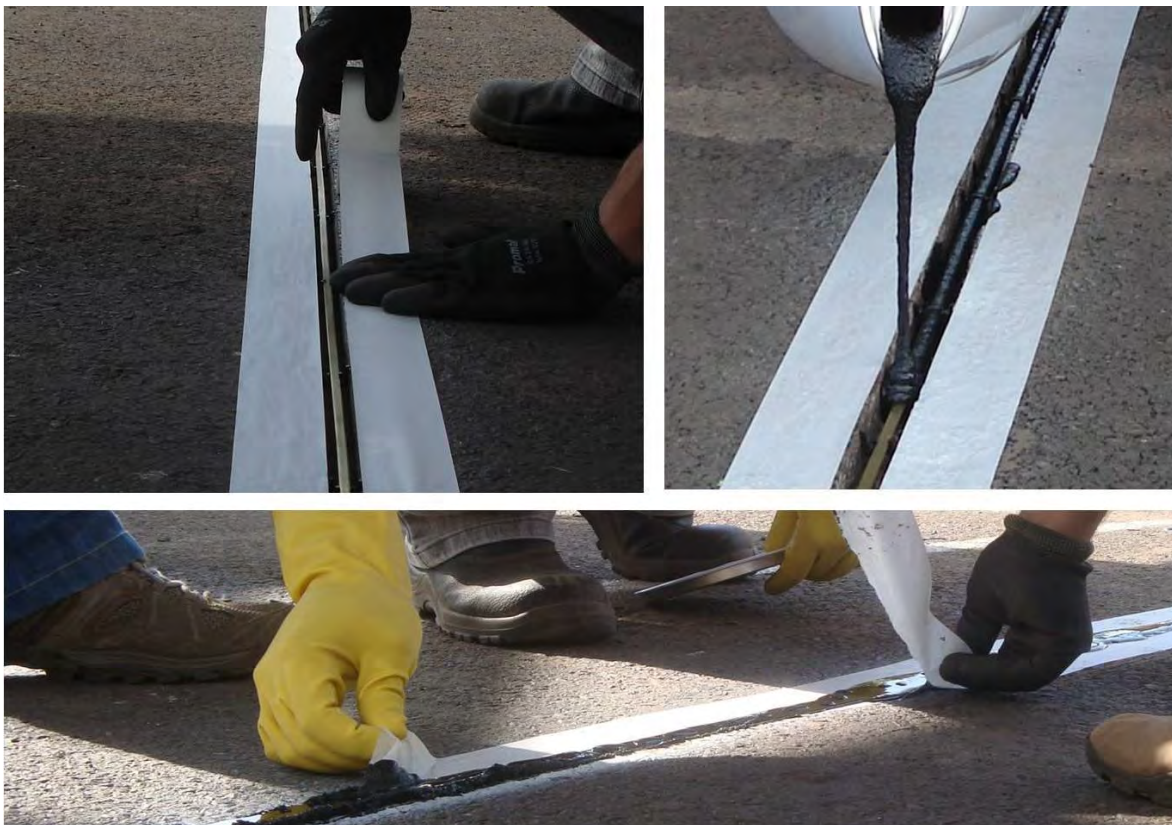
Figura 72 - Selagem dos cortes após instalação dos sensores
