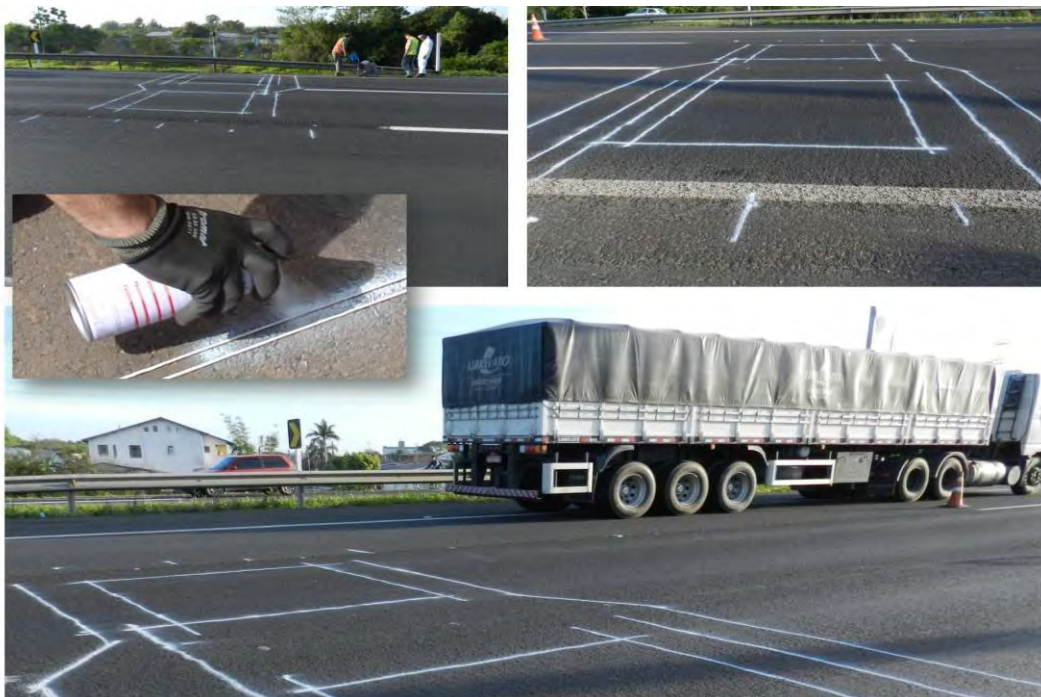
Figura 63 - Marcação e pintura para instalação dos sensores
