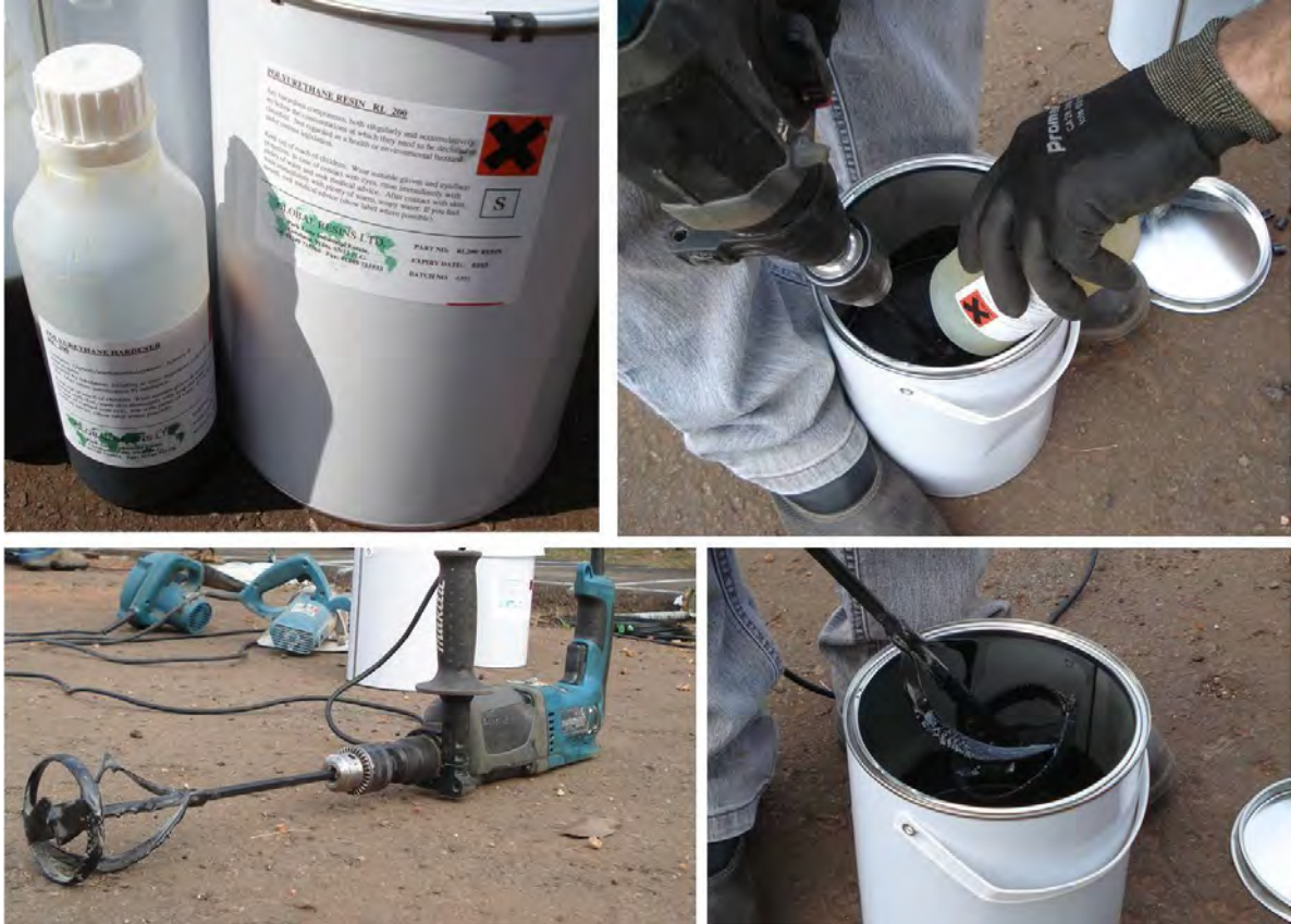
Figura 71 – Preparação do grout para selagem dos cortes
