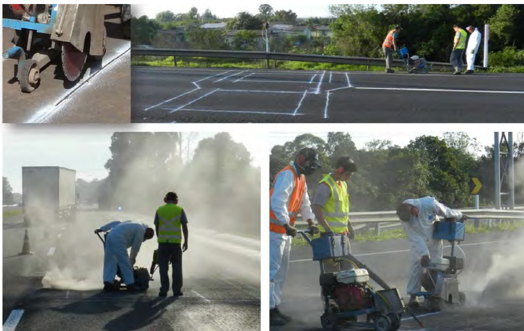
Figura 65 - Realização dos cortes no pavimento
