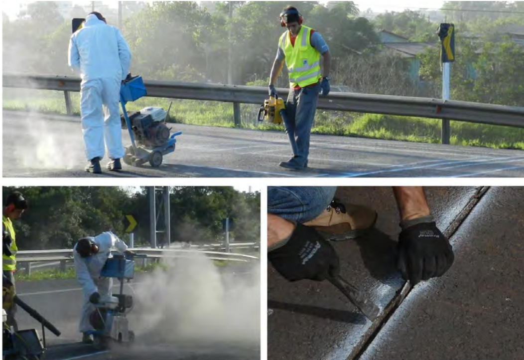
Figura 66 - Limpeza dos cortes e conferência de dimensões
