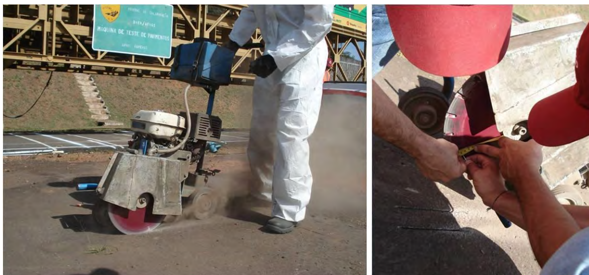
Figura 27 – Realização de “cortes testes” em pavimento na área de testes
