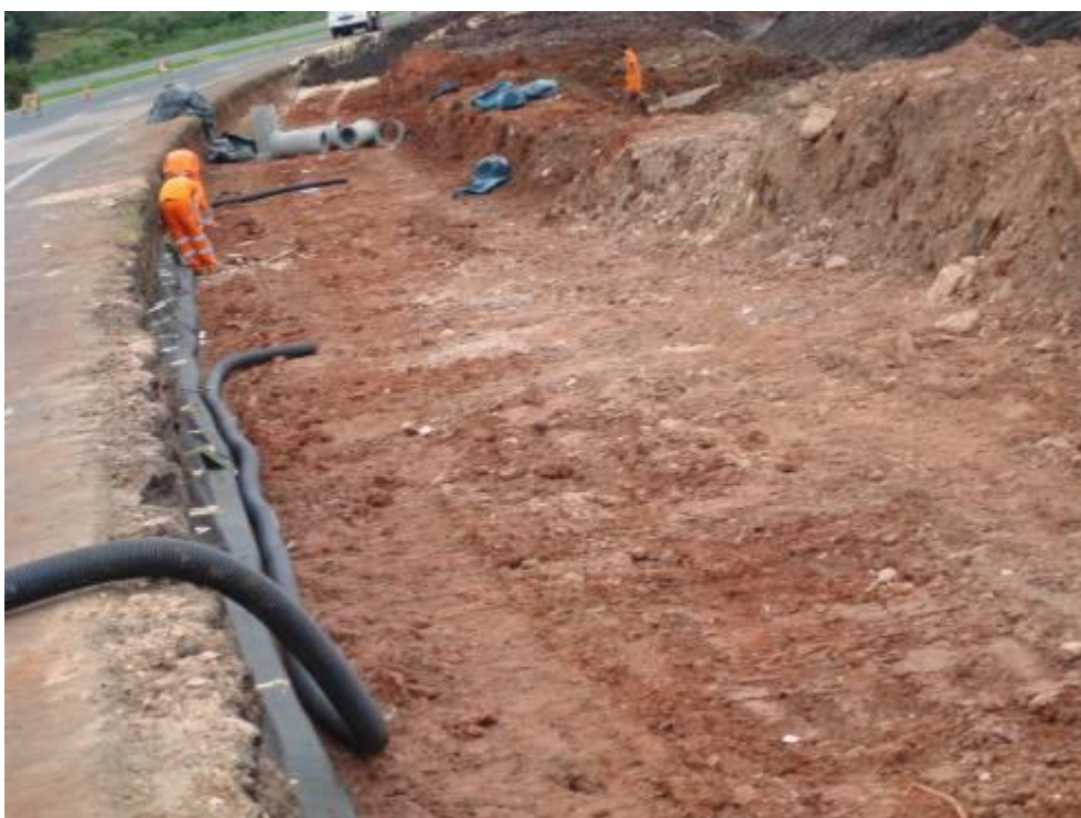
Figura 13. Sistema de drenagem no trecho monitorado – dreno longitudinal
