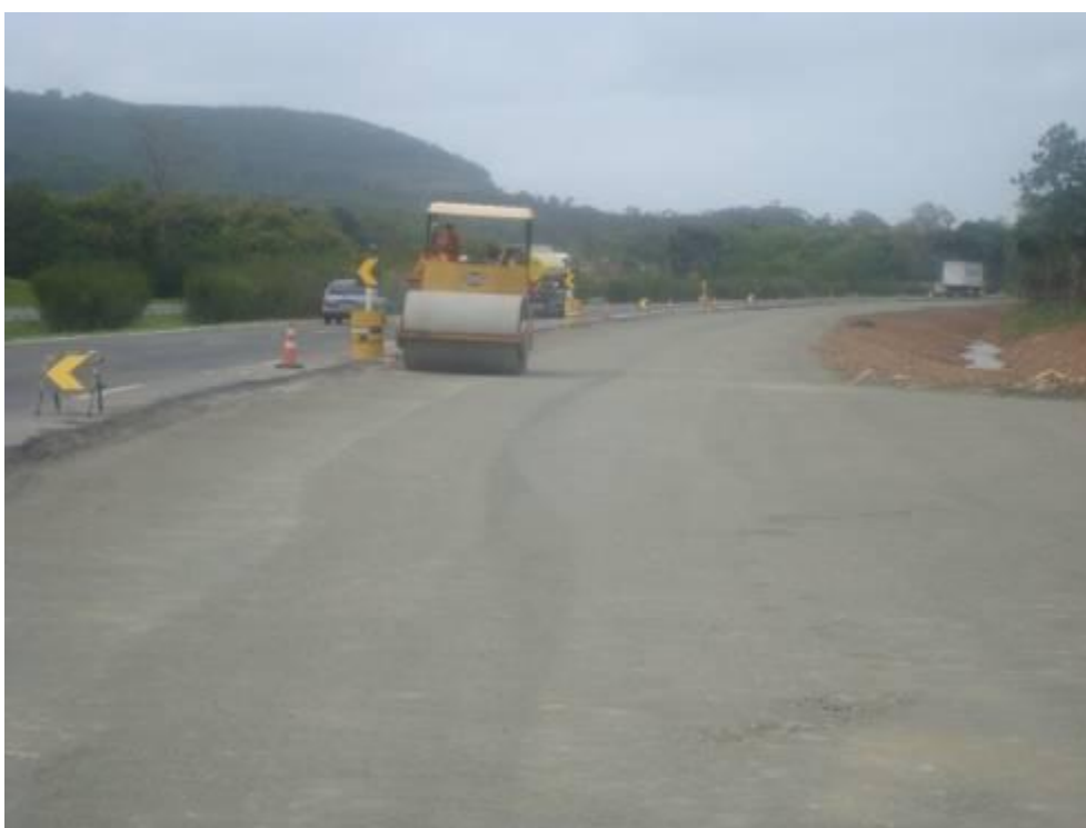
Figura 24. Camada de Base com Brita Graduada
