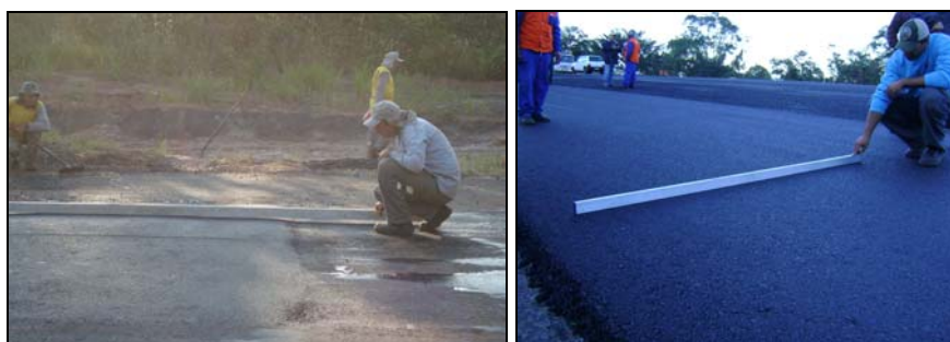
Figura 41: Exemplo de Régua para controle de acabamento de superfície
