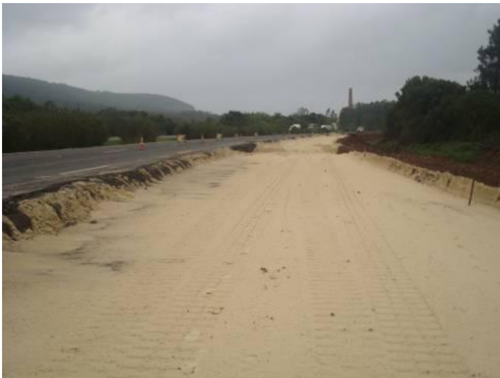
Figura 21. Execução da camada de areia
