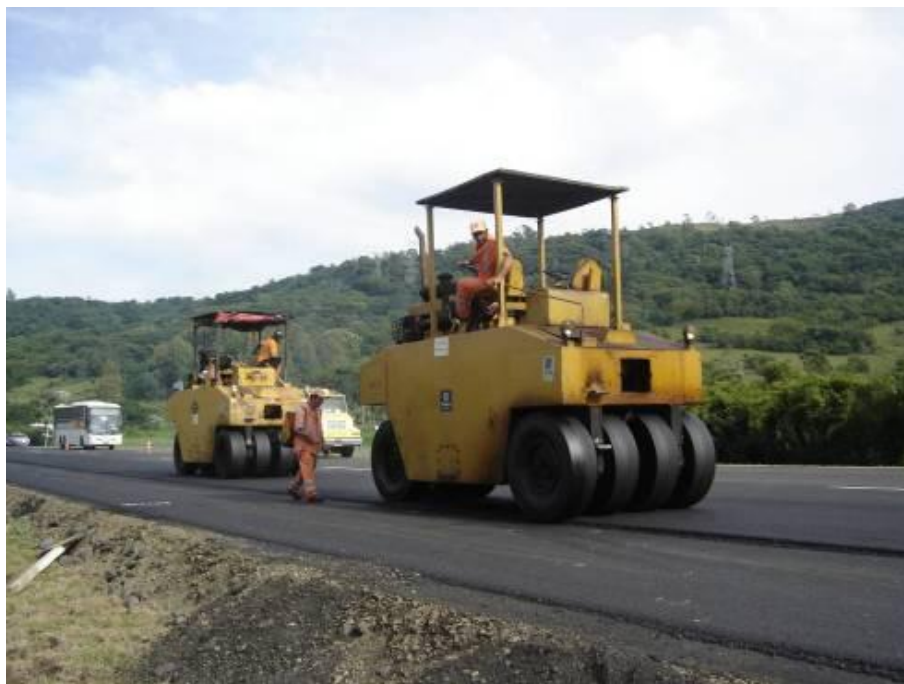
Figura 29. Compactação da camada de revestimento asfáltico
