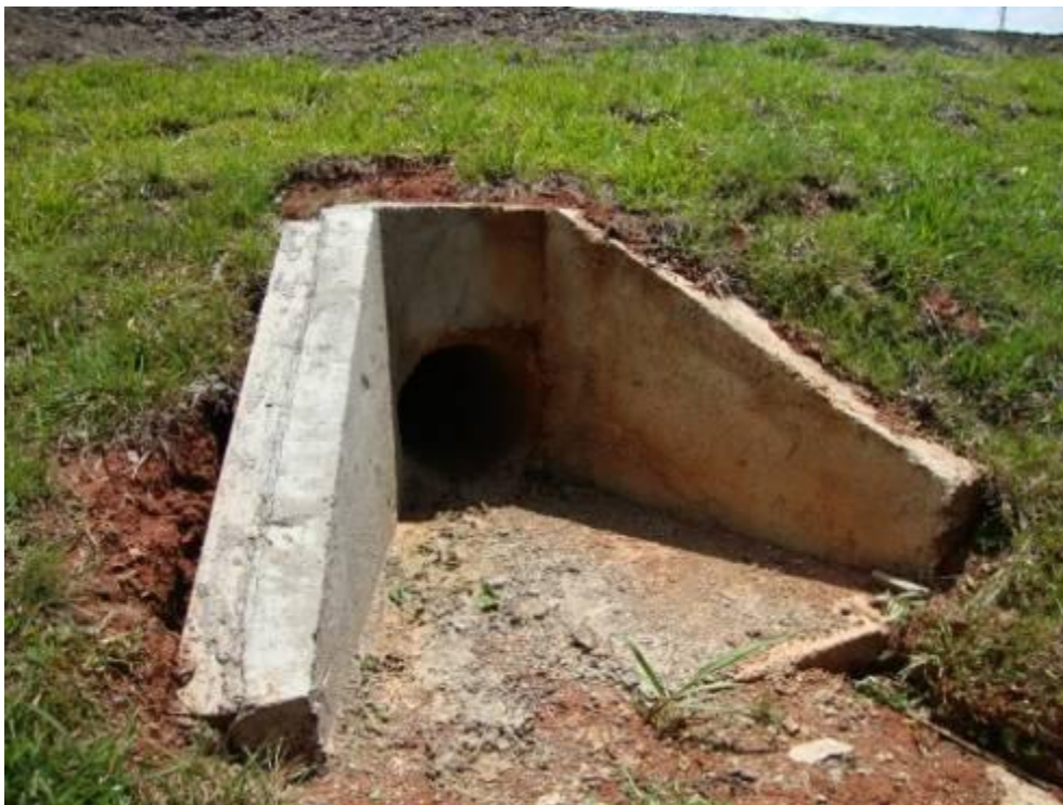
Figura 12. Sistema de drenagem no trecho monitorado – bueiro transversal
