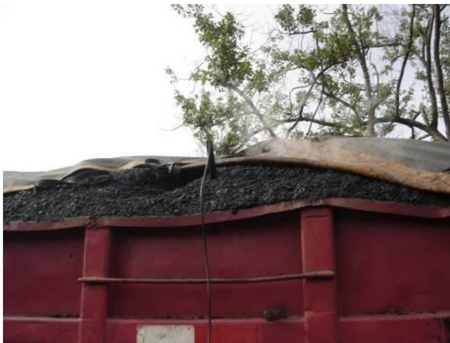
Figura 27. Controle da temperatura da massa no momento da chegada do caminhão
