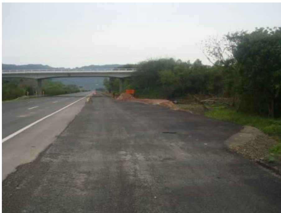
Figura 25. Camada de Revestimento Asfáltico
