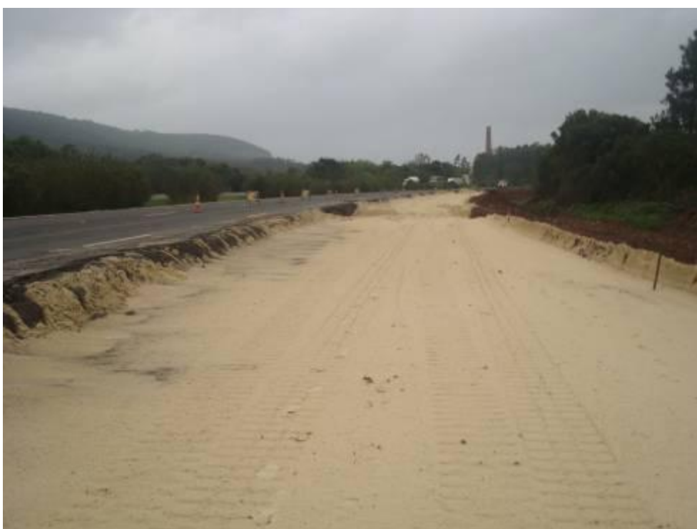
Figura 21. Execução da camada de areia
