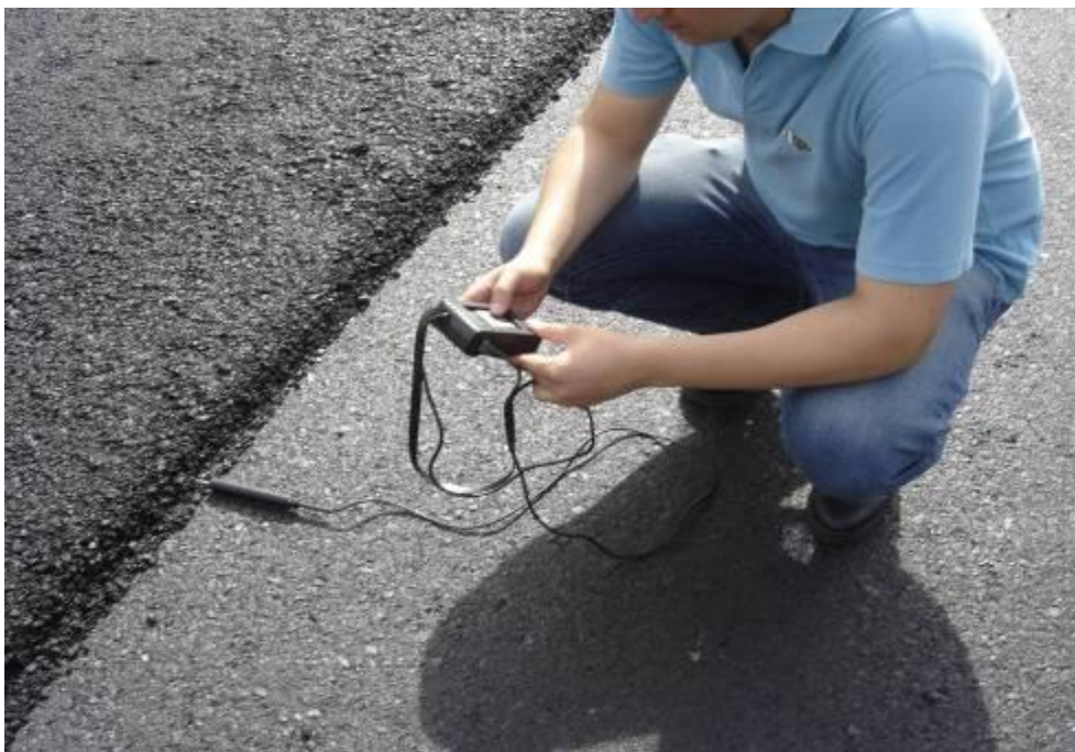
Figura 28. Controle da temperatura da massa antes da compactação
