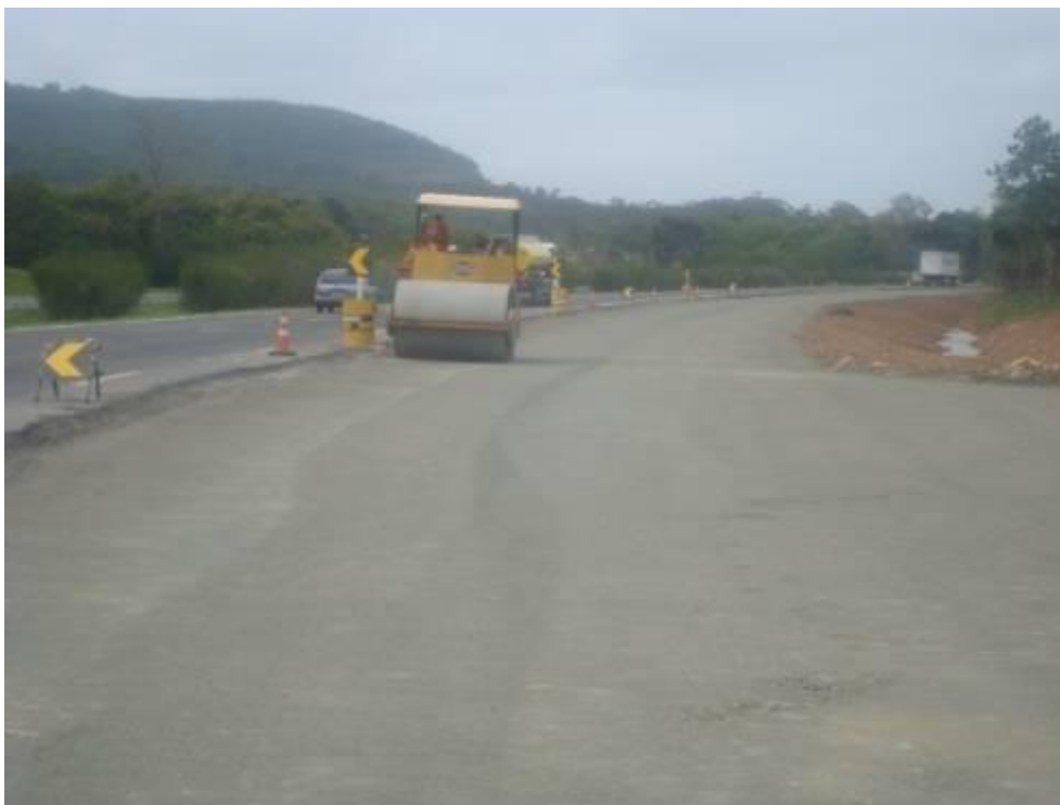
Figura 24. Camada de Base com Brita Graduada
