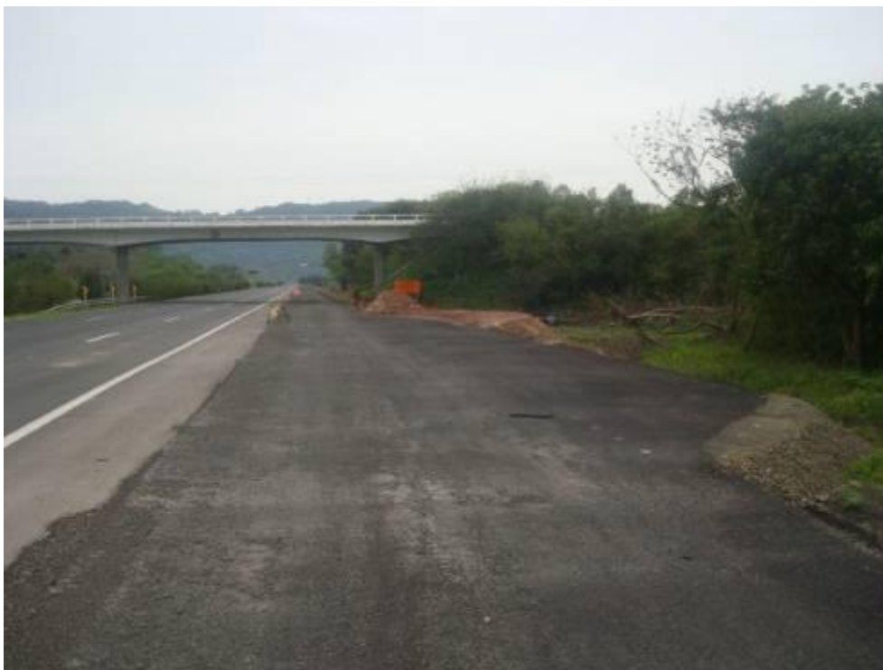
Figura 25. Camada de Base com Brita Graduada
