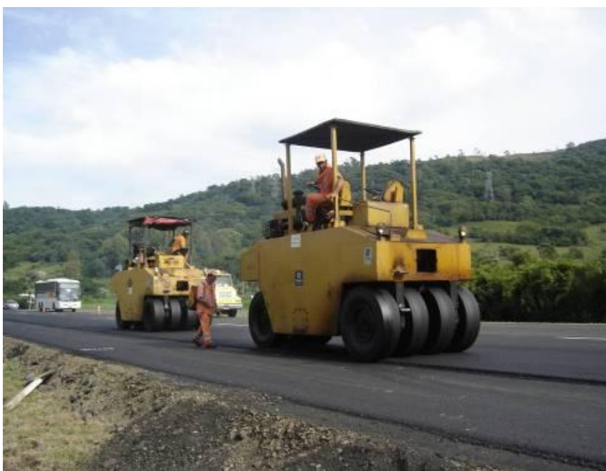
Figura 29. Compactação da camada de revestimento asfáltico
