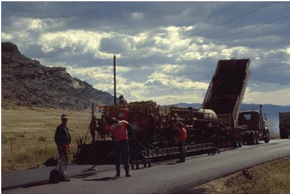
Figura 4 – Processo de Repavimentação
