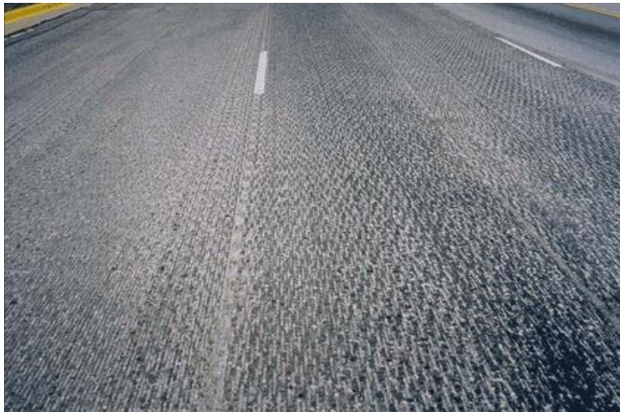
Figura 1 – Superfície típica resultante de fresagem a frio
