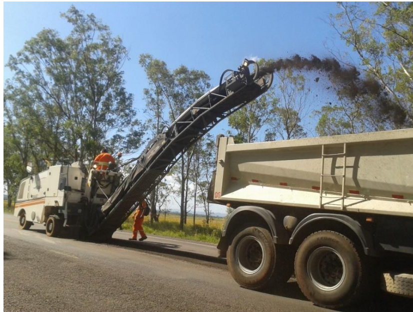
Figura 27 – Coleta da amostra diretamente da fresadora
