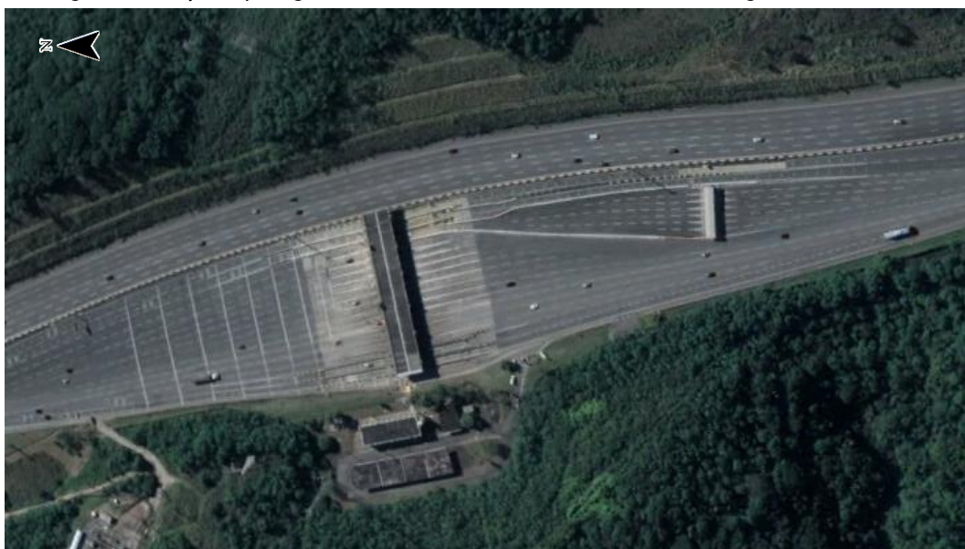
Figura 7 - Praça de pedágio com cabines ramificadas - Rodovia dos Imigrantes, São Paulo
