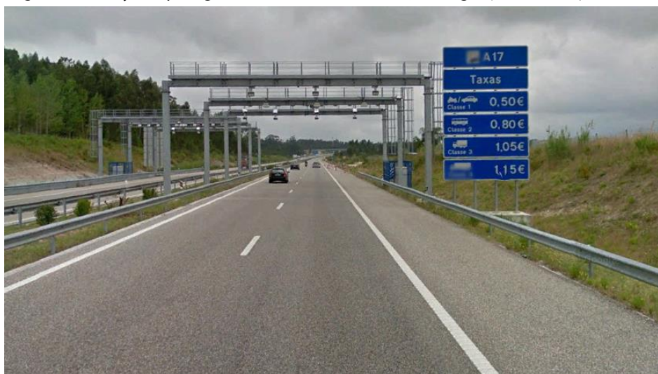
Figura 12 - Praça de pedágio na SCUT Costa da Prata, Portugal (street view) - Pórticos
