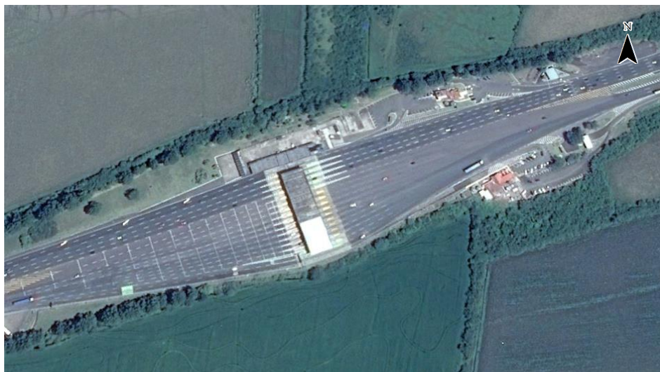
Figura 5 - Praça de pedágio de Santo Antônio da Patrulha (vista aérea)
