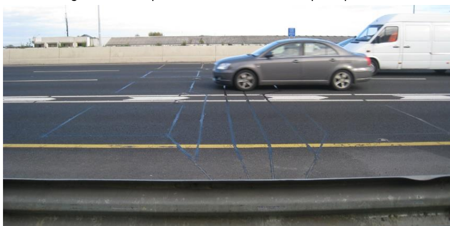
Figura 41 - Exemplo de contador veicular do tipo loop indutivo
