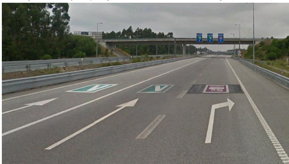
Figura 14 - Praça de pedágio na SCUT Costa da Prata, Portugal (street view)
