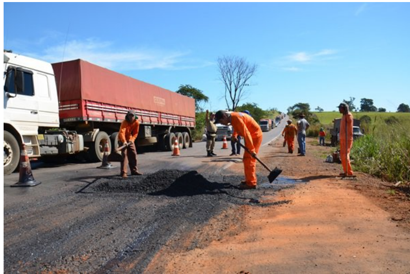
Figura 3 – Execução de tapa-buracos
