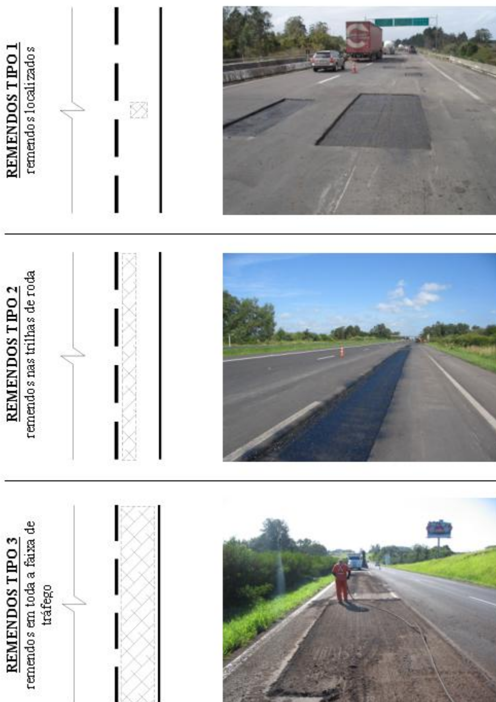
Figura 65: Representação esquemática dos 3 tipos de remendos profundos usualmente executados na rodovia BR-290/RS
