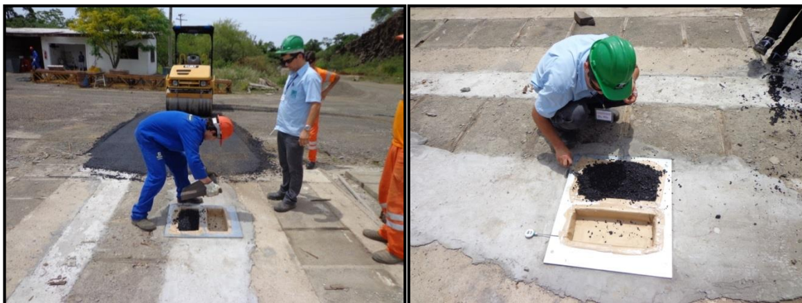
Figura 56: Processo de preenchimento dos moldes com massa asfáltica.
