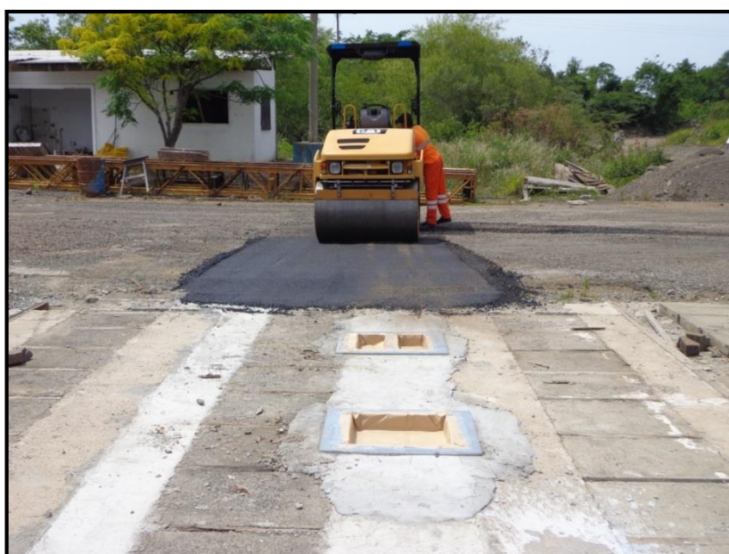
Figura 52: Pista de moldagem confeccionada da Usina de Asfalto da Construtora Triunfo para produção de placas de misturas asfálticas.
