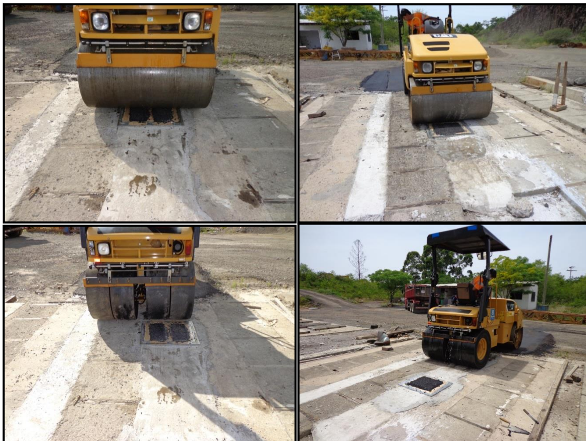
Figura 60: Processo de compactação das placas de mistura asfáltica.
