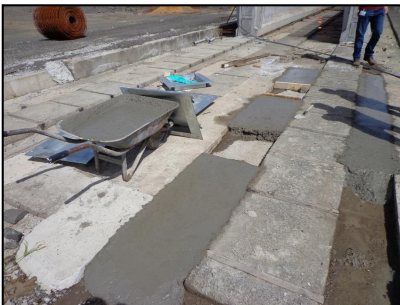
Figura 50: Adaptação da pista de concreto para colocação das bases e moldes metálicos.
