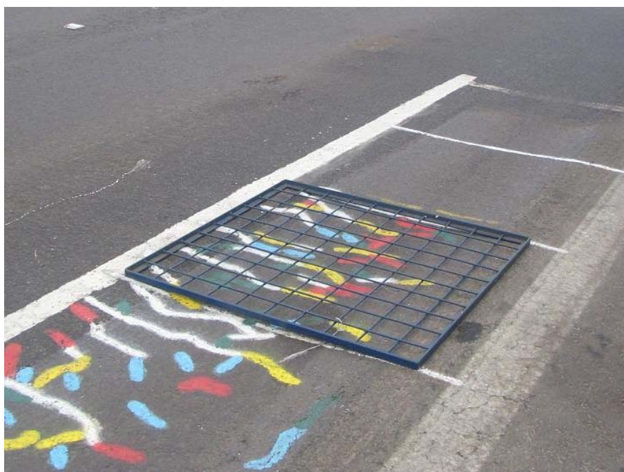
Figura 4.20: Controle da evolução do trincamento
