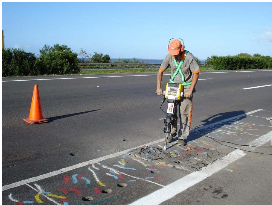
Figura 4.29: Abertura de poços de inspeção no trecho ensaiado pelo Simulador de Tráfego
