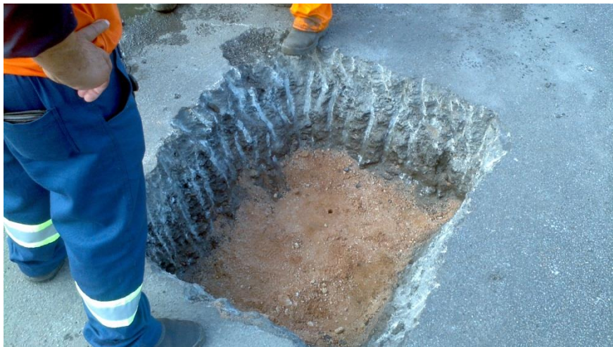
Inspeção visual da camada subjacente (sub-base de Solo-Brita - SB)
