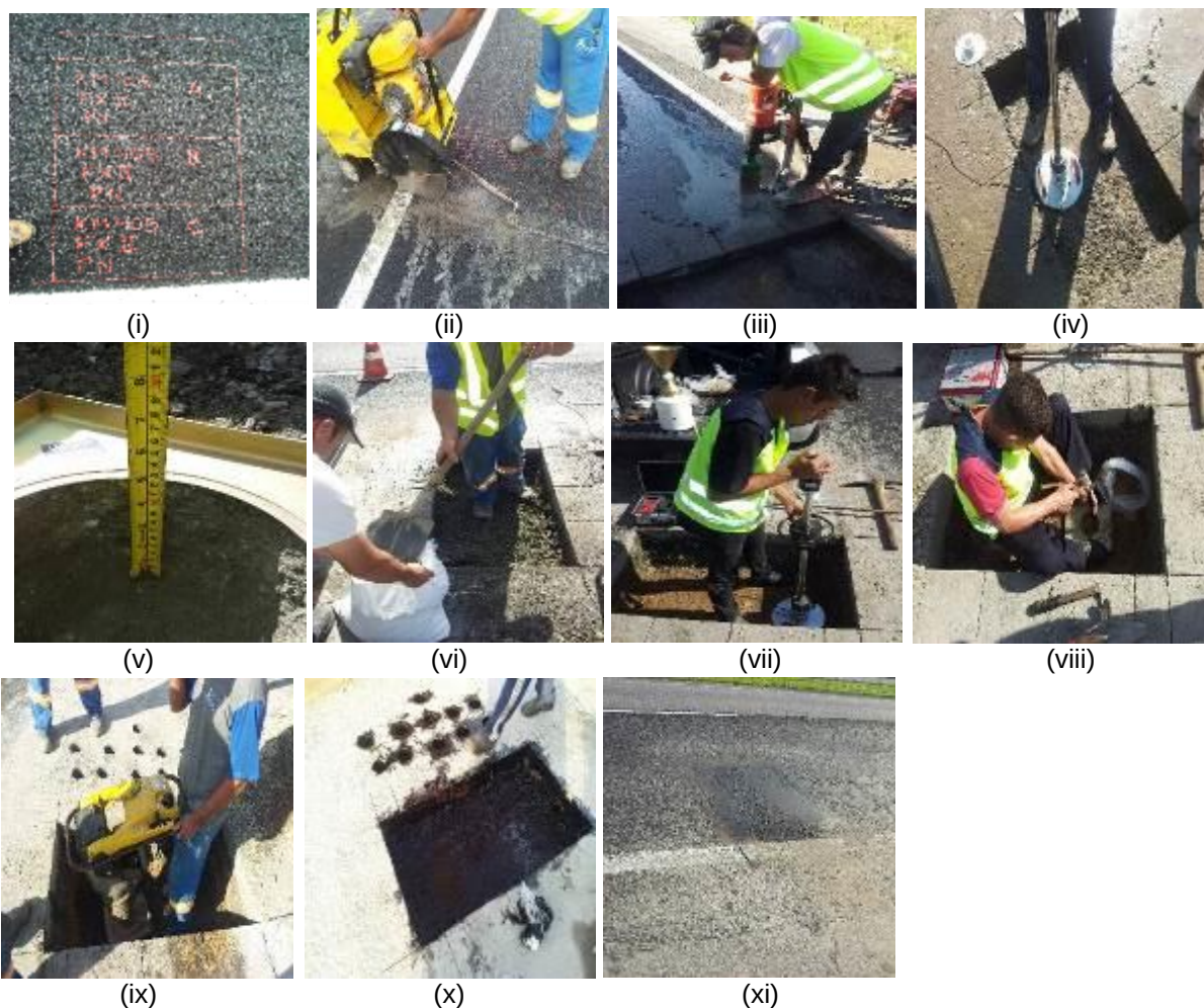
Figura 157: Etapas de trabalho do poço de inspeção km 405 (Pista Norte)
