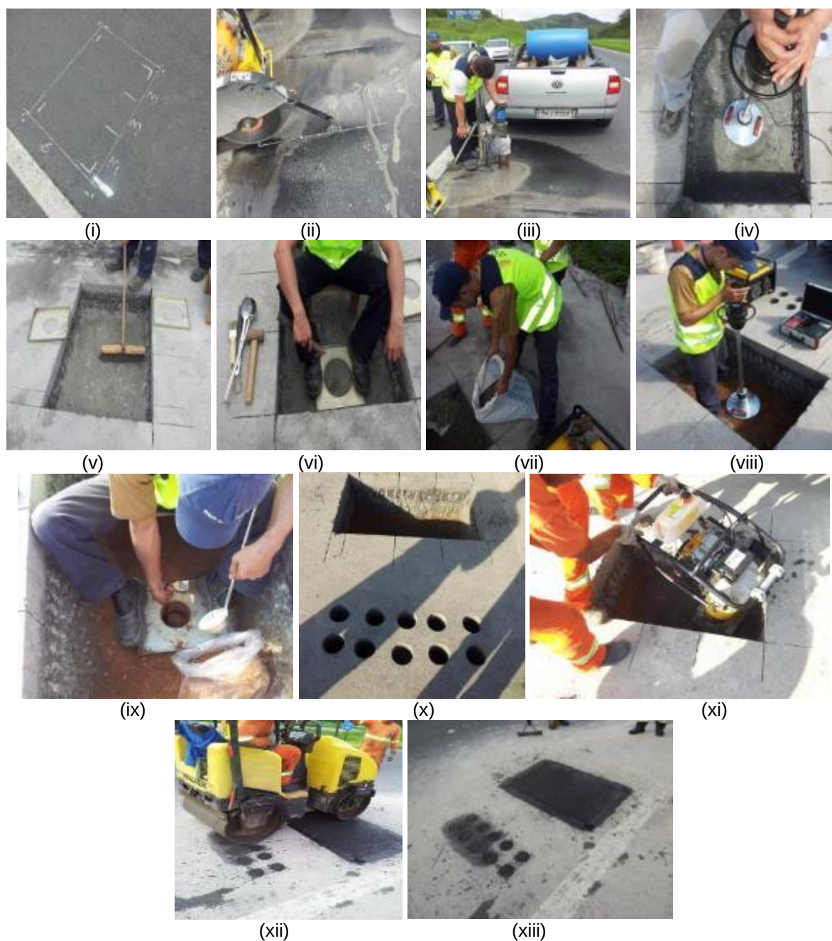
Figura 159: Etapas de trabalho do poço de inspeção km 418 (Pista Norte)
