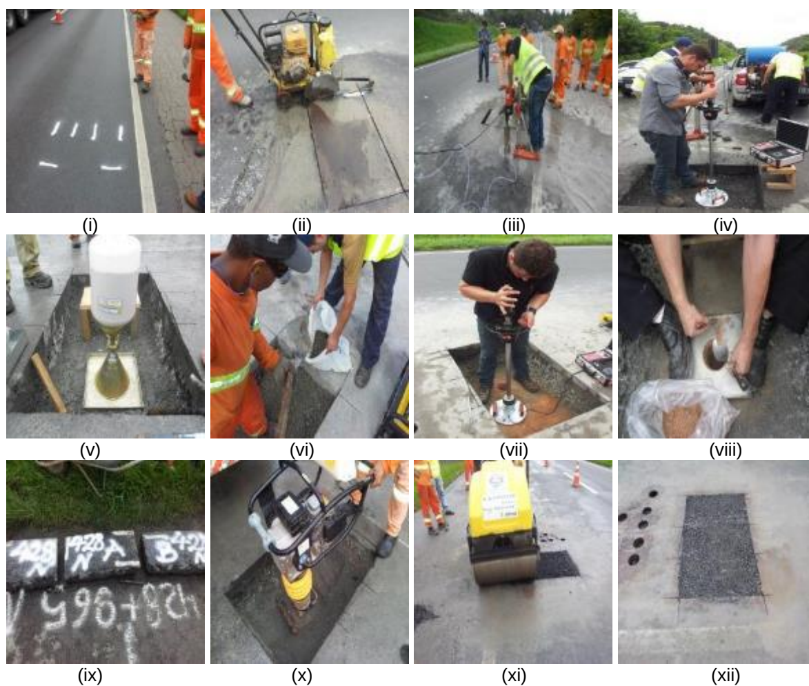
Figura 161: Etapas de trabalho do poço de inspeção km 429 (Pista Norte)
