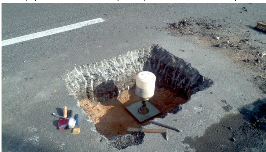
Ensaio de densidade "in situ" (funil e areia)
