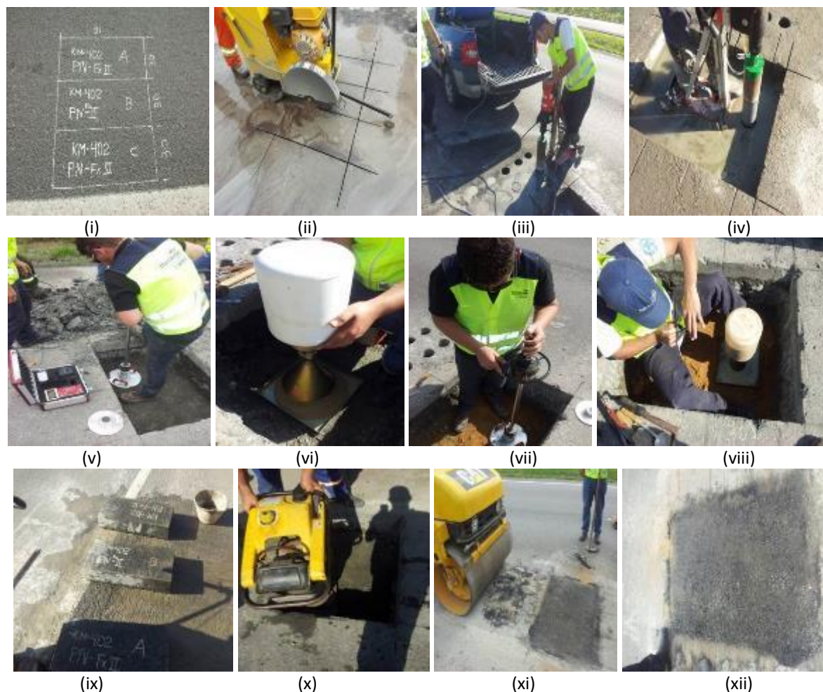
Figura 156: Etapas de trabalho do poço de inspeção km 402 (Pista Norte)
