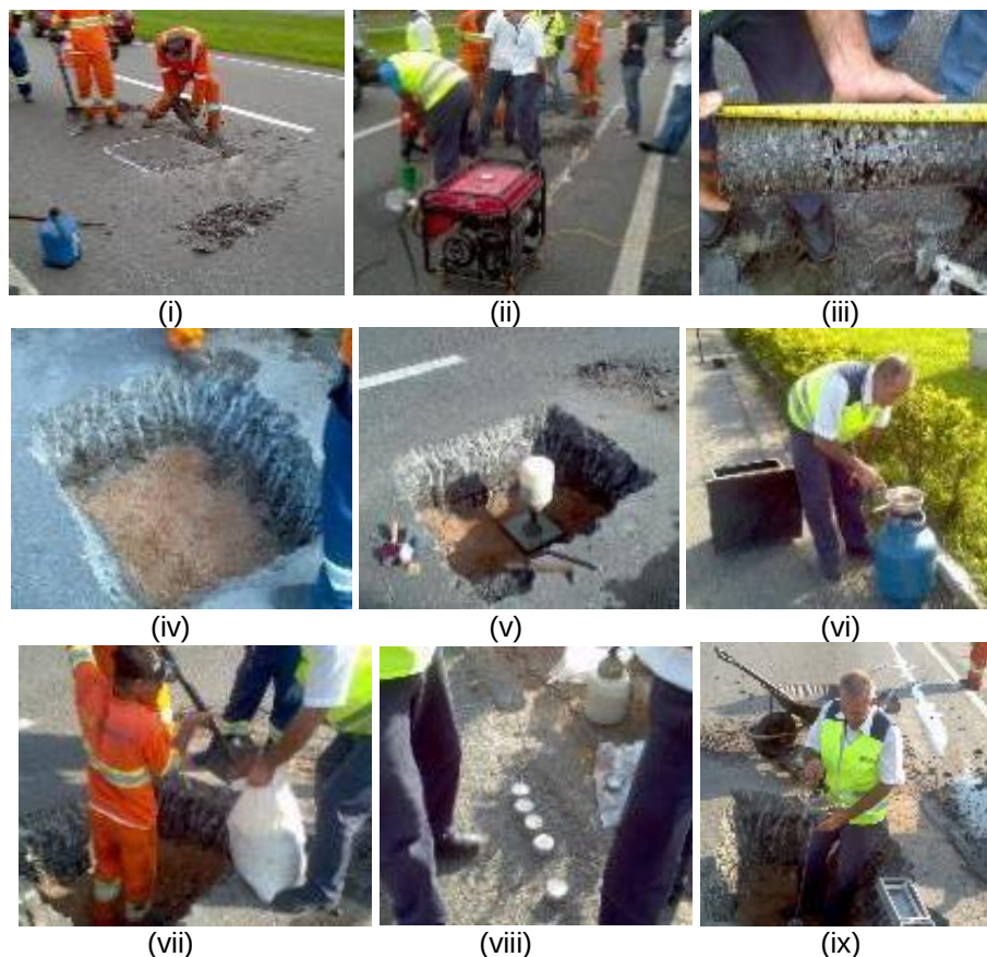
Figura 158: Etapas de trabalho do poço de inspeção km 414 (Pista Sul)
