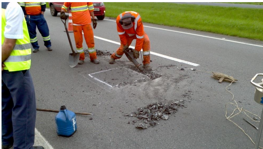
Demarcação e abertura do poço de inspeção
