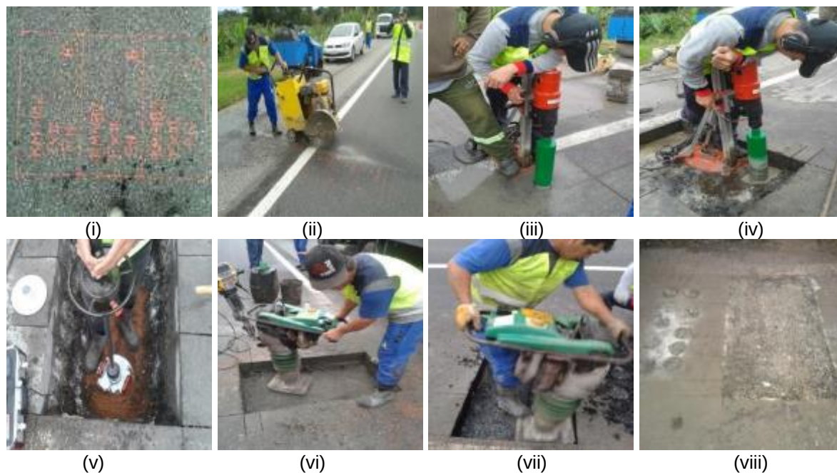
Figura 167: Etapas de trabalho do poço de inspeção km 482 (Pista Sul)
