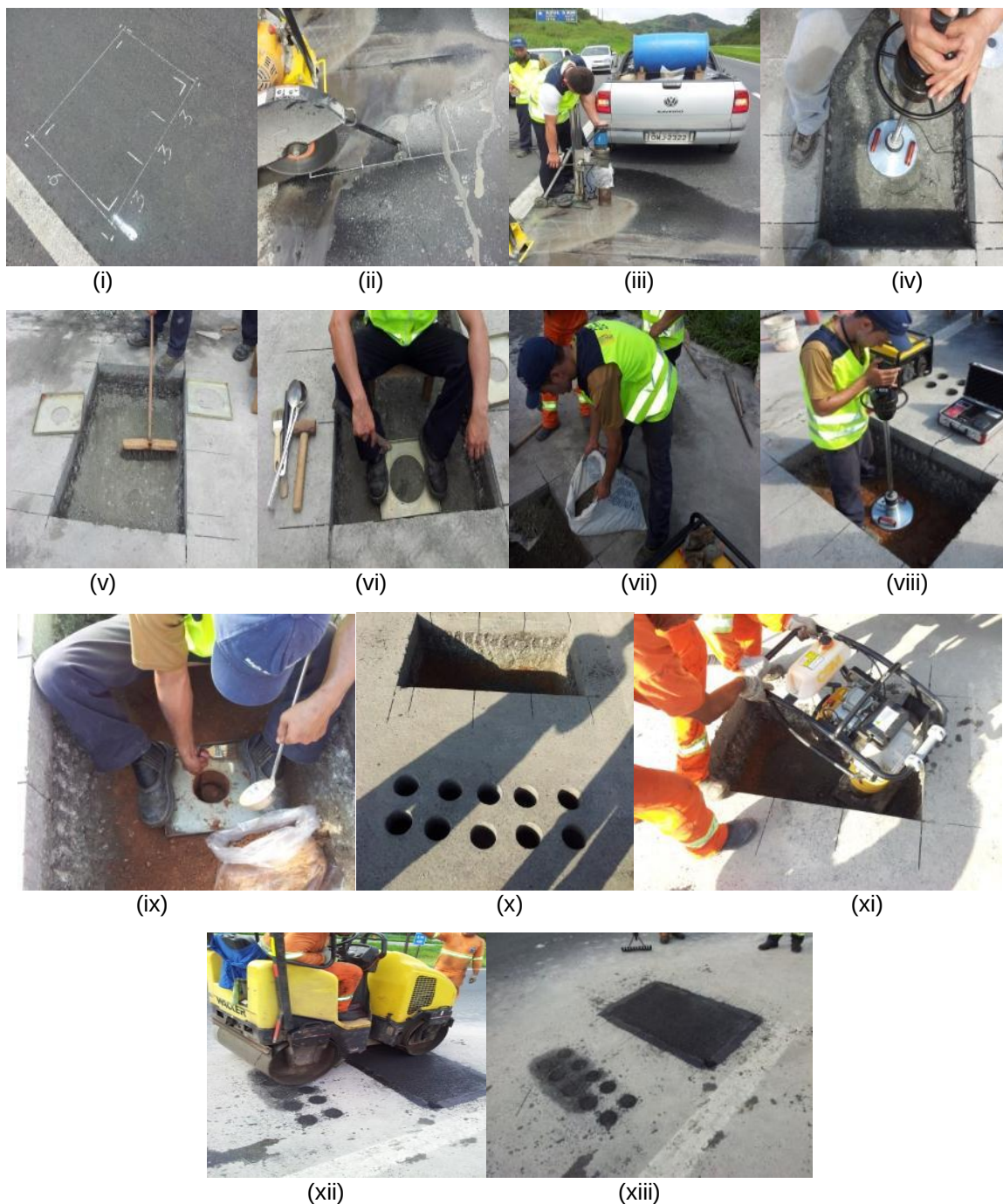
Etapas de trabalho do poço de inspeção km 418 (Pista Norte)
