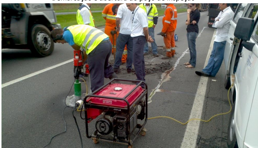
Sondagem com sonda rotativa (serra copo)
