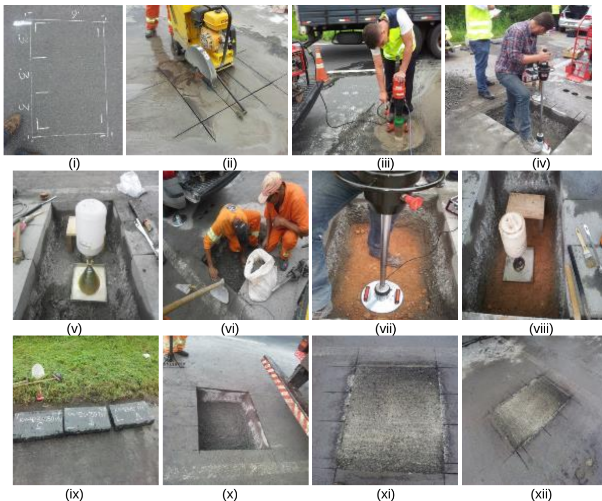
Figura 160: Etapas de trabalho do poço de inspeção km 423 (Pista Norte)
