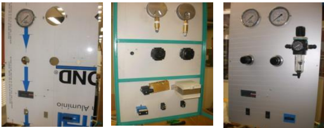
Figura 108 – Montagem do painel de comando
