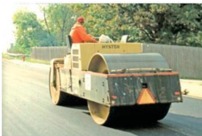
Figura 8 – Rolo compactador de chapa metálica
