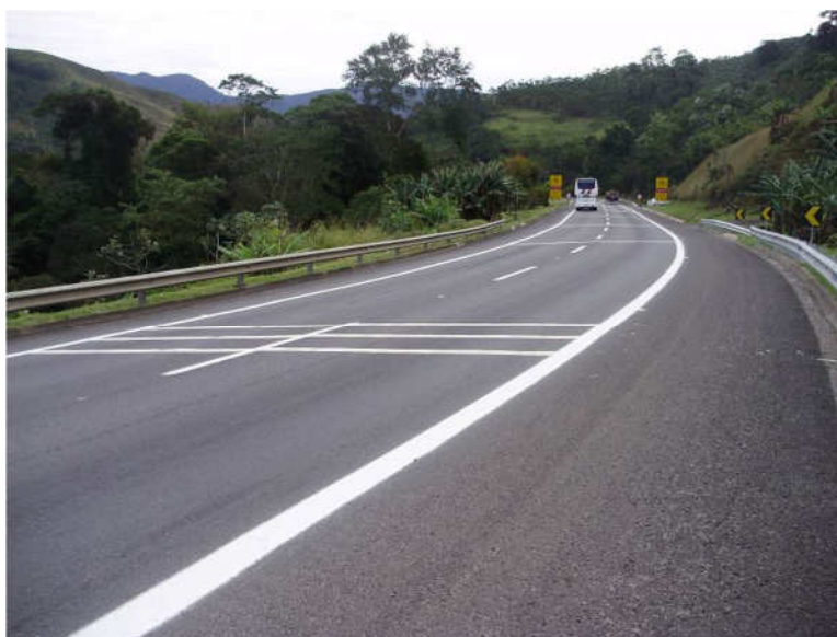
Figura 4.5: Aspecto da sinalização horizontal implantada
