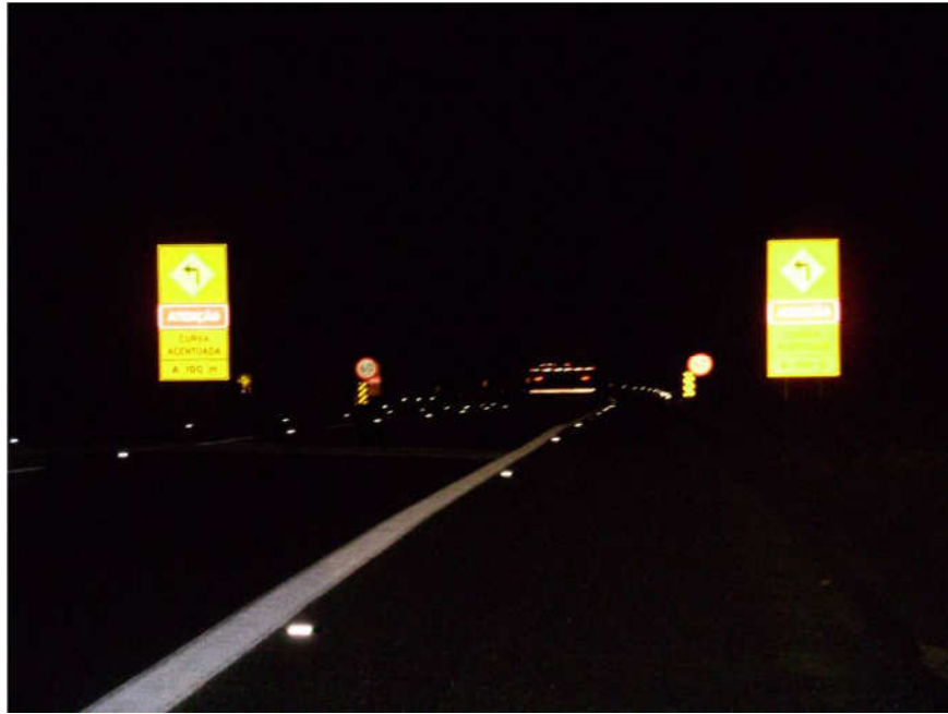
Figura 4.8: Sinalização horizontal e vertical de alto impacto visual
