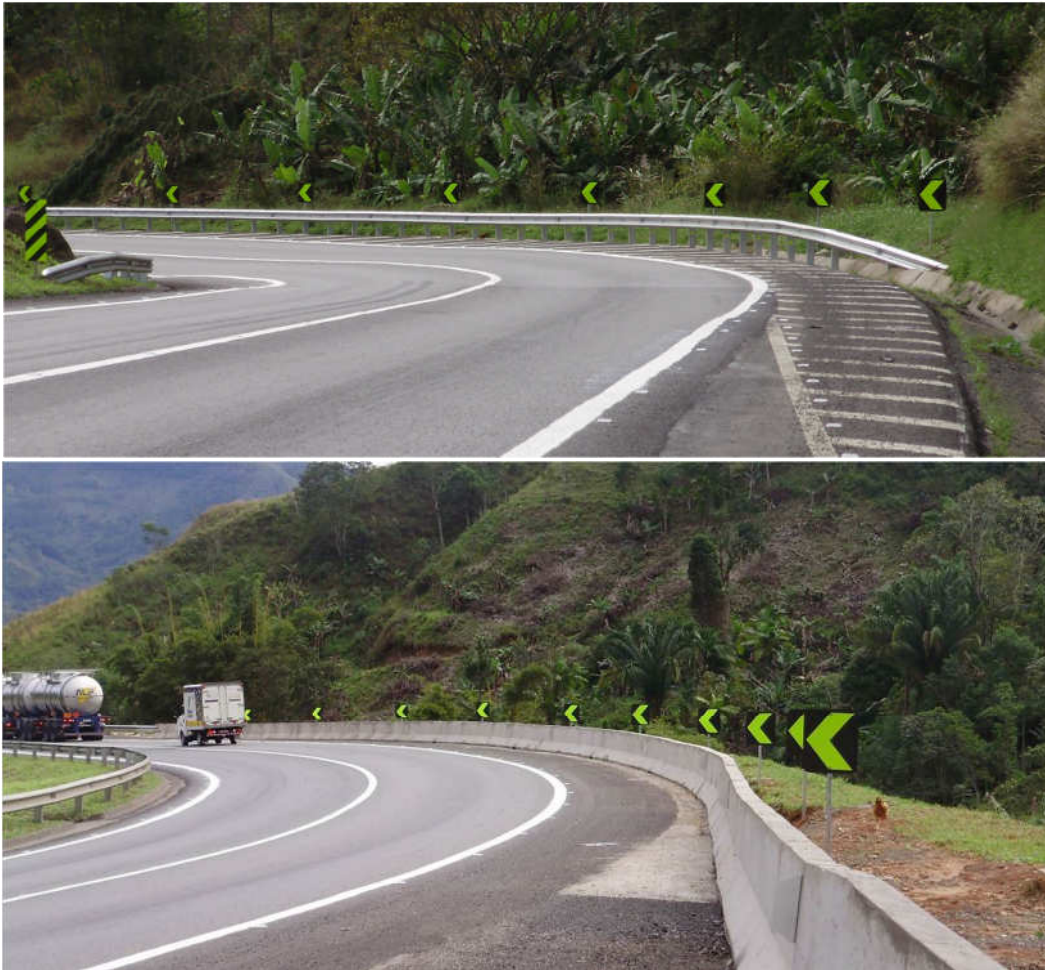
Figura 4.7: Sistemas de contenção lateral usando barreira metálica (acima) e New Jersey (abaixo) implementados no Trecho em estudo
