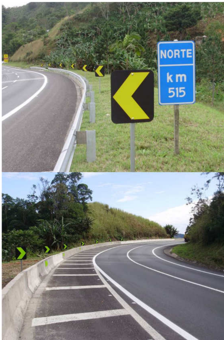
Figura 4.3: Sinalização vertical nas cores amarelo (acima) e lima-limão (abaixo)
