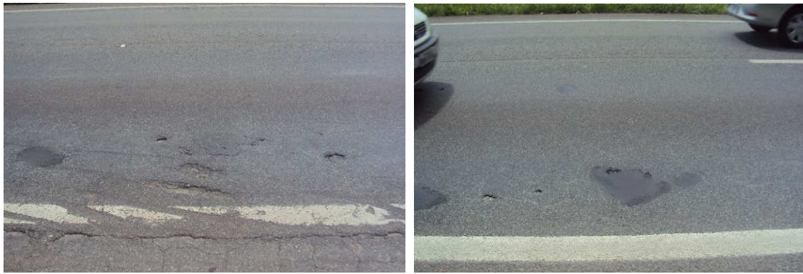
Figura 22 – Segmento com camada de rolamento em CBUQ
