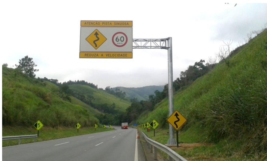
Figura 94. Implantação da placa aérea C-1 no km 510+740
