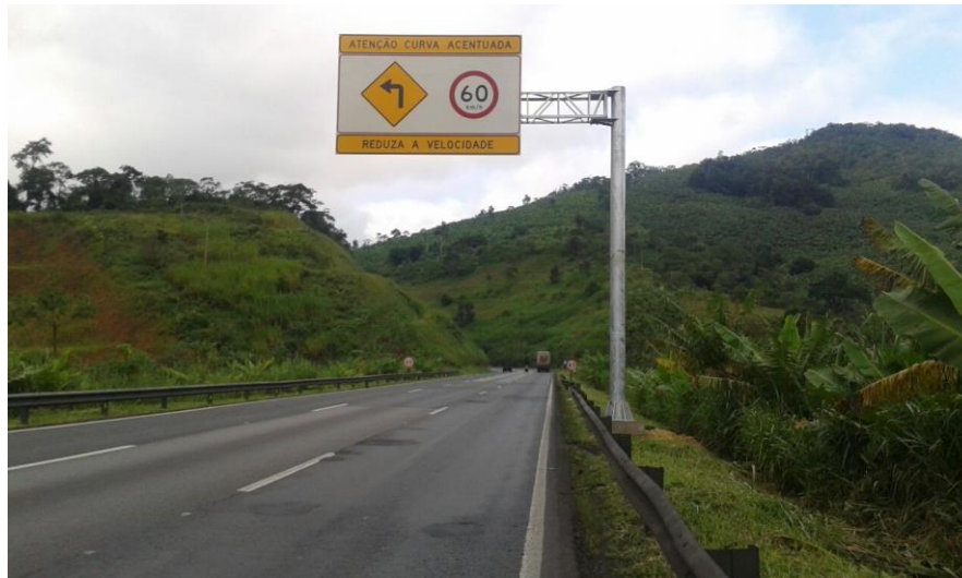
Figura 96. Implantação da placa aérea C-3 no km 514+484
