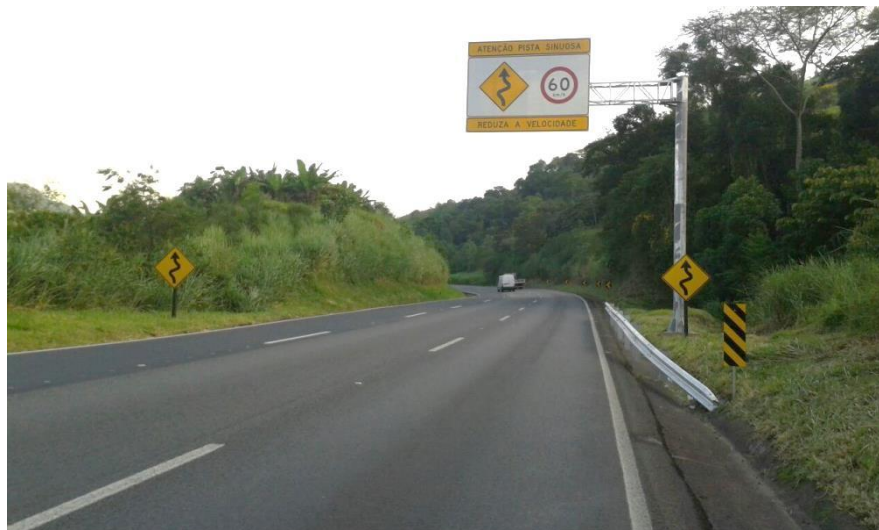
Figura 93. Implantação da placa aérea C-1 no km 508+450
