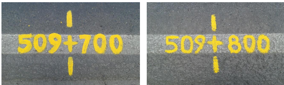
Figura 27. Detalhe da demarcação realizada no trecho em março de 2015
