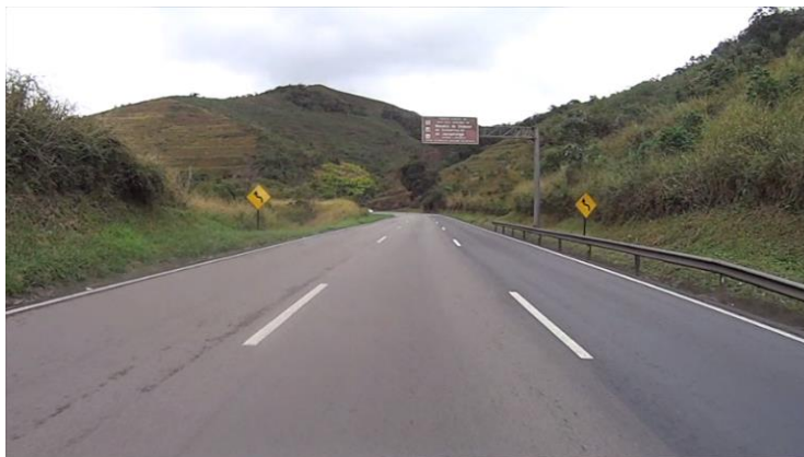
Figura 73. Duas placas muito próximas entre si dividindo inadequadamente a atenção do condutor
