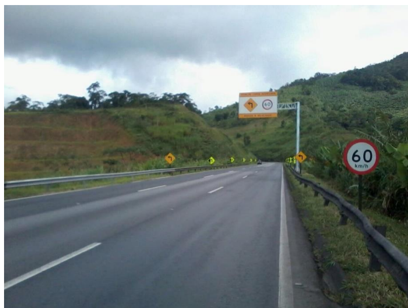
Figura 97. Implantação dos marcadores de alinhamento numerado (MAN) no km 514+541
