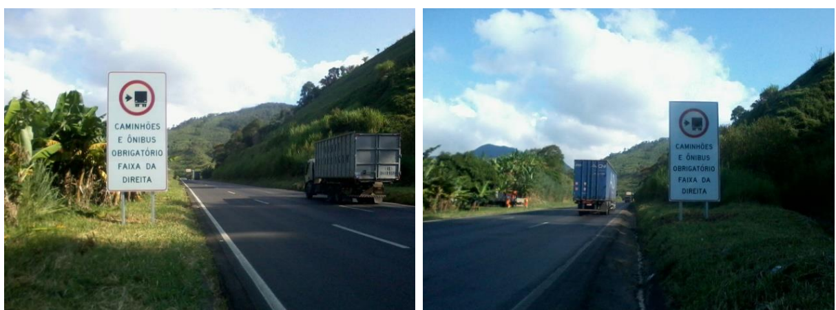
Figura 98. Implantação das placas C-2 (R-27 composta) no km 514+100 – bordo esquerdo e bordo direito
