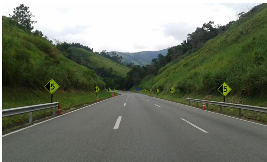
Figura 95. Implantação dos marcadores de alinhamento numerado (MAN) no km 510+776
