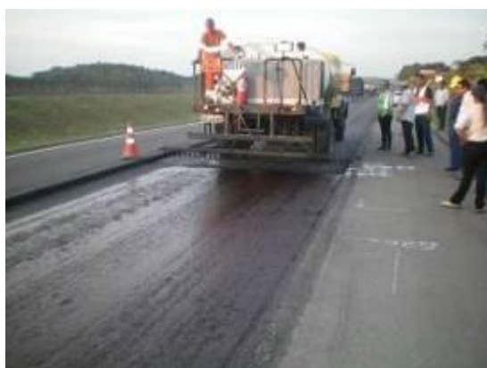
Figura 30. (a) Limpeza da faixa fresada e (b) Aplicação da pintura de ligação
