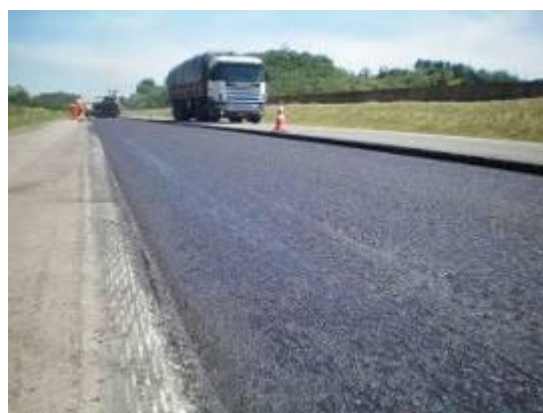
Figura 30. (a) Limpeza da faixa fresada e (b) Aplicação da pintura de ligação
