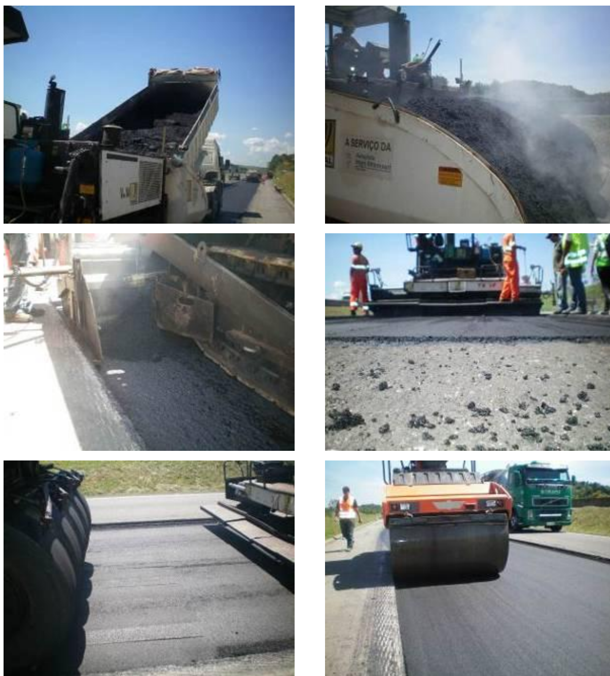
Figura 31. Lançamento e compactação do SAMI
