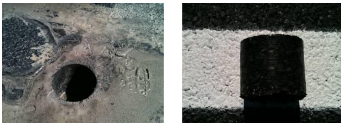
Figura 34. Extração de corpos de prova após o término da obra
