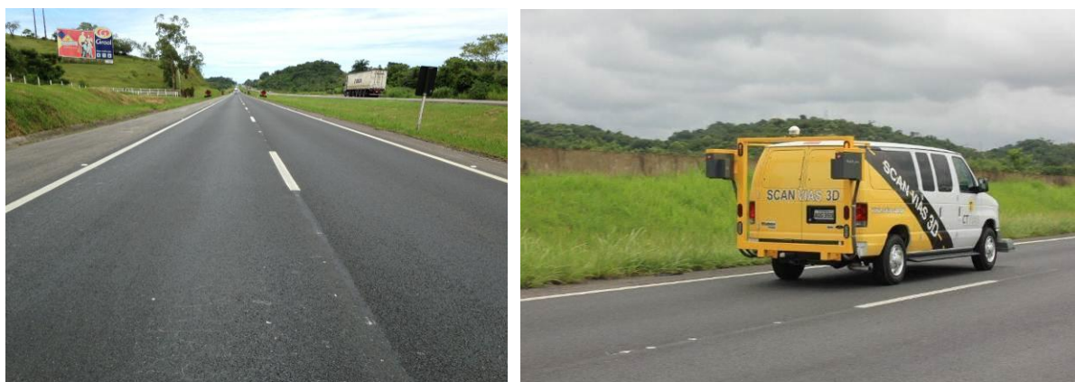
Figura 57. Condições funcionais avaliadas nas duas faixas de tráfego com equipamento específico no trecho experimental
