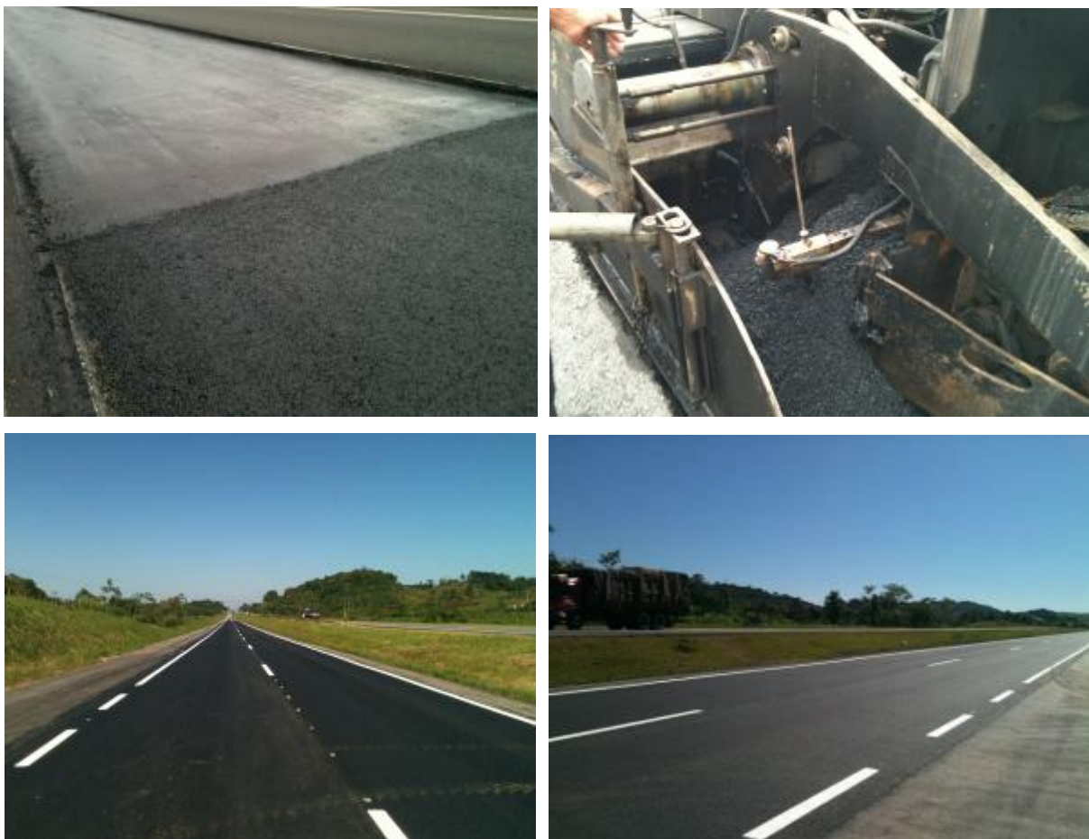
Figura 33. Execução da camada de revestimento e vista do Trecho experimental após a conclusão da obra
