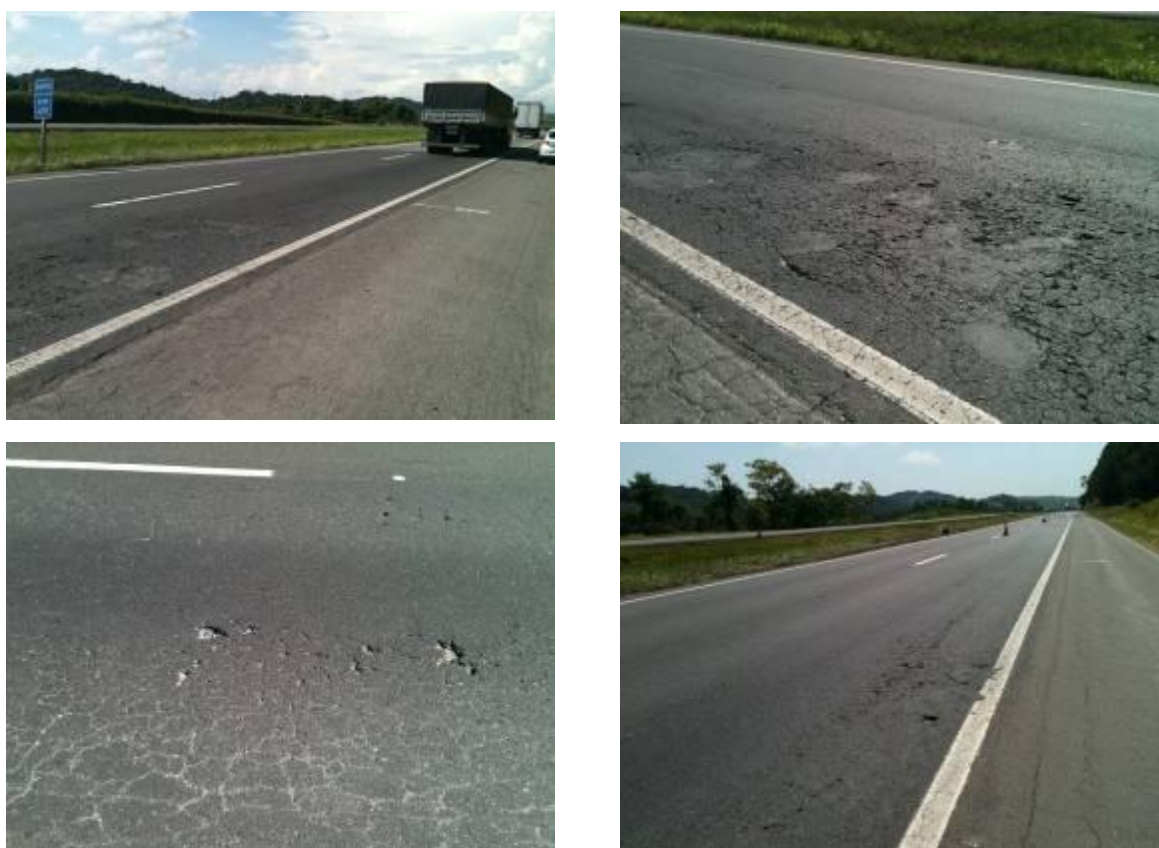
Figura 26. Condição do trecho experimental antes do início da obra
