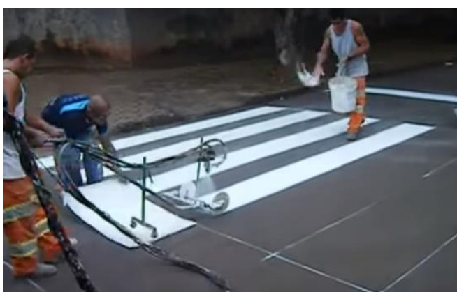
Figura 21 – Microesfera sendo adicionado a película.
