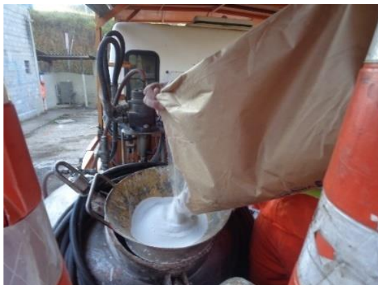
Figura 19 - Microesfera do Tipo I-B “Premix” sendo adicionada no reservatório
