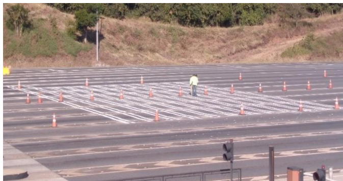
Figura 53 – Local de execução do trecho experimental
