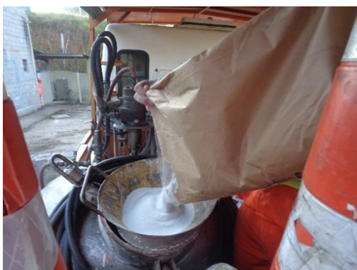
Figura 55 – Microesferas Premix sendo adicionadas a ao cilindro de tinta.
