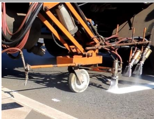
Figura 20 – Microesfera sendo aplicada por dupla aspersão
