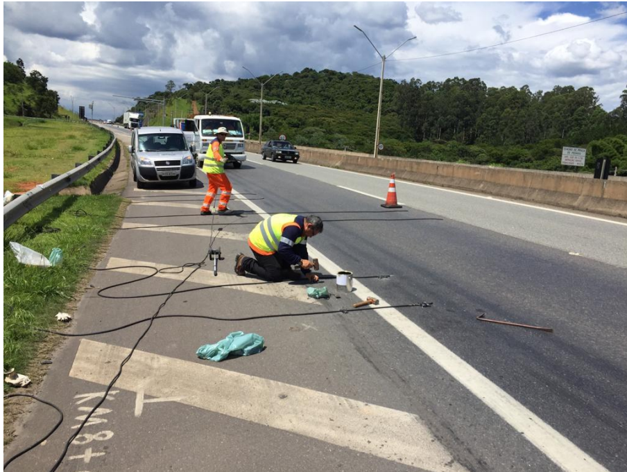
Figura 46 - Instalação dos sensores no segmento de curva
