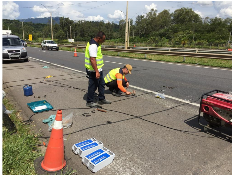
Figura 40 - Processo de instalação dos sensores
