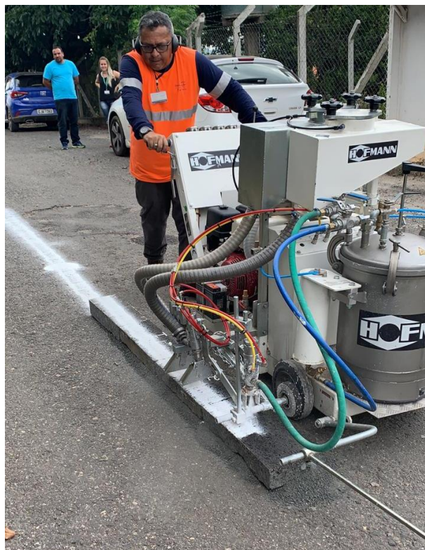
Figura 80 – Placas durante a pintura da sinalização
