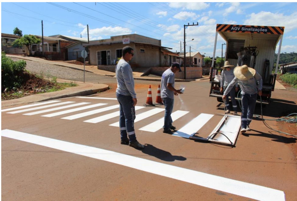
Figura 11 - Aplicação manual de sinalização horizontal em faixa de pedestre.
