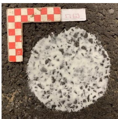
(a) SMA recém construído
