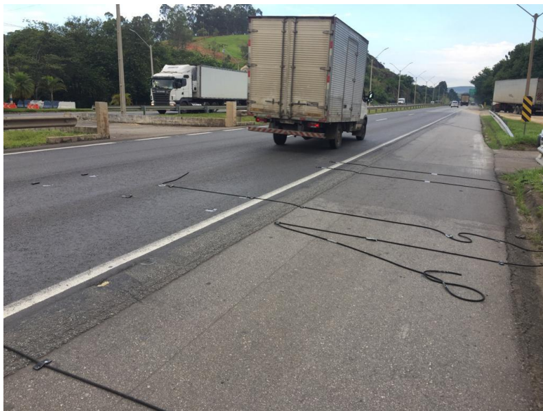
Figura 44 - Sensores soltos na pista após segundo ato de vandalismo
