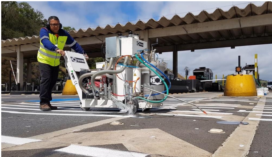
Figura 14 - Equipamento portátil para execução de sinalização horizontal aplicando a pintura em campo.
