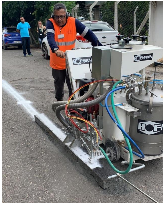
Figura 15 - Equipamento portátil para execução de sinalização horizontal aplicando em placas extraídas de campo.
