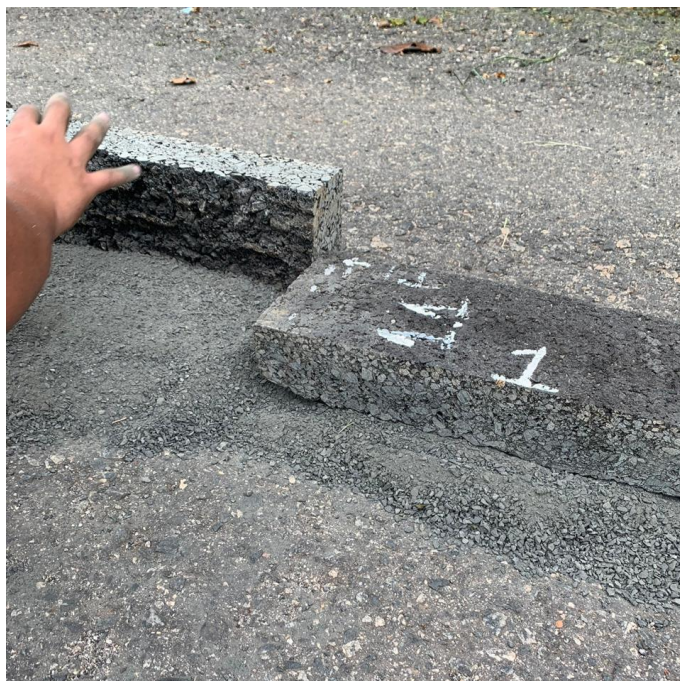
Figura 79 – Processo de nivelamento das placas
