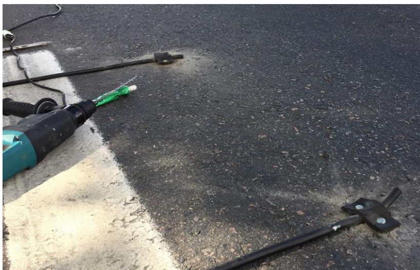
Figura 37 - Detalhe da fixação durante a instalação dos tubos dos sensores
