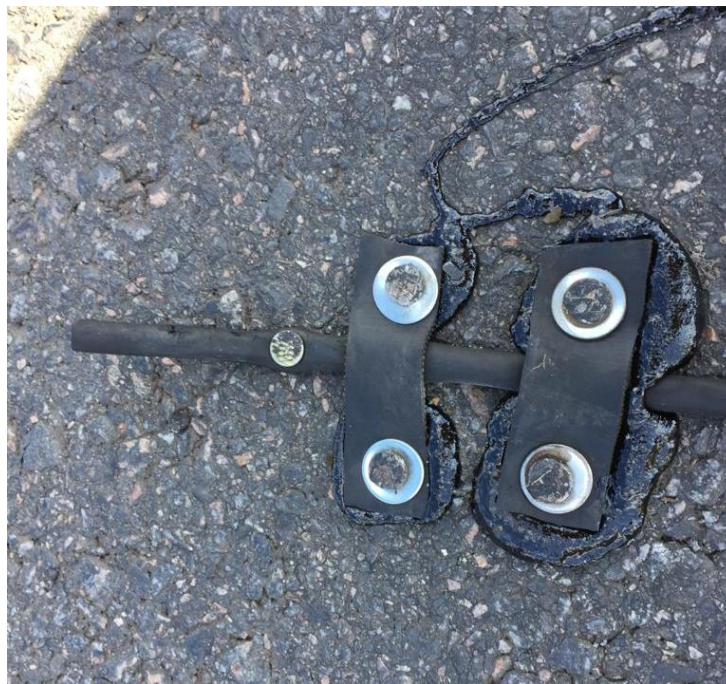
Figura 47 - Detalhamento da utilização de Ligante Asfáltico Modificado por Polímero na fixação dos sensores ao pavimento
