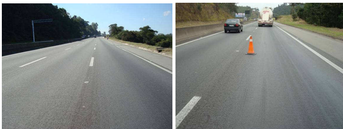
Figura 7.6 - Condição dos Pavimentos Após as Obras de Recuperação
