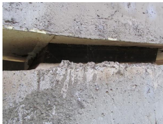
(b) Apoio sobre o pilar P4B
