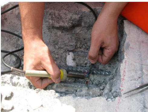
(g) Soldagem do cabo elétrico
