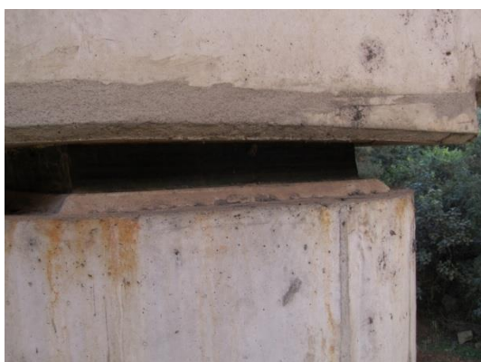
(b) Apoio sobre o pila P4B
