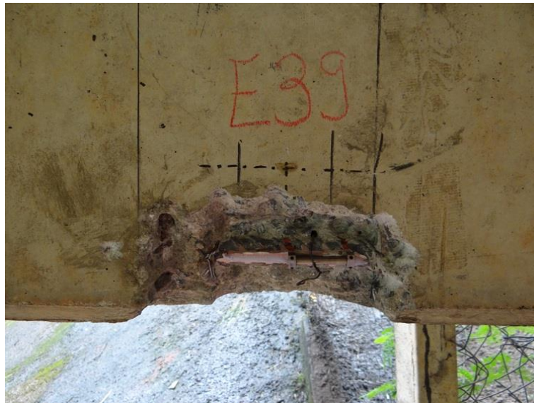
Figura D.40 – Armadura exposta com a superfície da armadura regularizada e gabarito do transdutor de corda vibrante posicionado.
