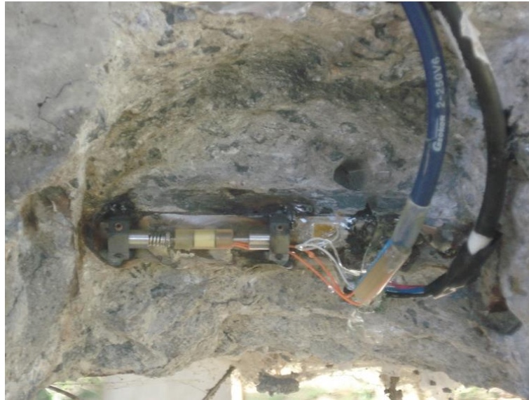
Figura D.42 – Transdutor de deformações de corda vibrante (direita) e extensômetro elétrico instalados.
