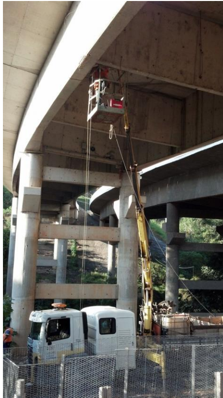
Figura D.49 – Caminhão Munck com gaiola para acesso à parte interna da viga.
