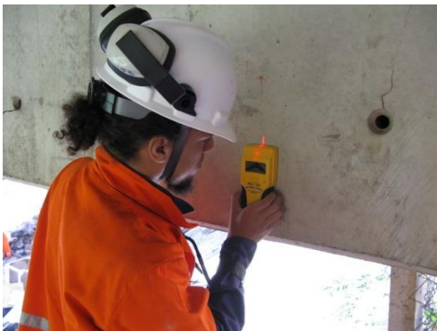
(a) Verificação da posição das barras
