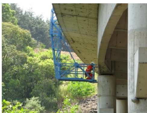
Figura B.1 – Plataforma metálica de acesso a viga e o topo dos pilares.
