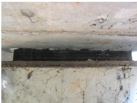
(a) Apoio sobre o pilar P3B
