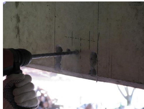
(b) Remoção da camada de cobrimento
