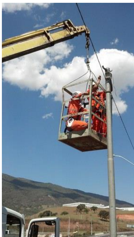
Figura D.58 – Procedimento de instalação da câmera de tráfego.
