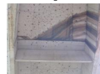
Figura A.28 – Panorama de fissuração: vista do tabuleiro entre os pilares P2 e P3.
