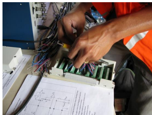
(b) Conexão dos cabos elétricos
