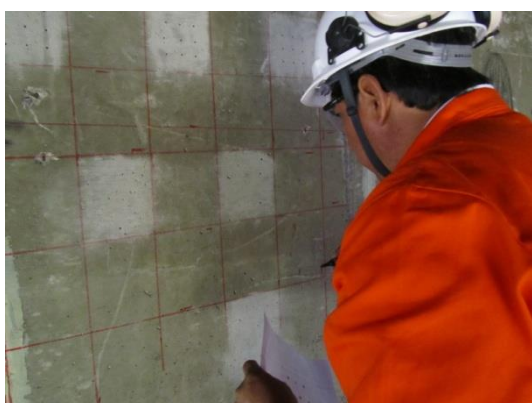
(a) Mapeamento da armadura
