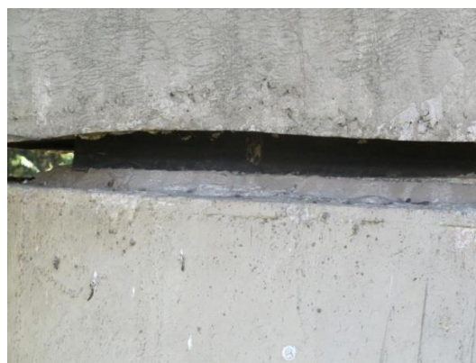
(b) Detalhe do aparente esmagamento
