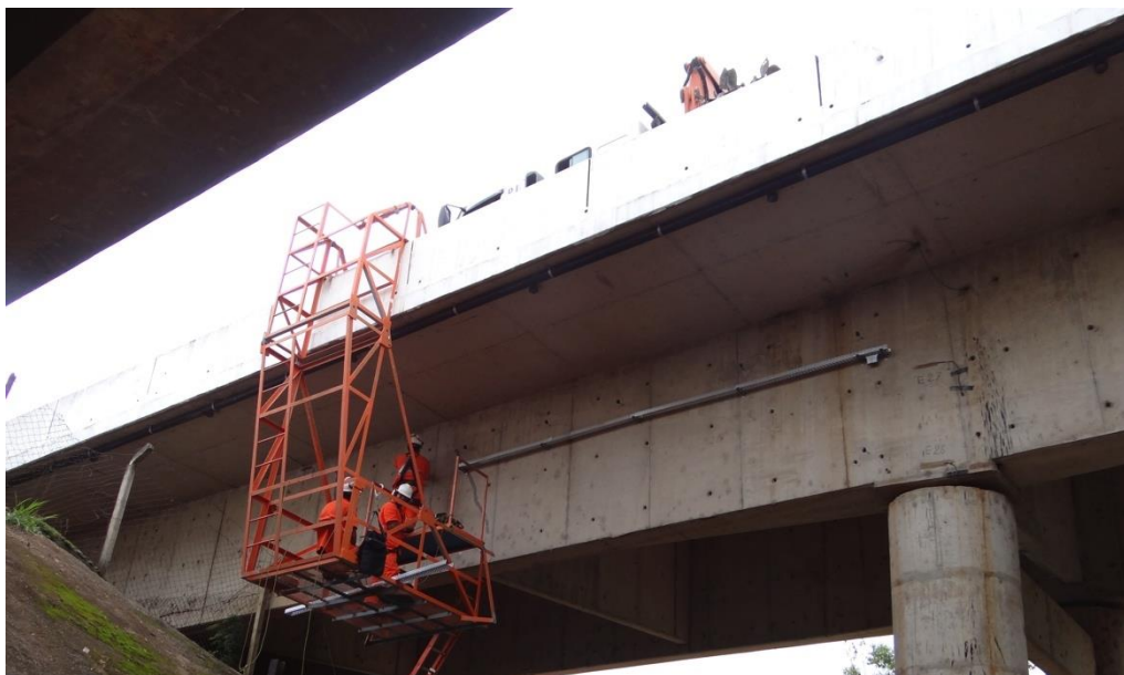
Figura D.53 – Instalação das eletrocalhas na lateral das longarinas.
