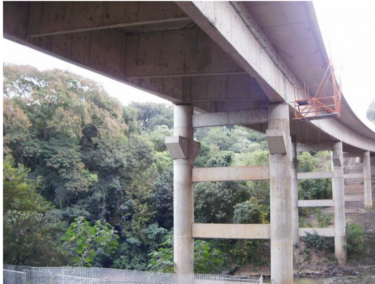
Figura D.55 – Vista das eletrocalhas instaladas.
