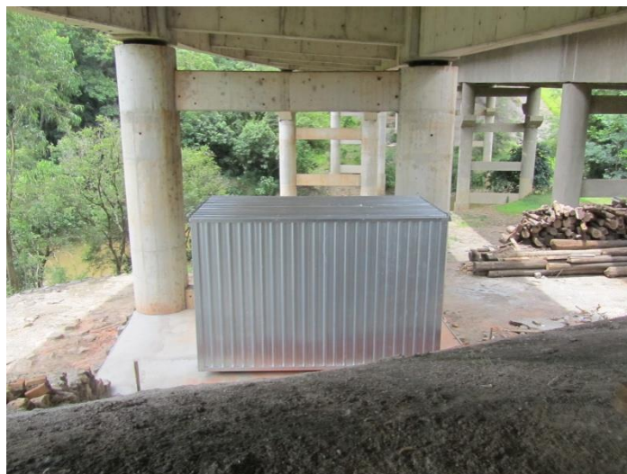
Figura D.23 – Container instalado para a central de monitoramento.
