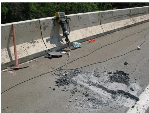
(a) Remoção do pavimento
