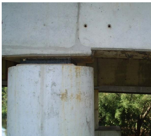
(a) Apoio sobre o pila P3B
