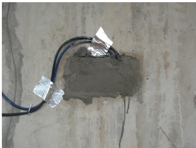
Figura D.44 – Resultado final do reparo ao cobrimento removido.
