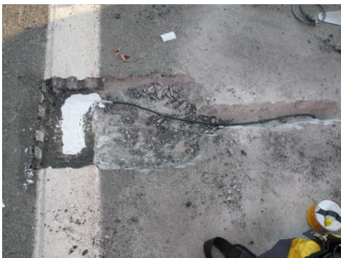
(g) Proteção contra a umidade
