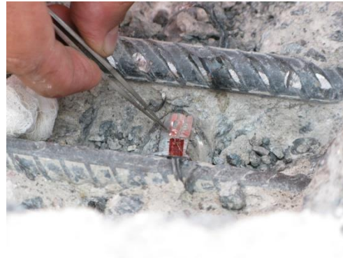
(f) Colocação da esteira de proteção
