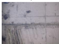
Figura A.28 – Panorama de fissuração: vista do tabuleiro entre os pilares P2 e P3.
