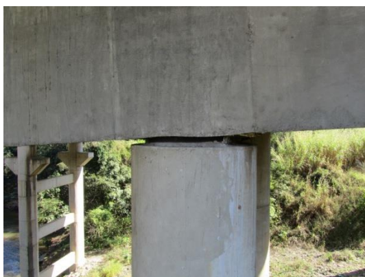
(a) Apoio sobre o pilar P2A
