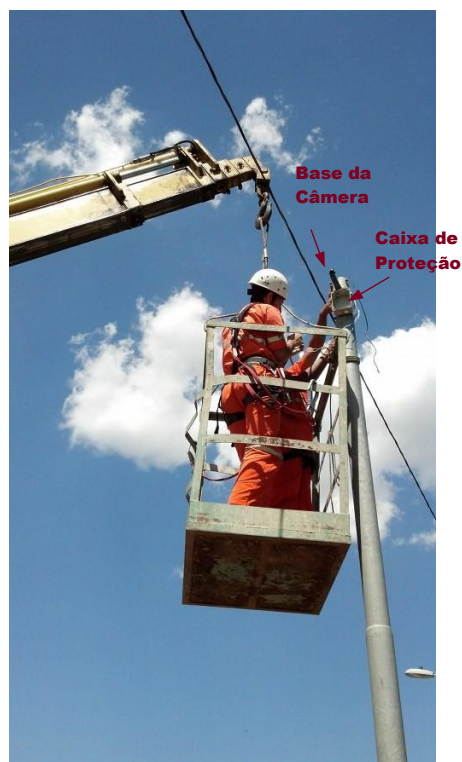
Figura D.58 – Procedimento de instalação da câmera de tráfego.
