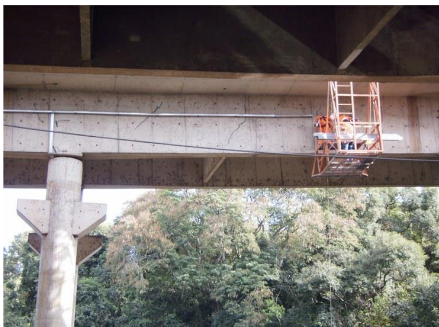
Figura D.54 – Instalação das eletrocalhas na lateral das longarinas.
