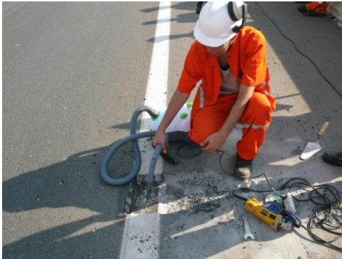
(c) Limpeza da superfície
