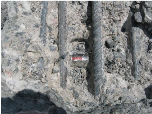
(e) Extensômetro colado na barra
