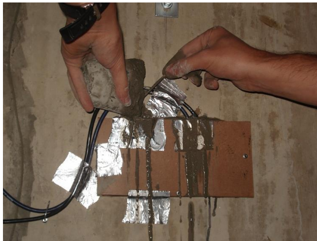
Figura D.43 – Fechamento da abertura do cobrimento do concreto.
