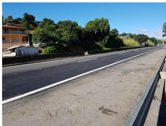
Figura 55. Novo segmento 1 do trecho experimental recém executado
