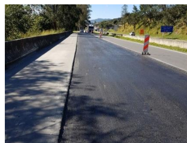
Figura 59. Imprimação da camada de BGTC: (a) uso da caneta espargidora, (b) uso da barra espargidora e (c) aparência da BGTC após a imprimação
