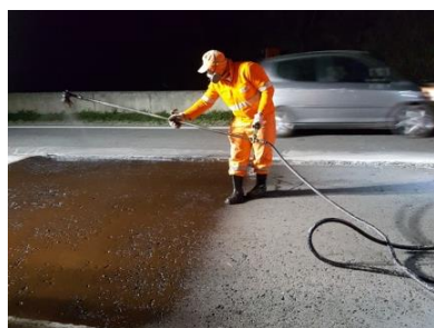
Figura 59. Imprimação da camada de BGTC: (a) uso da caneta espargidora, (b) uso da barra espargidora e (c) aparência da BGTC após a imprimação
