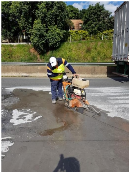
Figura 72. Corte do pavimento para a colocação dos sensores: (a) corte do pavimento para passagem do cabeamento, (b) corte do pavimento para colagem dos sensores, (c) cortes finalizados e (d) cortes longitudinais para instalação dos sensores
