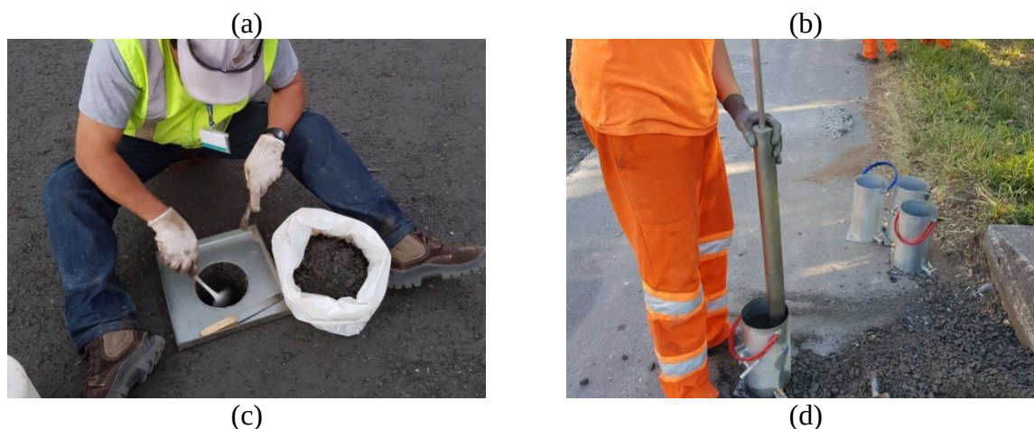
Figura 61. Aplicação da camada de brita + RAP + cimento: (a) espalhamento do material, (b) compactador de rolo liso, (c) produção de corpos de prova e (d) ensaio de frasco de areia
