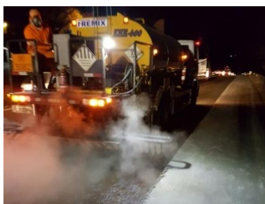
Figura 59. Imprimação da camada de BGTC: (a) uso da caneta espargidora, (b) uso da barra espargidora e (c) aparência da BGTC após a imprimação
