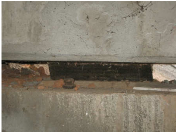
Figura 2 - Vista lateral do aparelho de apoio do pilar P6B.
