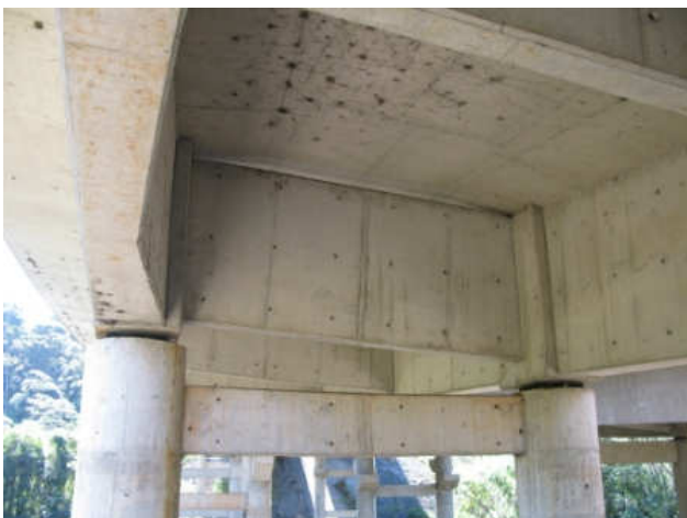
Figura 13 - Laje acima dos pilares P5A e P5B apresenta boa conservação.
