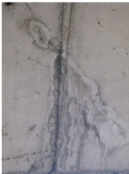
Figura 9 - Lado interno da longarina V2, próximo à transversina TR13 e ao pilar P4B.
