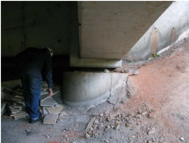
Figura 11 - Pilar P6B (enterrado).
