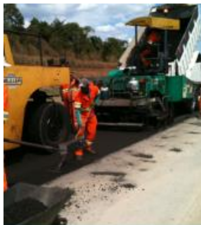
Figura 20 – Compactação da camada reciclada com emulsão
