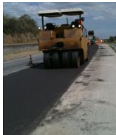
Figura 20 – Compactação da camada reciclada com emulsão
